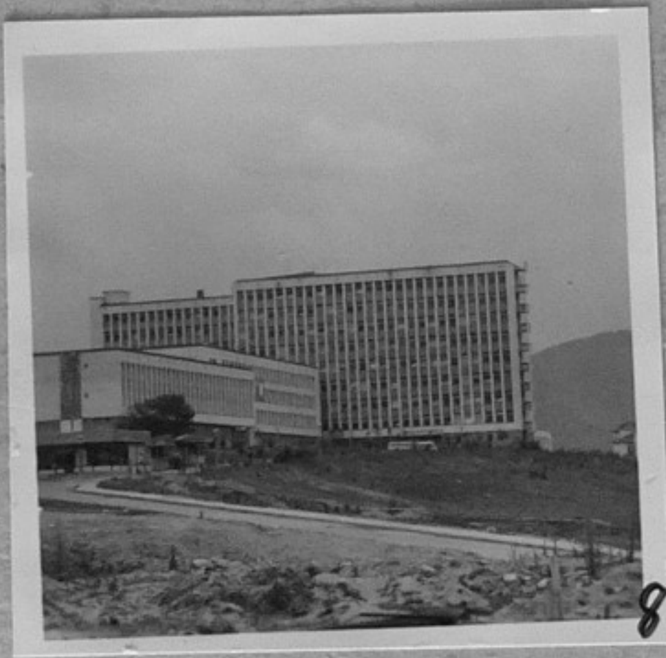
77-2291-8-Сградата на новата окръжна болница. /Р.Сотирова/ЛА
