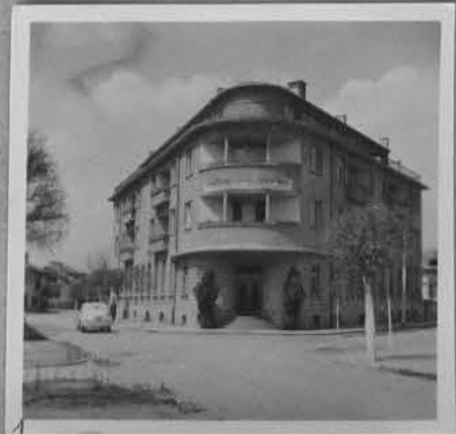
58/1287-1-Почивната станция на работниците по транспорта в Кростендил. /Миронски/ ЕИ
