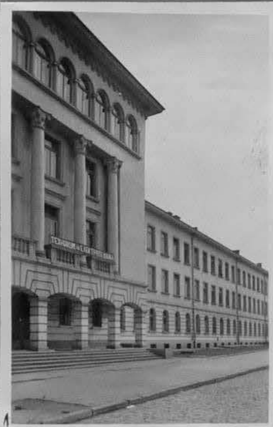
63/761-1-Техникум по електротехника, Русе. /Парушев/ ИИ
