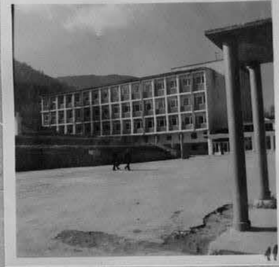
71-811-11-Строителният техникум в кв. Устово-гр. Смолян. /Т. Хорисян/ ИК
