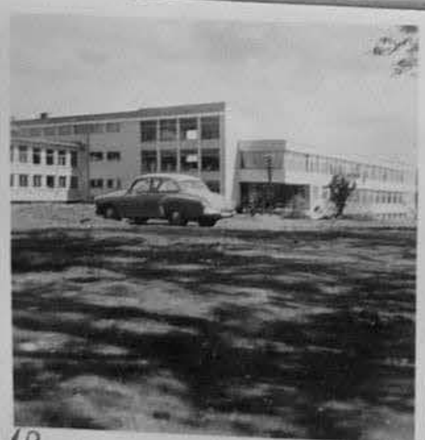
10 64/1227-10-Външен изглед на новопостроения техникум по електромеханика в Ловеч. /Божков/ ММ
