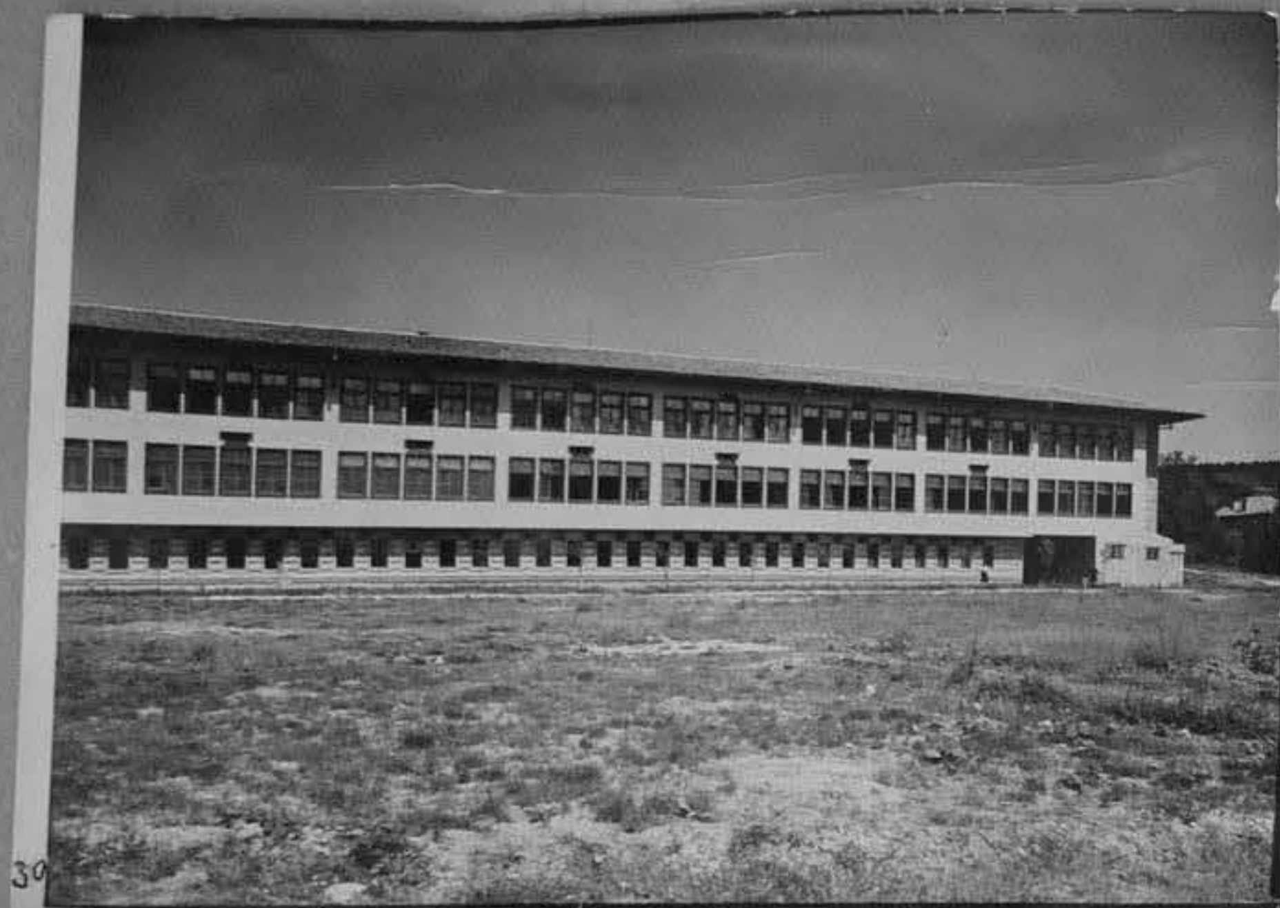
56/1296-30-Търново - строителен техникум. /Димчев/
