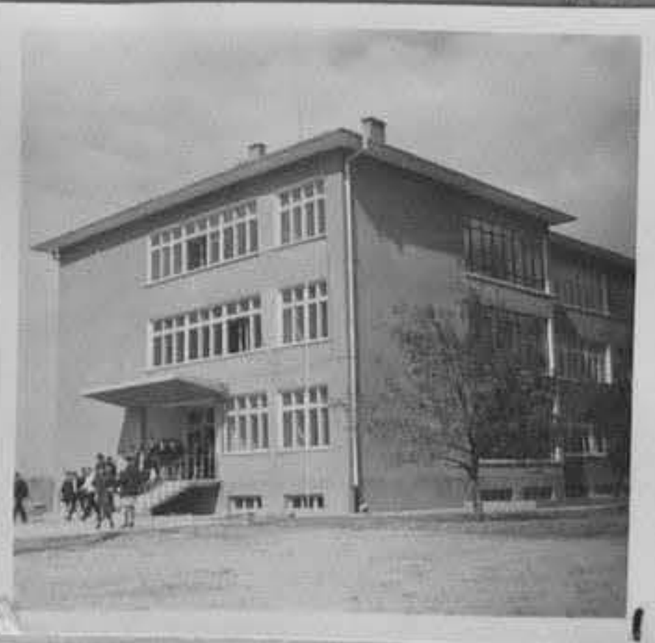
68-4582-1 - Новата сграда на училището по промишлен и енергиен монтаж в гара Гълъбово. /Кр. Арсов/ЕИ
