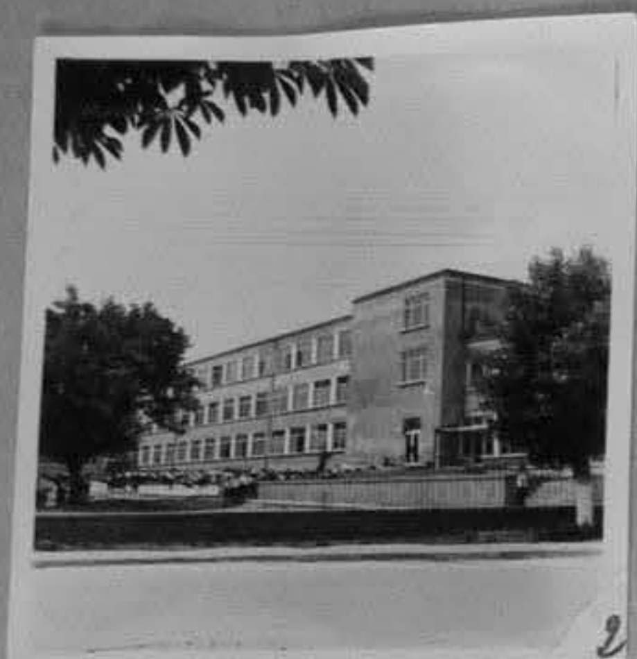
69-2239-2-Общ вид на новата училищна сграда в село Глоджево, Разградски окръг. /Н.Йорданов/ИК
