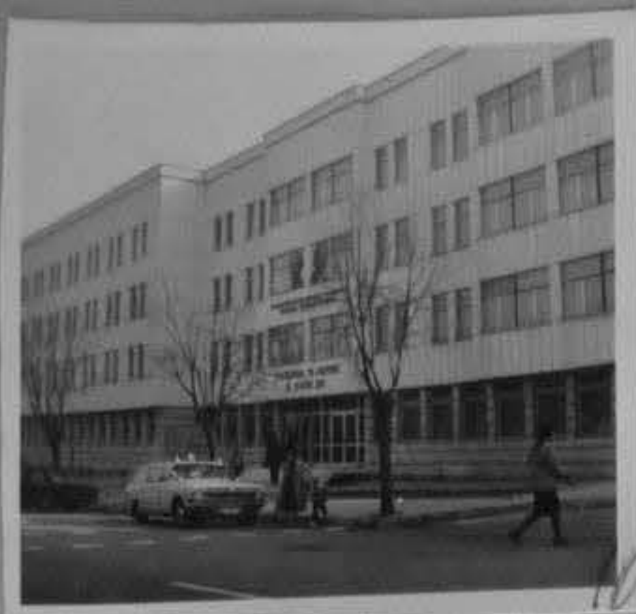
83-526-10 Част от фасадата на новата градска поликли- ника в гр Велико Търново. М. Вединова/ВЛ
