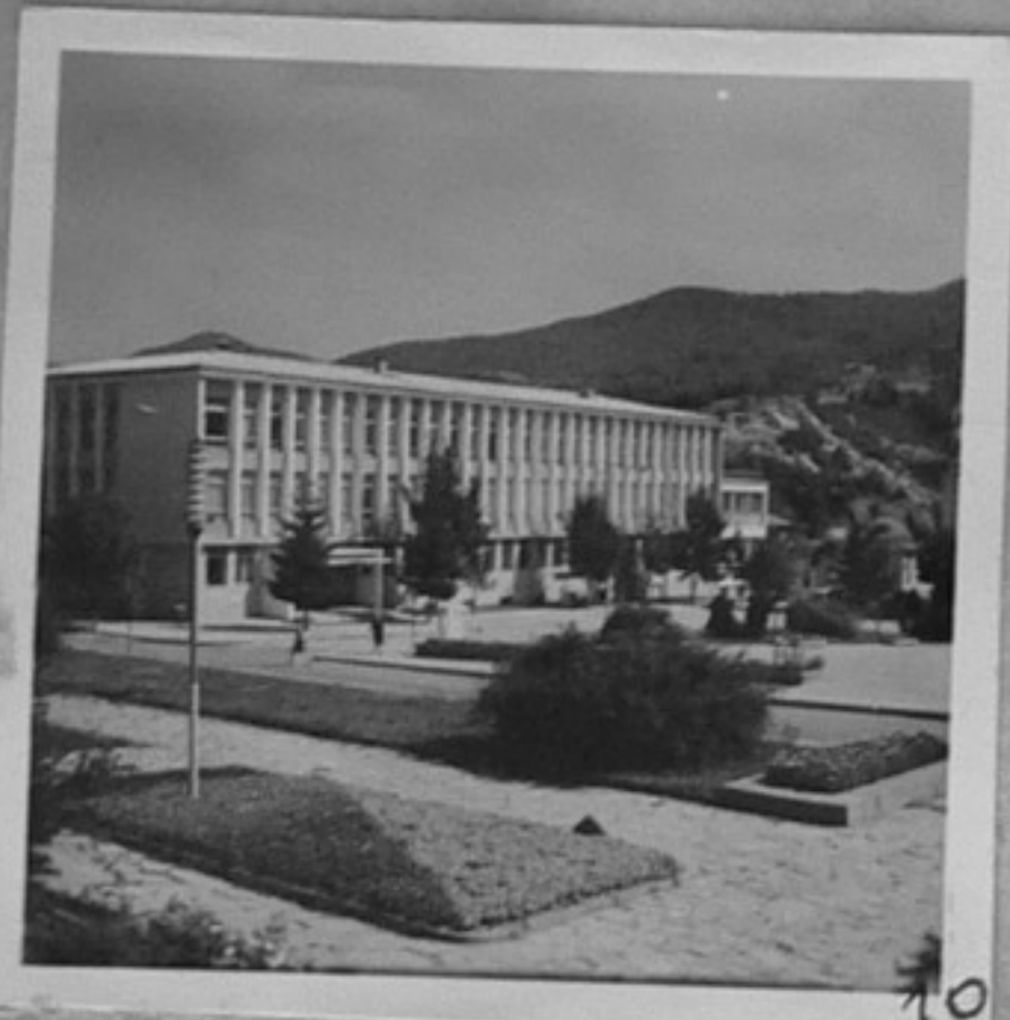
67-2675-10 - Новоремонтираната сграда на ОНС - Смолян. /Торос Хорисян/ СС
