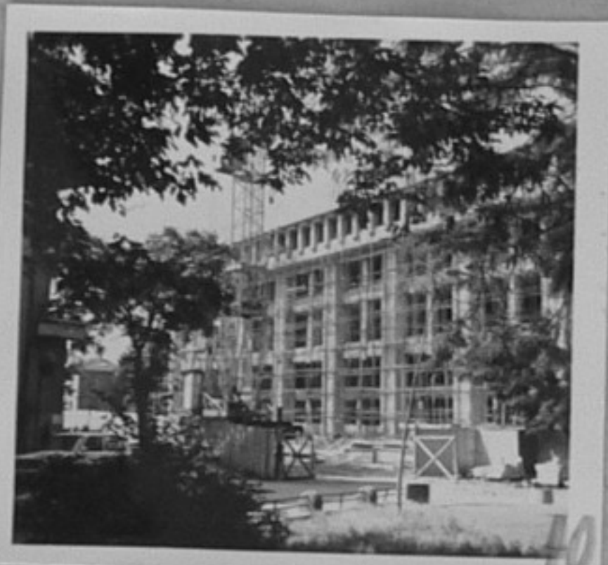
81-2220-10 Строителст- вото на новия Партиен дом М.Георгиева/Щ
