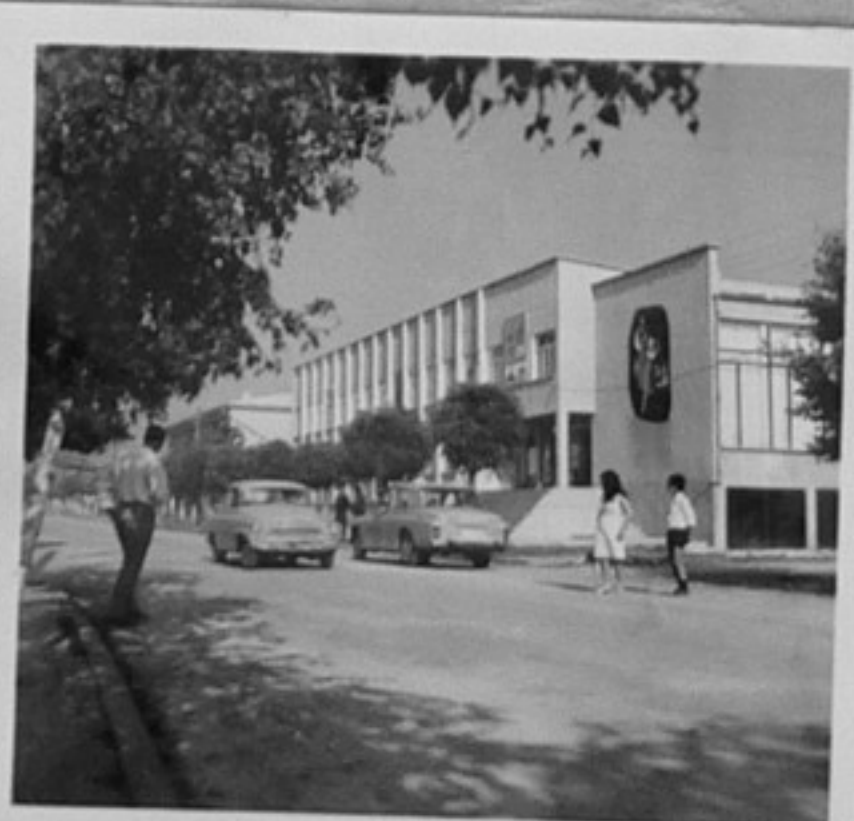
69-2842-11-Сградата на ТКЗС в с.Острово, Газградско. /М.Върбанов/ XII
