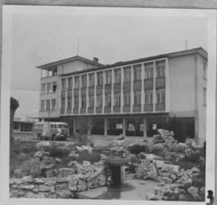
69-1480-3-с.Михалци, В.Търновски окръг. Сградата на ТКЗС. /М.Върбанов/ ИК
