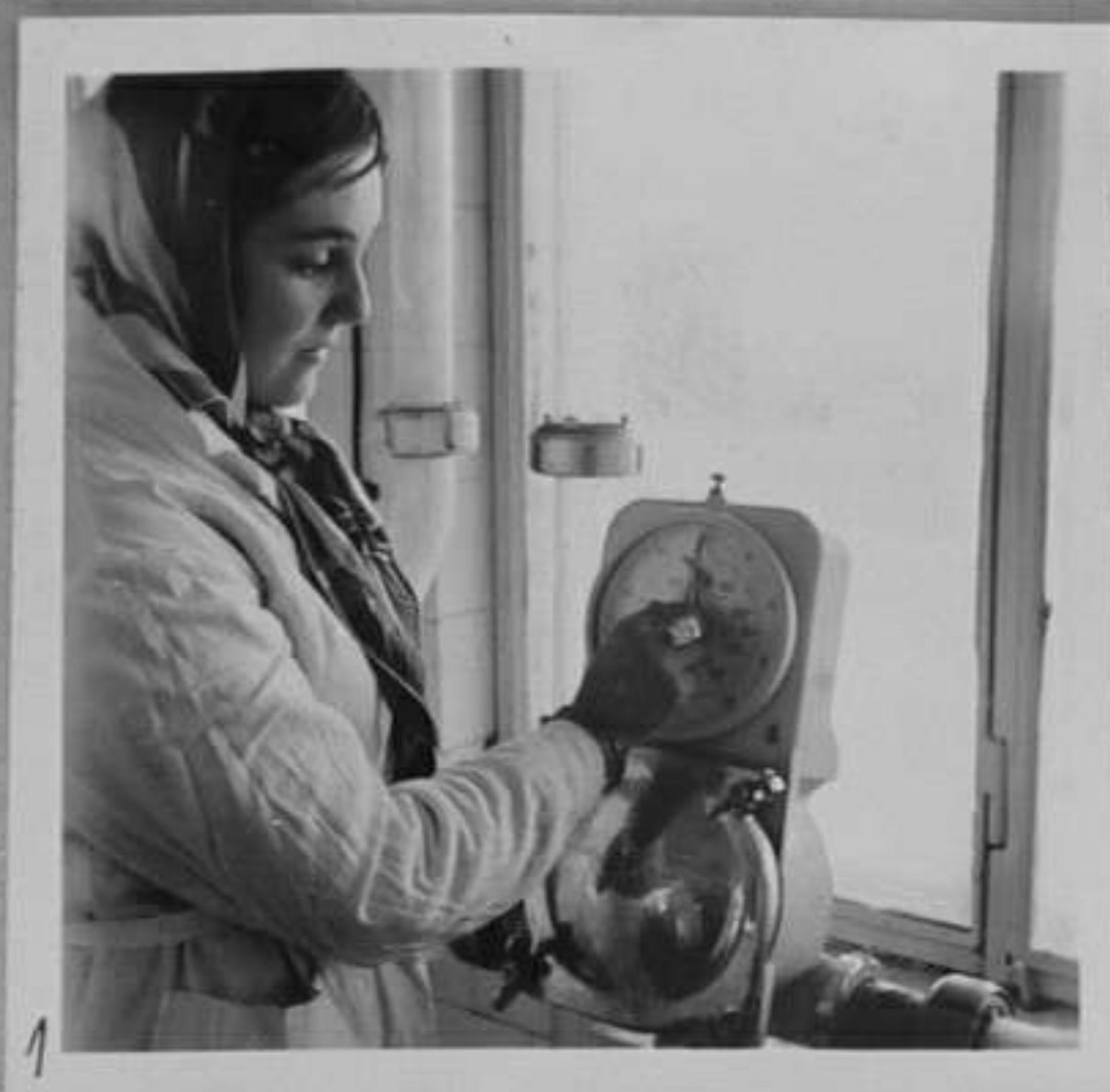
67/325-1 - Манипулация с "Кантара" - уред за измерване на приетото мляко в килограми. /Симеонов/ЕИ
