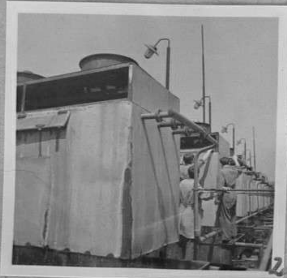
71-4166-2,3-Кондензаторен блок при хладилни машини. /Н.Хлебарова/ ХП
