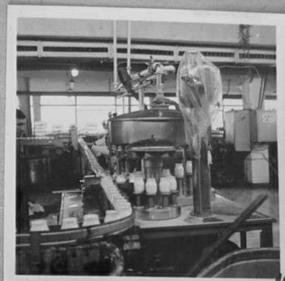
/Н.Чобанов/ МК 71-6406-10-Поточна линия за пълнене и затваряне на бур- кани с кисело мляко.
