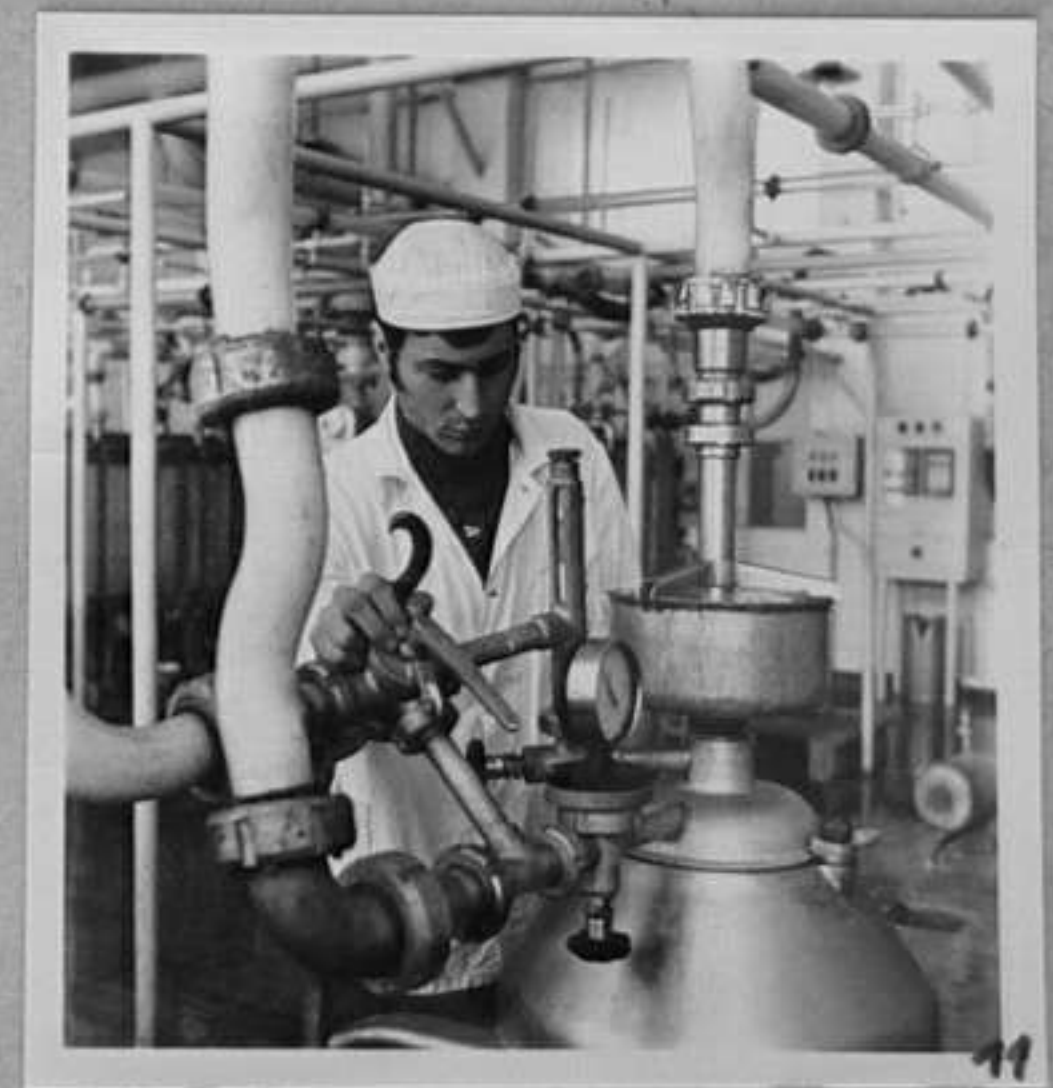
71-213-11 - Комсомолецът С.Койнов, извършва проверка на гъстотата на сметаната. /Кар.Карекинян/ XII
