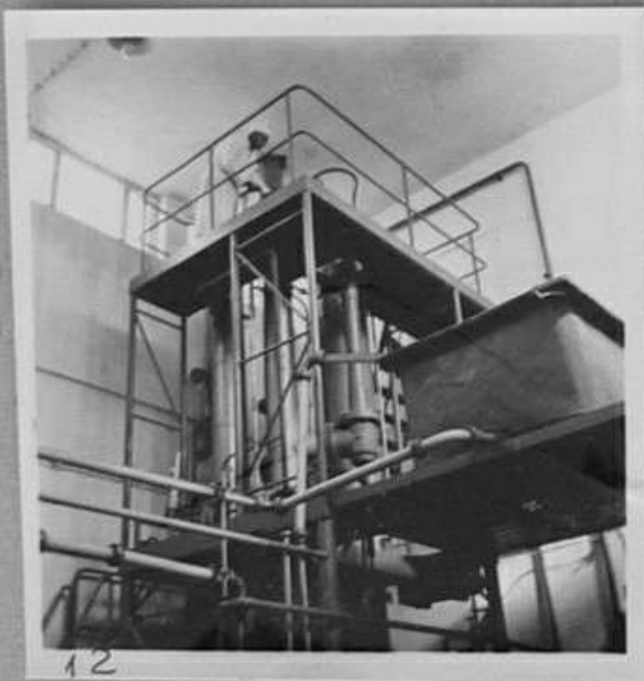
62/808-12- Тано Колев Джамбазки наблюдава вакуумния апарат за съгъване на млякото и получаване на млечен прах. /Чаръкчиев/.
