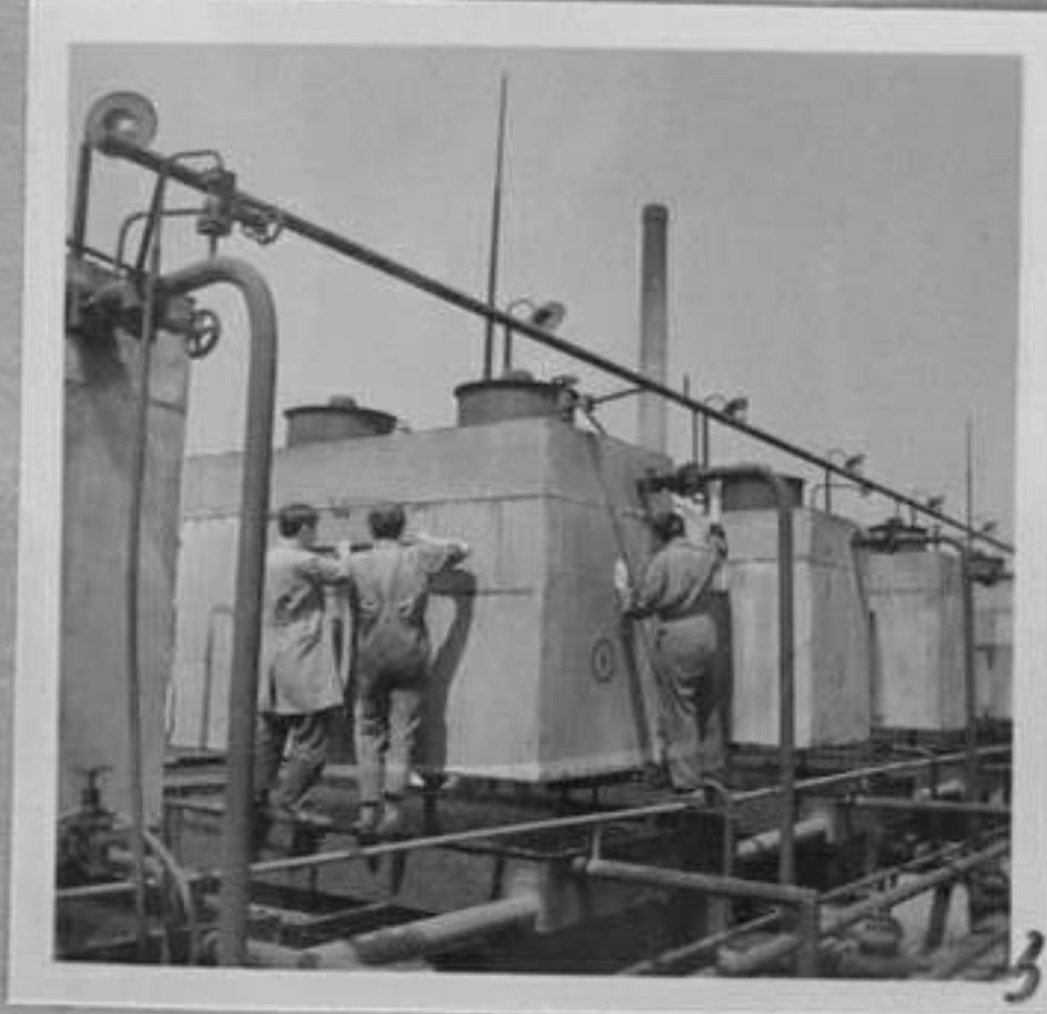
71-4166-2,3-Кондензаторен блок при хладилни машини. /Н.Хлебарова/ ХП
