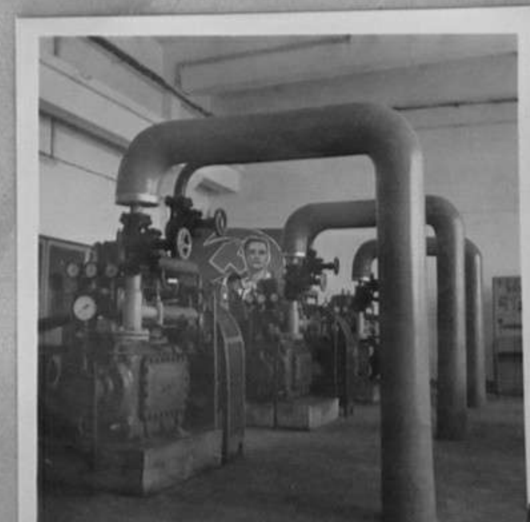
68-1230-1- Паровата централа. 68-1230-2,4- Машинна зала с компресори за хладилниците. /Радослав Парушев/, СС
