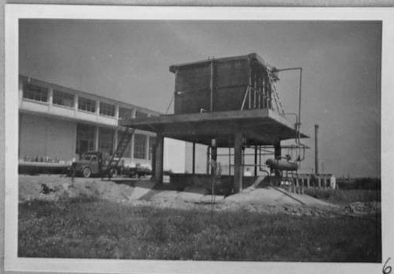
61/1834-6,7 - Оросителният кондензатор /на предния план/ и парнонапорното отделение / в дъното/. Страхинов
