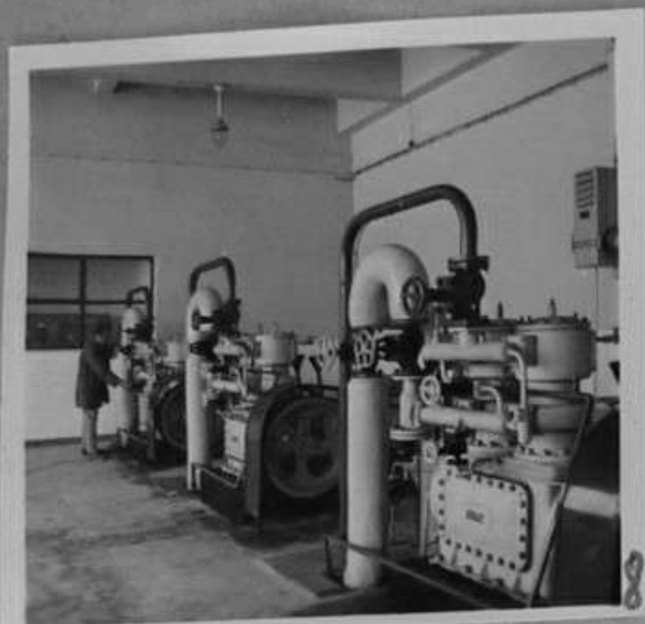
72-4510-8 - Машинна зала. /Р. Парушев/ ЭИ
