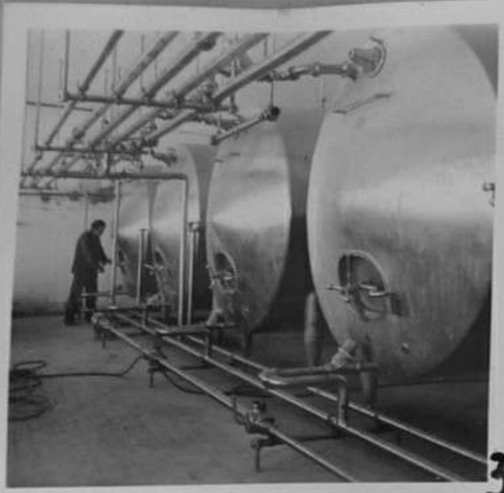
68-1706-3-А.Алипов извършва монтаж на кръвопровода към танкерите за съхранение на млякото. /И.Асенов/СС
