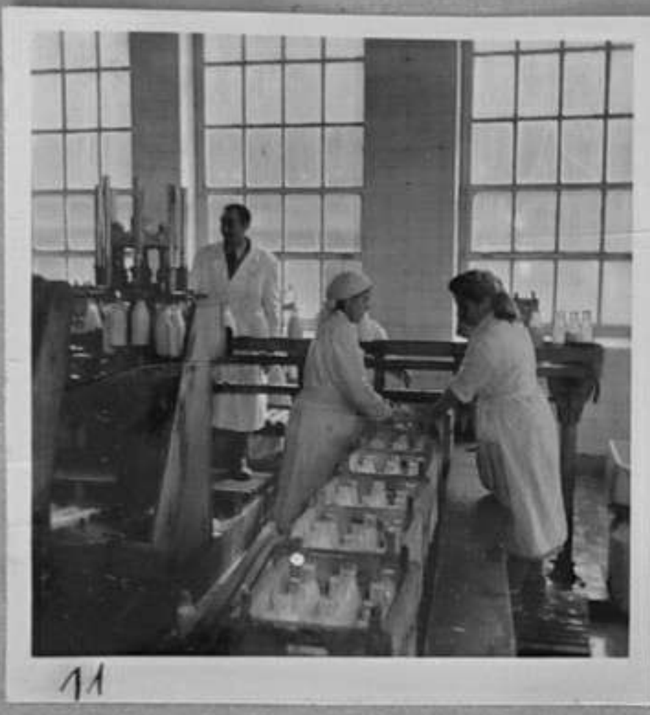
57/490-11, 12 - Машинно пълнене на едролитрови бутилки с пастъризирано мляко. /Караджанов/
