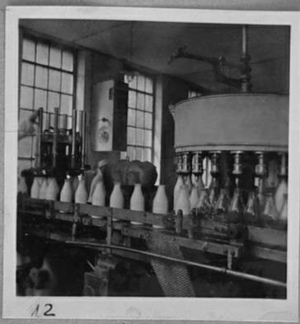
57/490-11, 12 - Машинно пълнене на едролитрови бутилки с пастъризирано мляко. /Караджанов/
