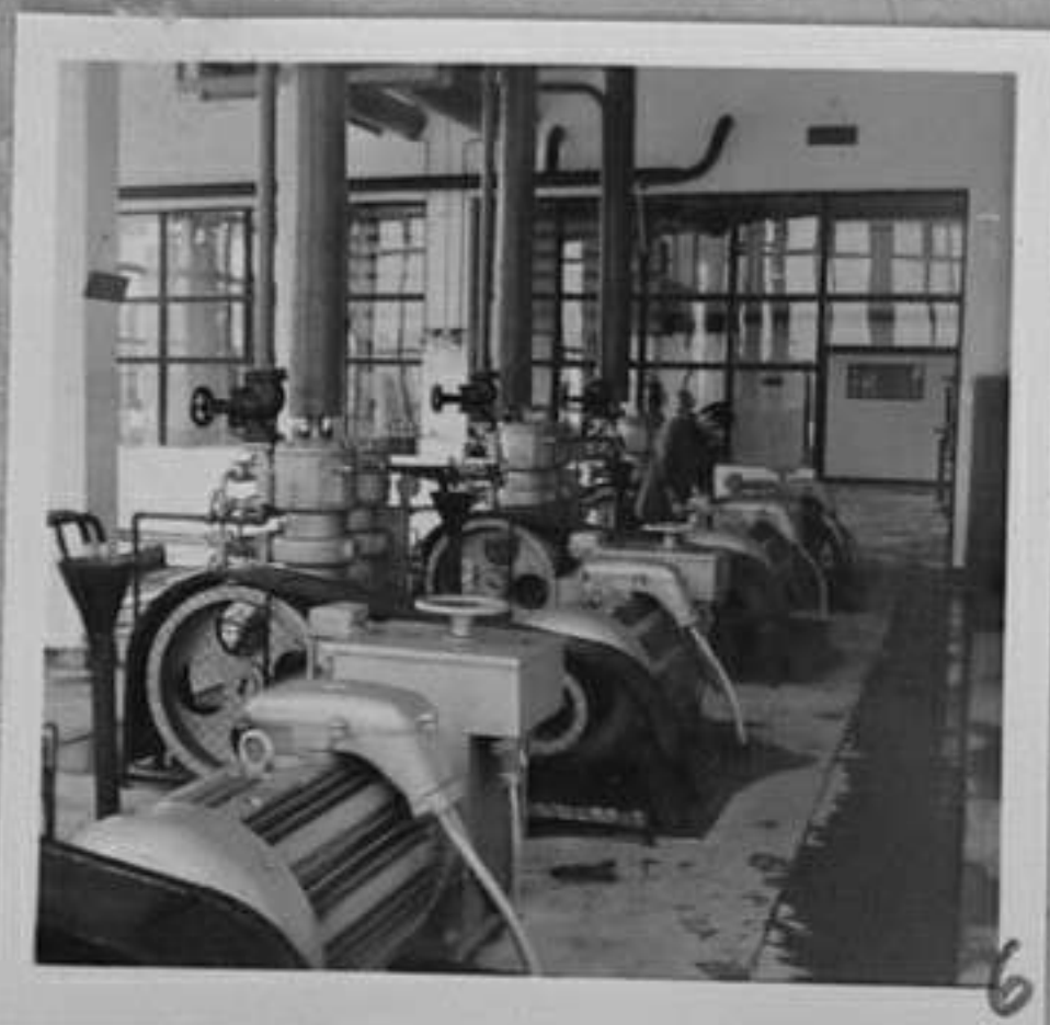
71-4336-6-Вътрешен вид на компресорното помещение на хладилника. /Е.Любомиров/ XII
