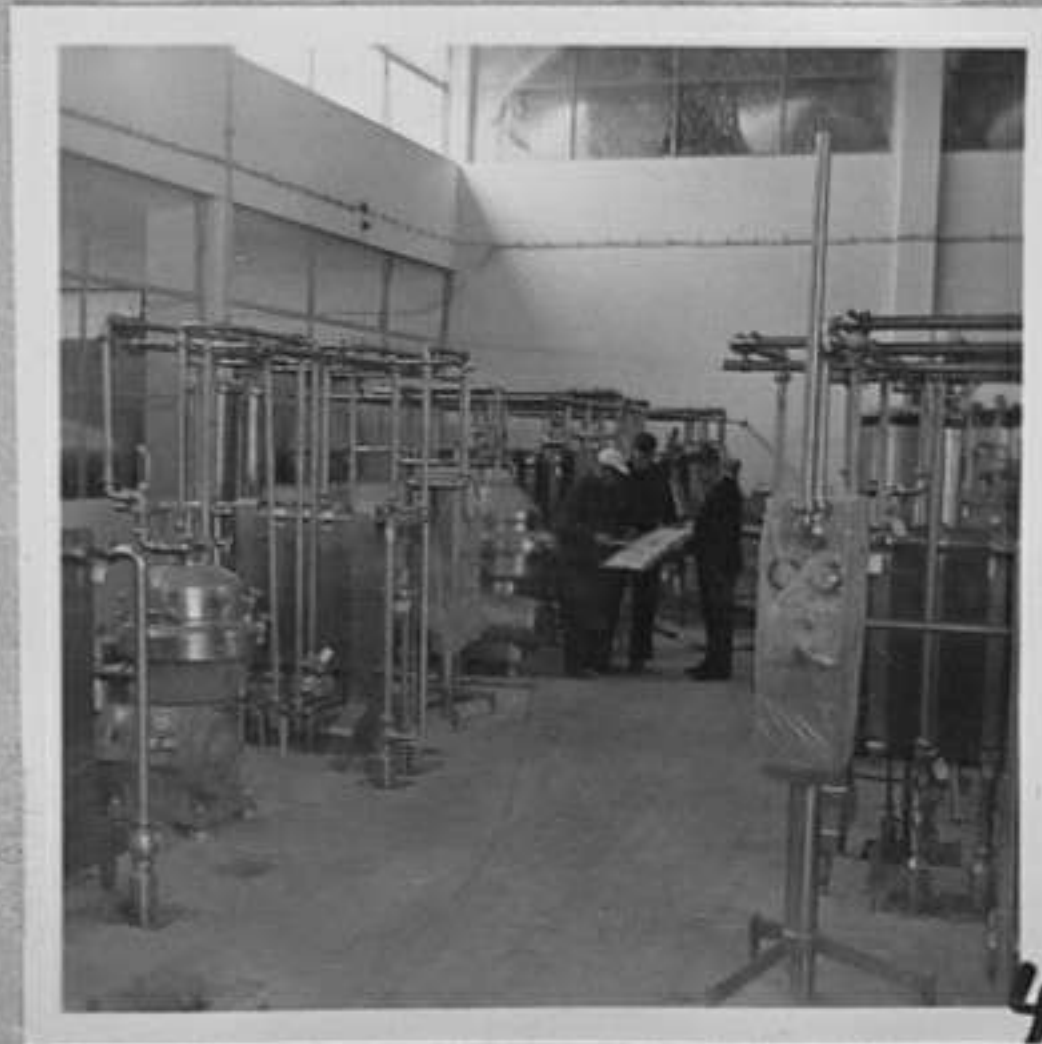
68-1229-2,4,5-Монтаж на съоръженията в цеха за пастеризиране на млякото. Монтажът се извършва под ръководството на шведски специалисти. /Р. Парушев/, СС
