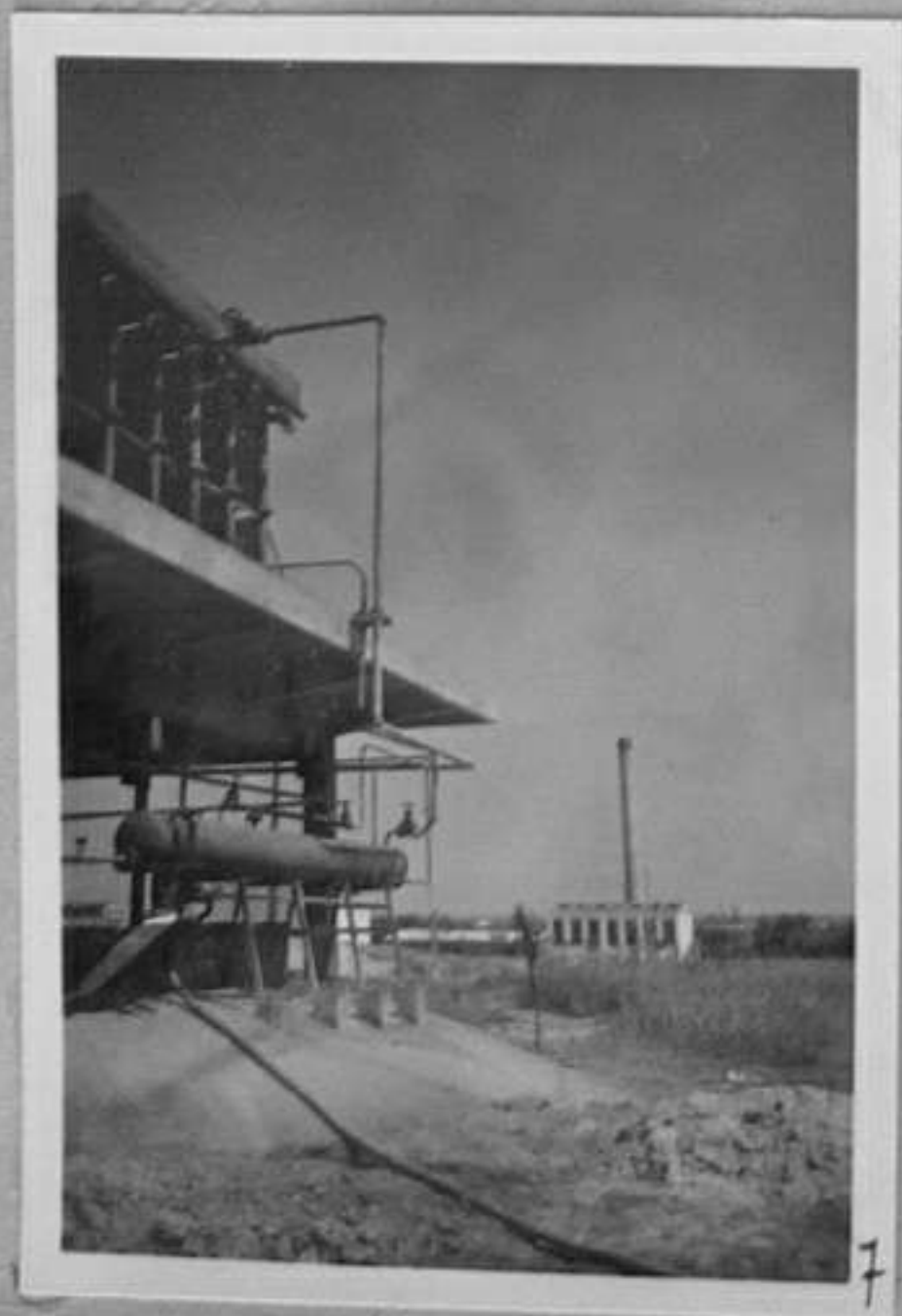
61/1834-6,7 - Оросителният кондензатор /на предния план/ и парнонапорното отделение / в дъното/. Страхинов
