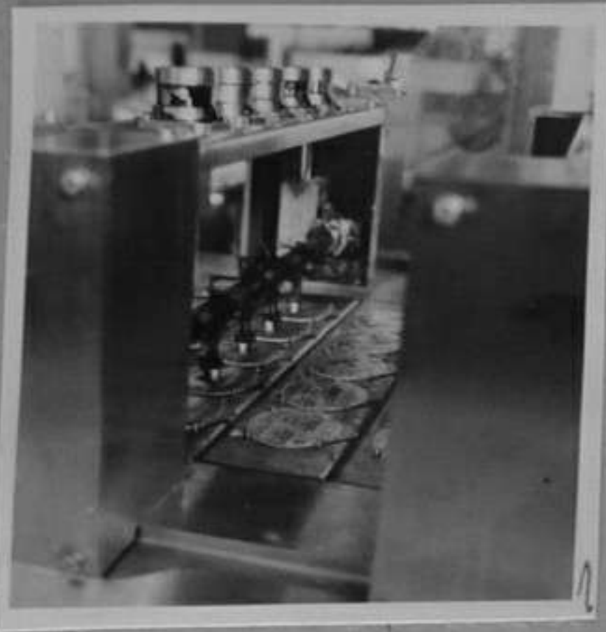
84-34-1,4-Поточна линия за производство на кисело мляко. /Е.Богоев/ЛА
