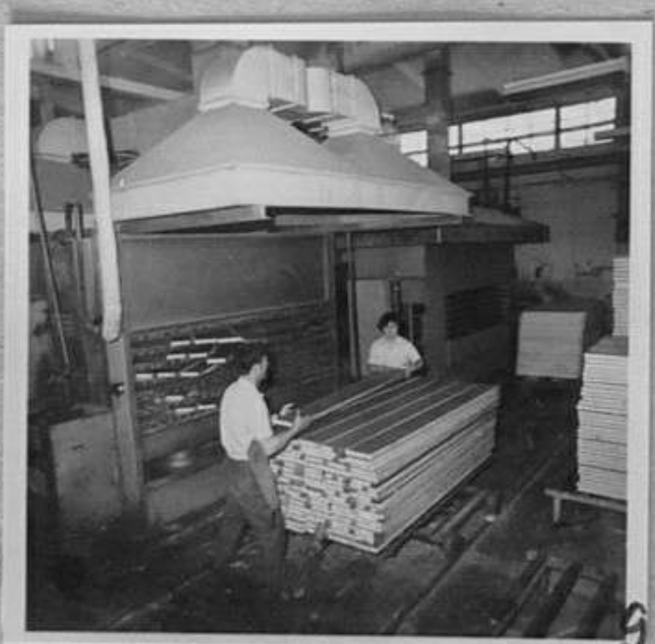
78-1733-9 Пресоване на каси и крила за врати Ан.Цанков/МД
