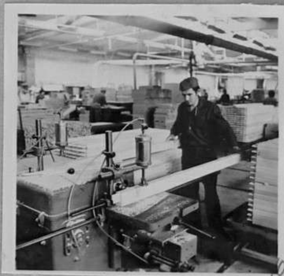
72-5550-10-По време на работа на хоризонтално осцилираща бормашина. /Н.Чобанов/ИК
