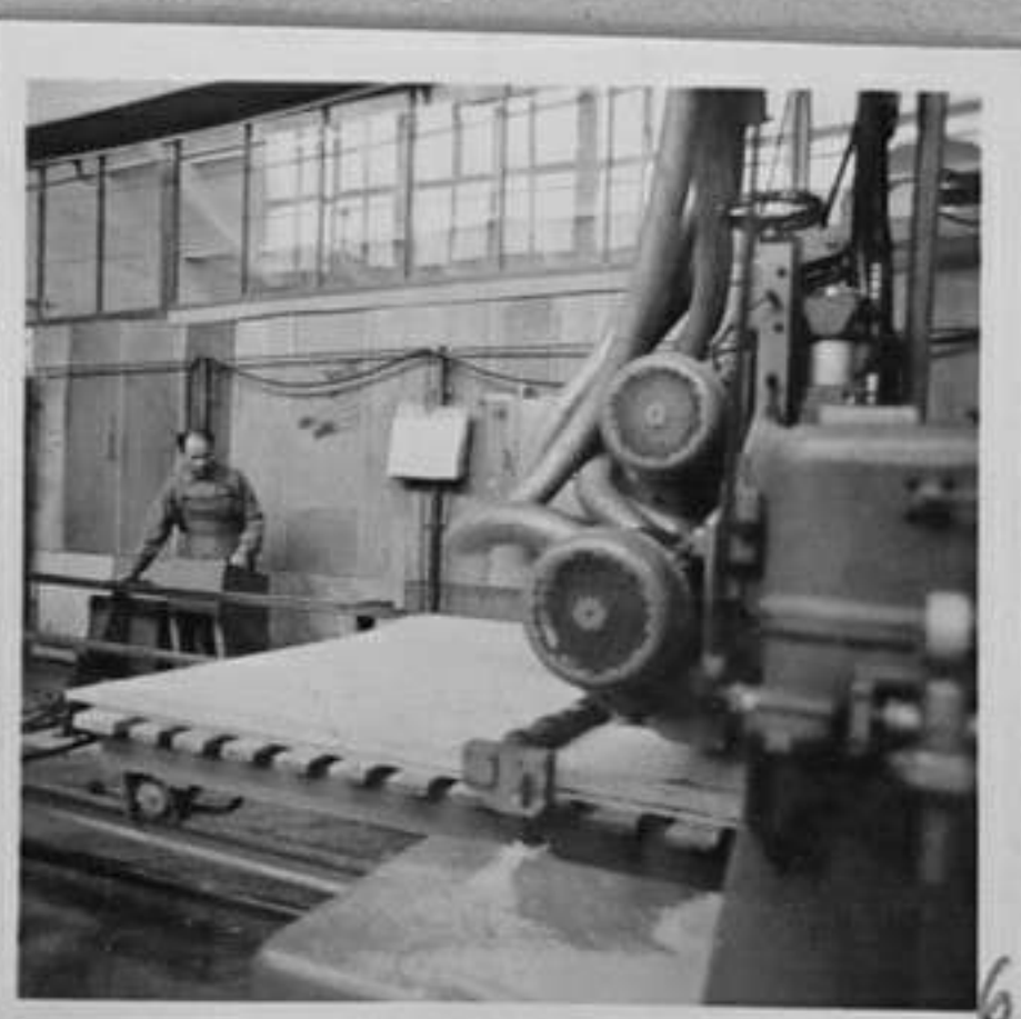
74-145-6,7-Тристанно-окрайчващ циркуляр за разкрояване на плоскости от дървесни частици. /Р.Марукян/ТК
