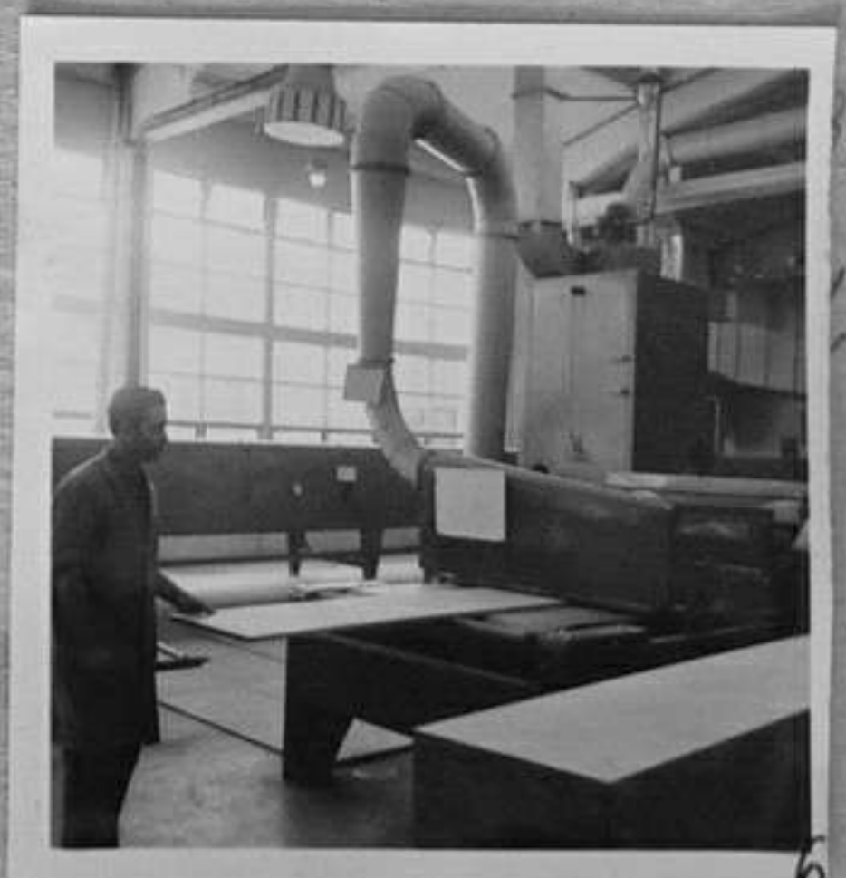
73-3061-4-6- Лакоразливна линия. /В.Иванова/ТК
