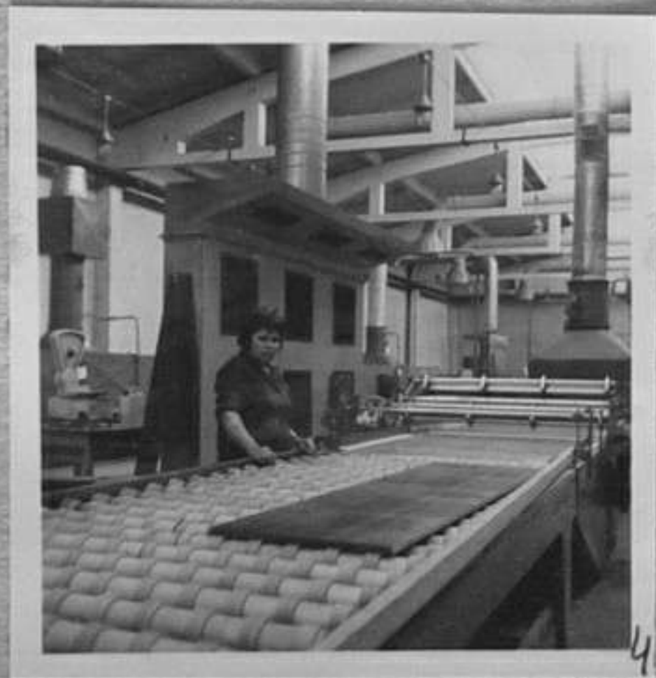
73-3061-4-6- Лакоразливна линия. /В.Иванова/ТК
