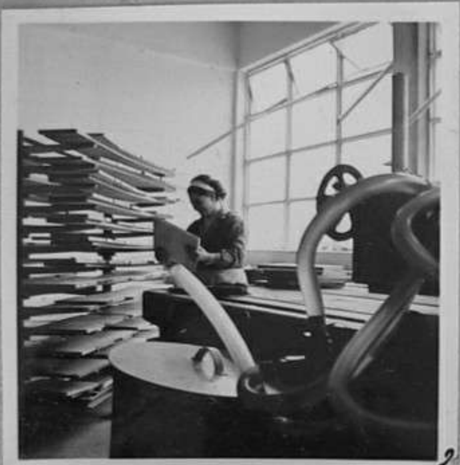
68-1657-2- Лакозаливане на мебелни детайли в промкомбината. /Здр. Минчева/СС
