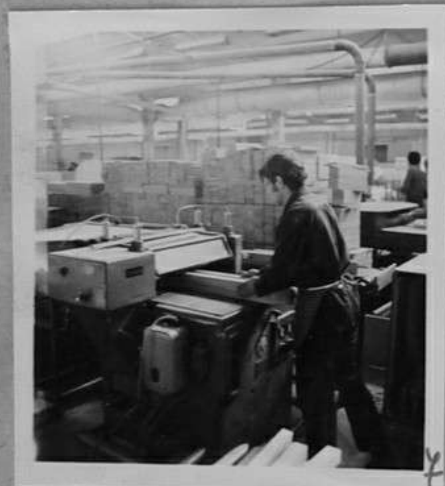
72-5550-7,9-Двуглава фреза за масивни детайли. /Н.Чобанов/ИК
