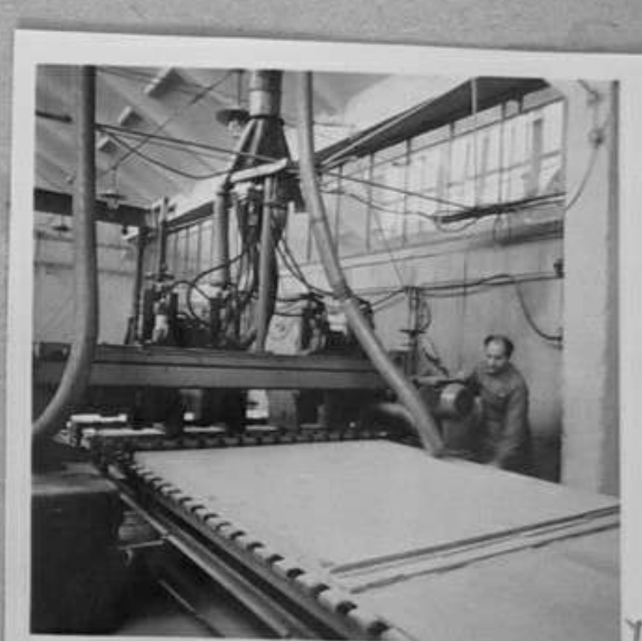
74-145-6,7-Тристанно-окрайчващ циркуляр за разкрояване на плоскости от дървесни частици. /Р.Марукян/ТК
