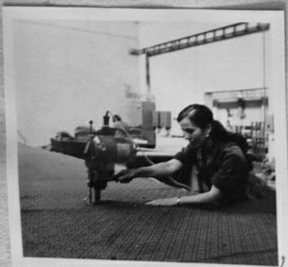
73-3161-2-Автоматично разкрояване на лицев плат. /В.Иванова/ТК
