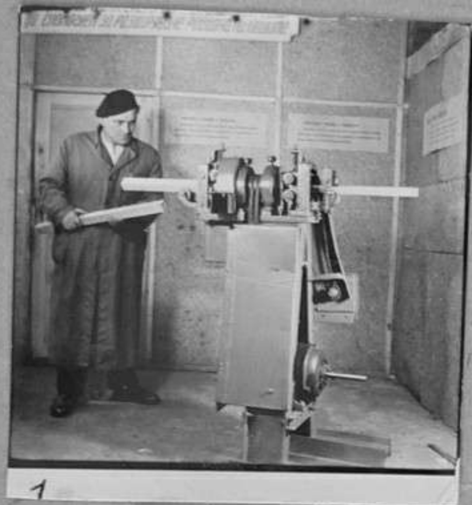
1,2 - Автоматична бусола за изработване части на столове, обслужвана само от 1 работник.
