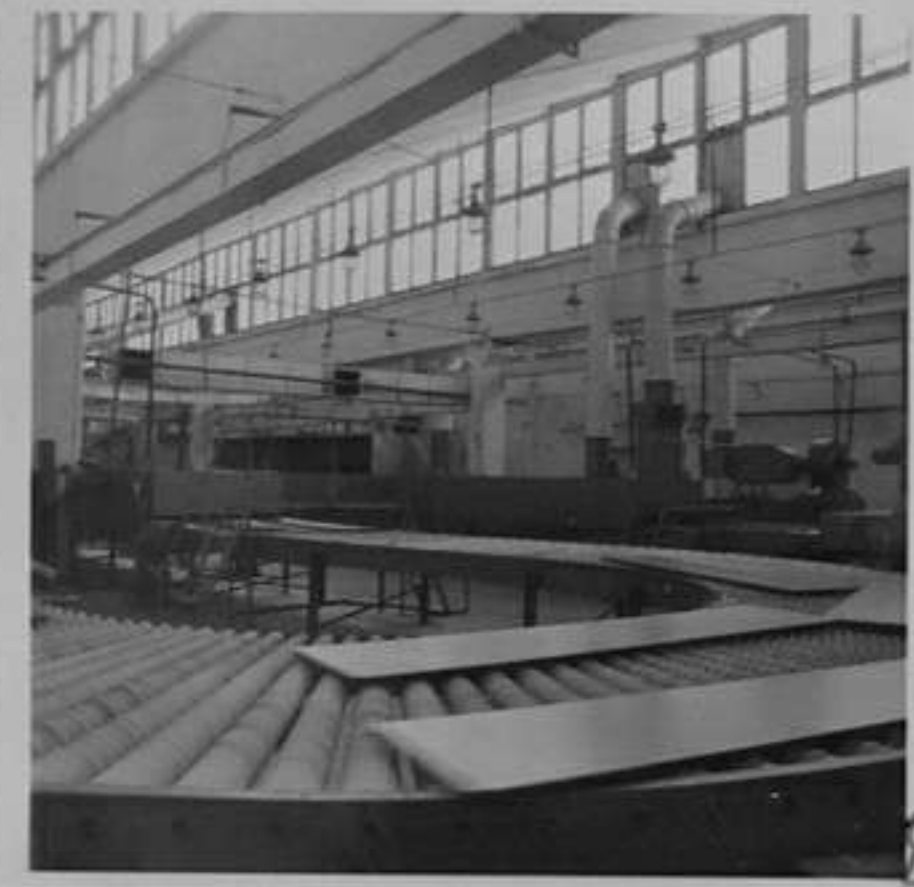
78-3867-5,8,9-Лакозалинна машина в Мебелен завод
