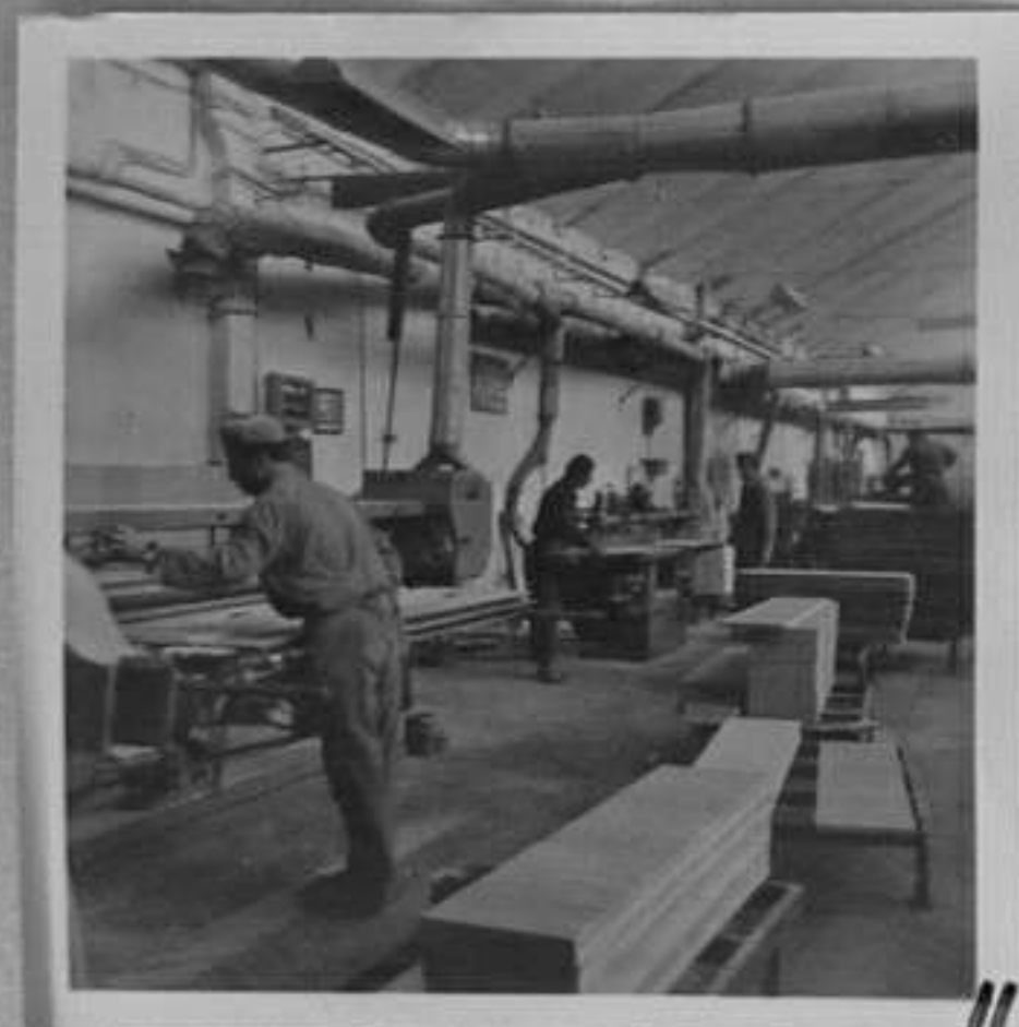
68-4613-11-Шлайж машина за шлайфане повърхностите на детайлите. /Д.Рогев/ XII
