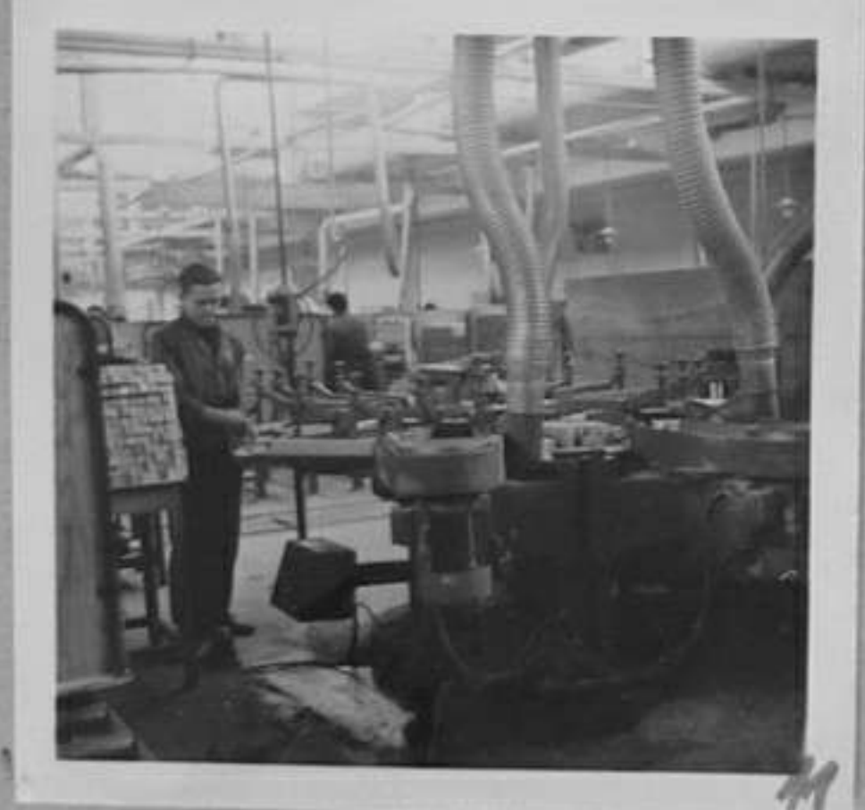
70-1-11-Н. Воденичаров профилира детайлите на каруселна фреза.
