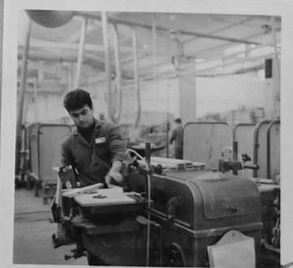
70-2-5-Бочо Бочев сглобява детайлите за столове на двустранна бормашина. /В.Иванова/ ИК
