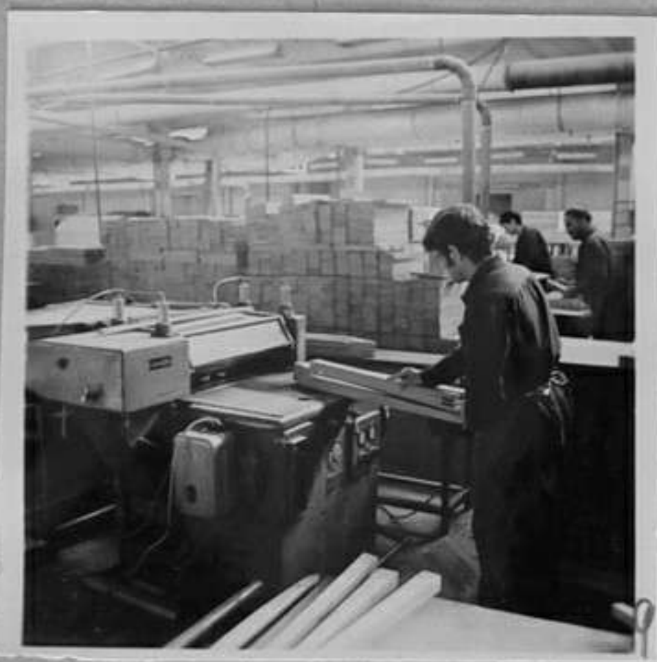
72-5550-7,9-Двуглава фреза за масивни детайли. /Н.Чобанов/ИК
