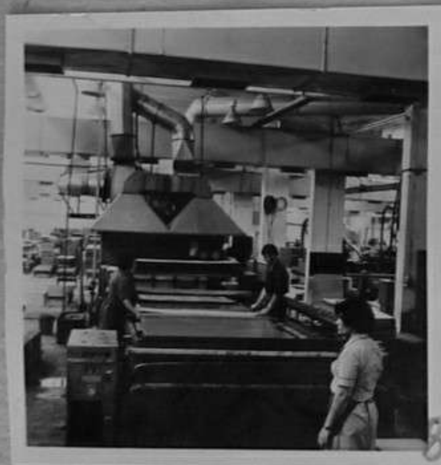
79-2795-8 Автоматични линии в завод "Добруджанска мебел" за лепене на фурнир към плоскостта Е.Киров/МД
