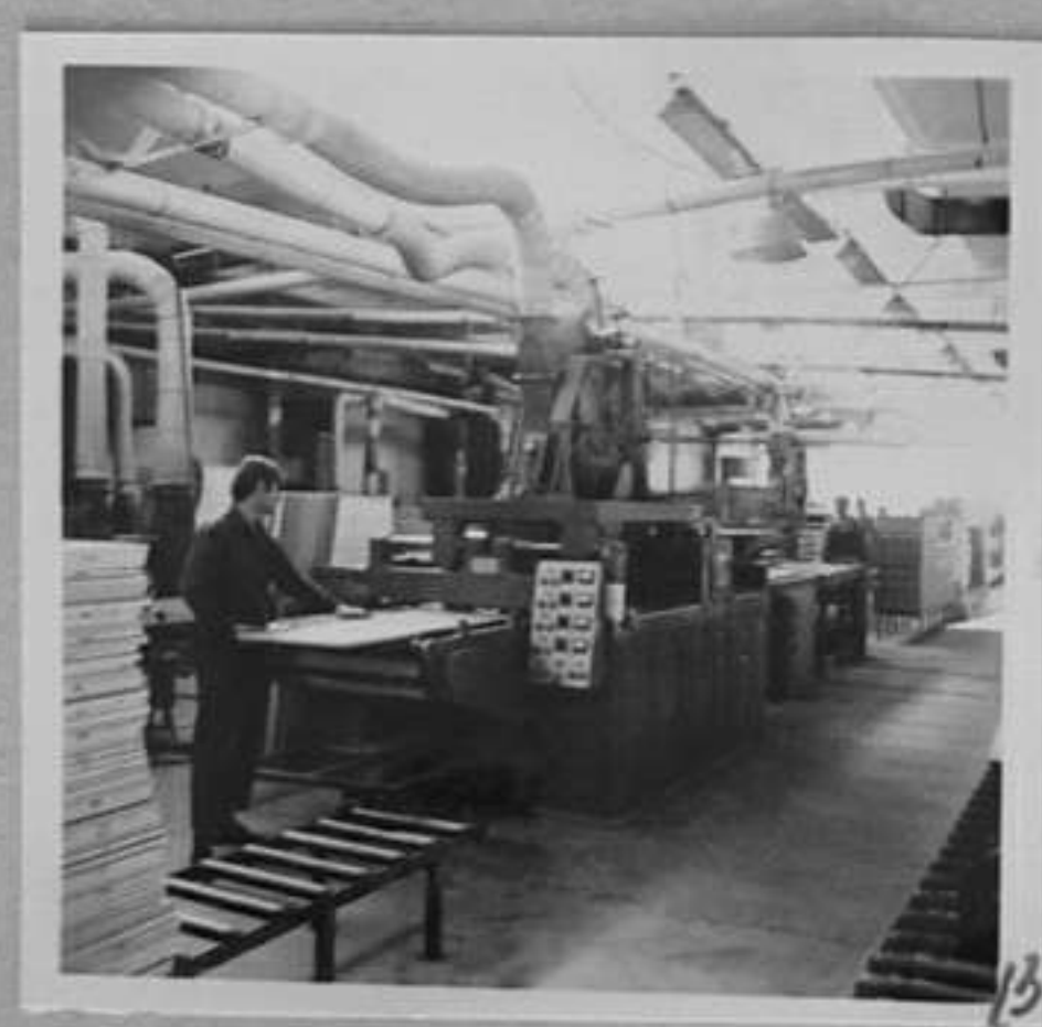
72-5551-13-По време на работа на шлайфмашина "Моника" с обръщач. /Н. Чобанов/ИК
