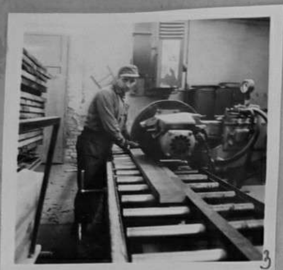
72-5550-3-Циркуляр за напречно разкриване на масивни детайли. /Н.Чобанов/ИК
