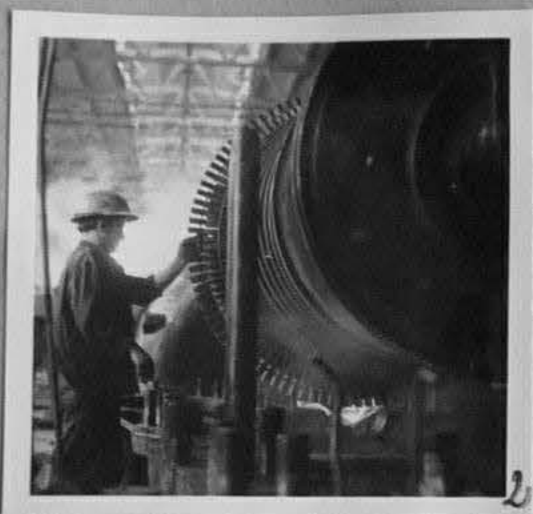
69-967-2-Капитален ремонт на турбина № 1. /К.Арсов/ ХП
