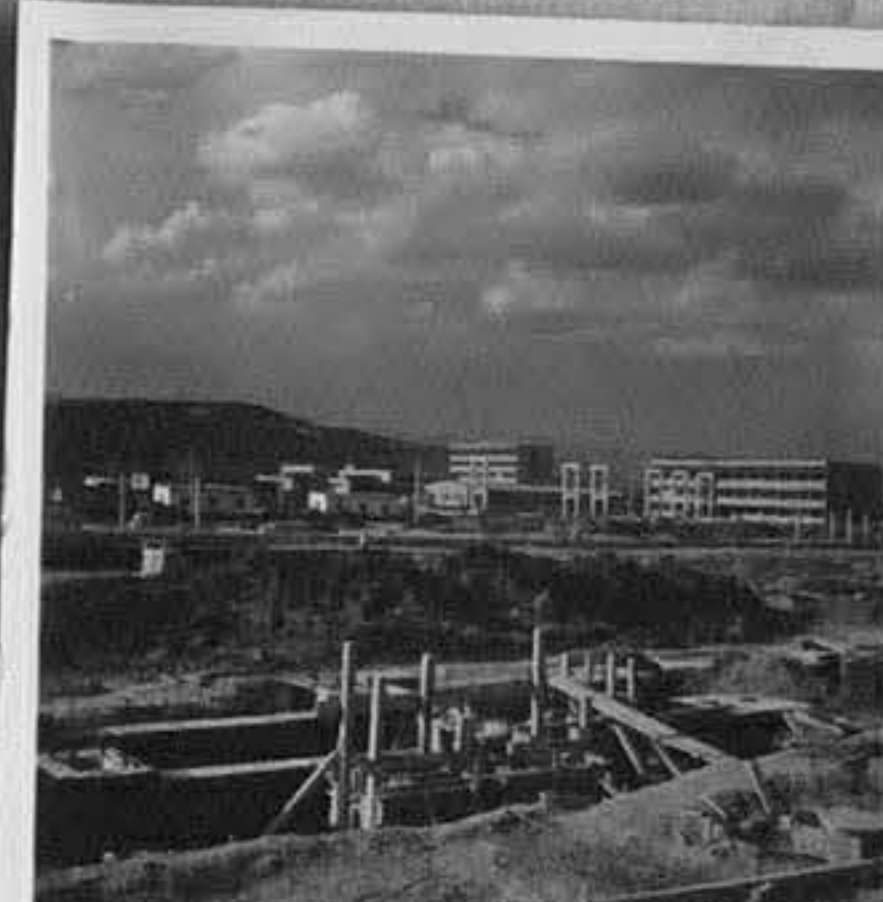
7-Общ изглед на строежа на АТЗ.
