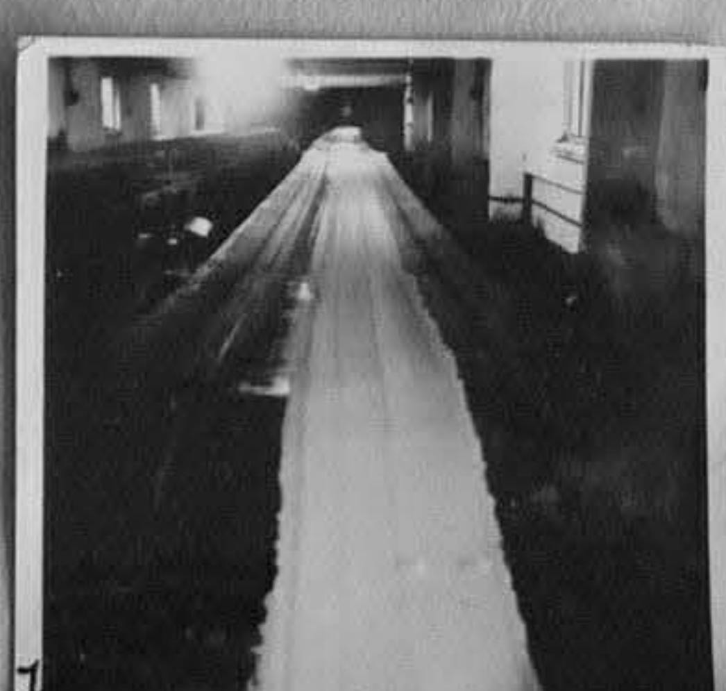
63/3609-7-Транспортна лента за пренасяне на амониачна салидра. /Йорданов/ ММ
