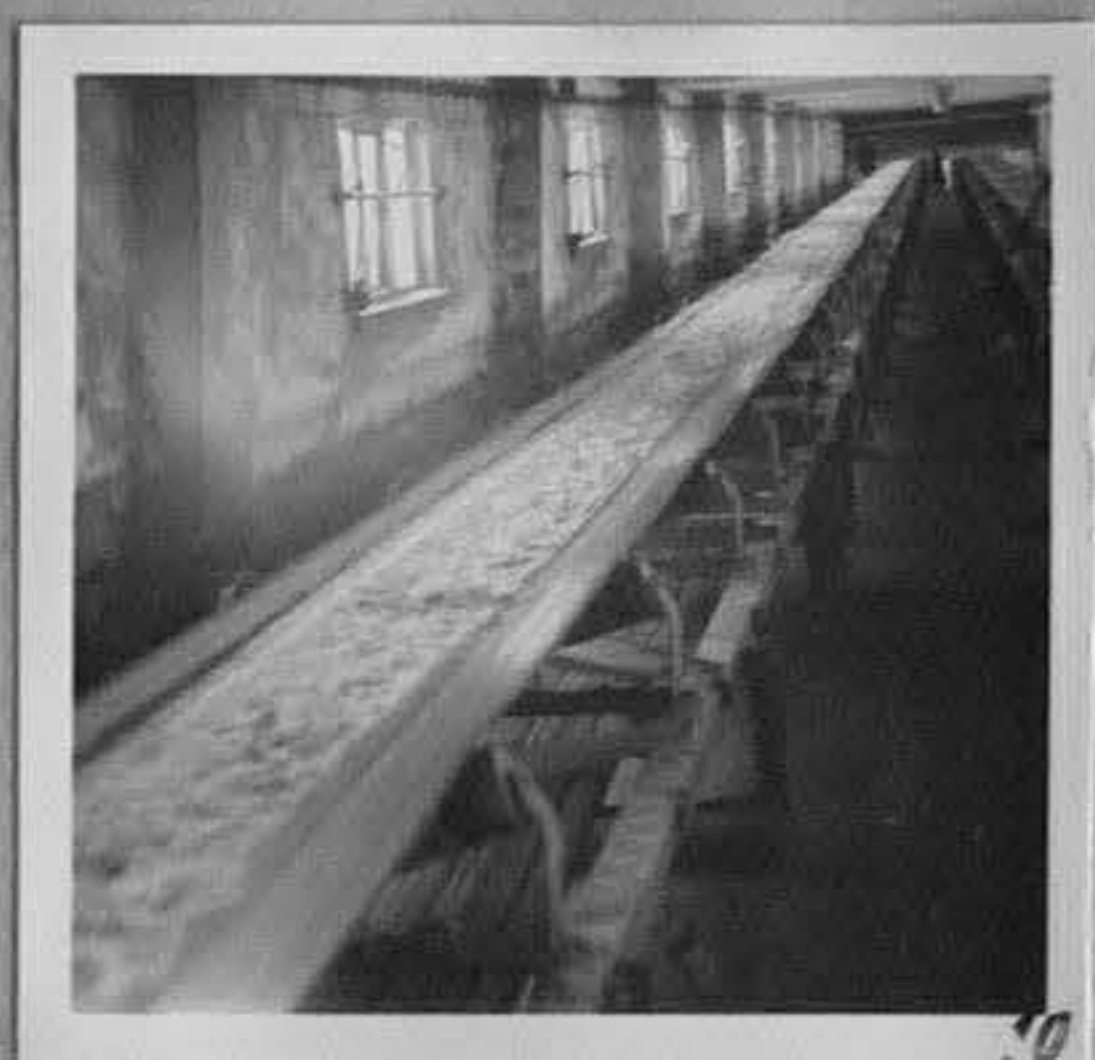
69-967-10,12,13-Транспортната лента, по която се пренася готова продукция, след това се пълни в чували и отива в склада.
