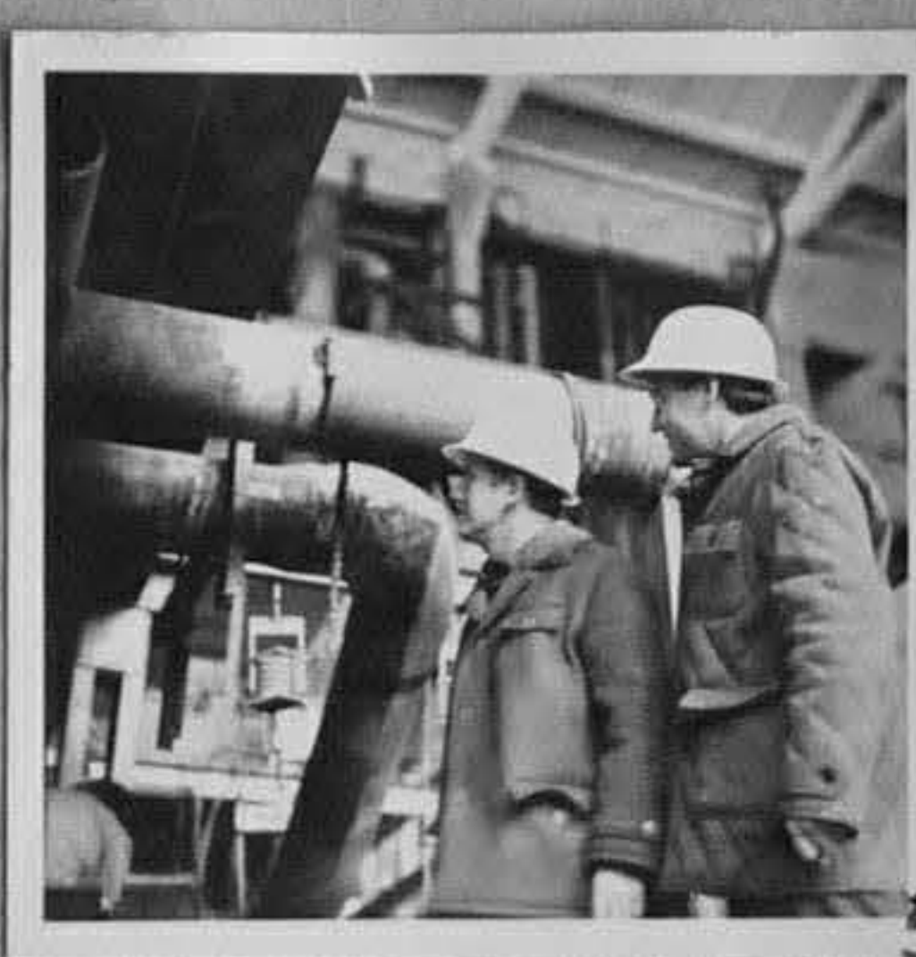
70-4730-5-На строежа на 120 меговата ТЕЦ. /Л.Златков/ ХП
