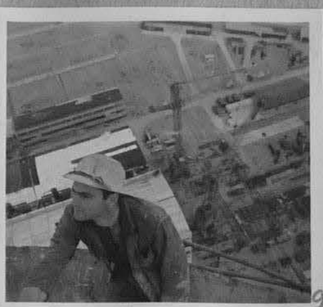
69-3031-9-Станчо Денчев на строежа на 180 м. кумин на завода. /Огн.Юскесилов/ ИК
