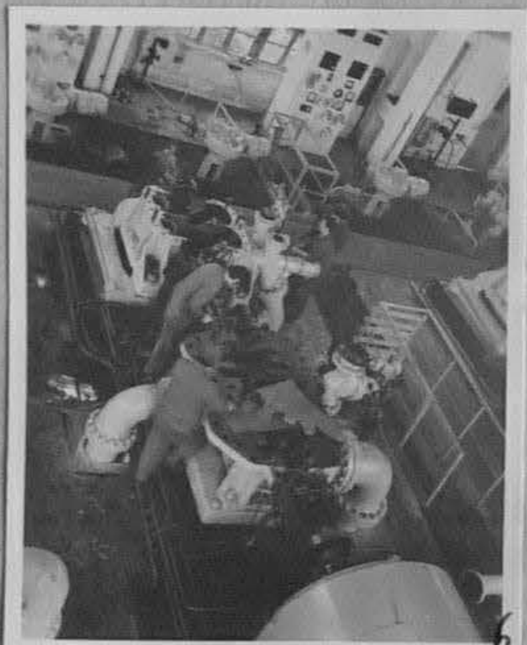
73-469-6-Ремонтна бригада с ръководител Миньо Найденов по време на работа в цех "Синтез". /Н.Чобанов/ИК
