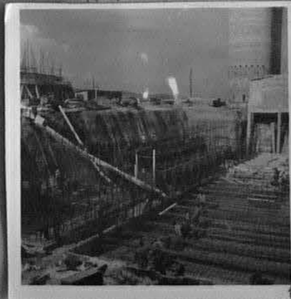
11-Строеж на помпена станция корпус 346 - долна плоча.
