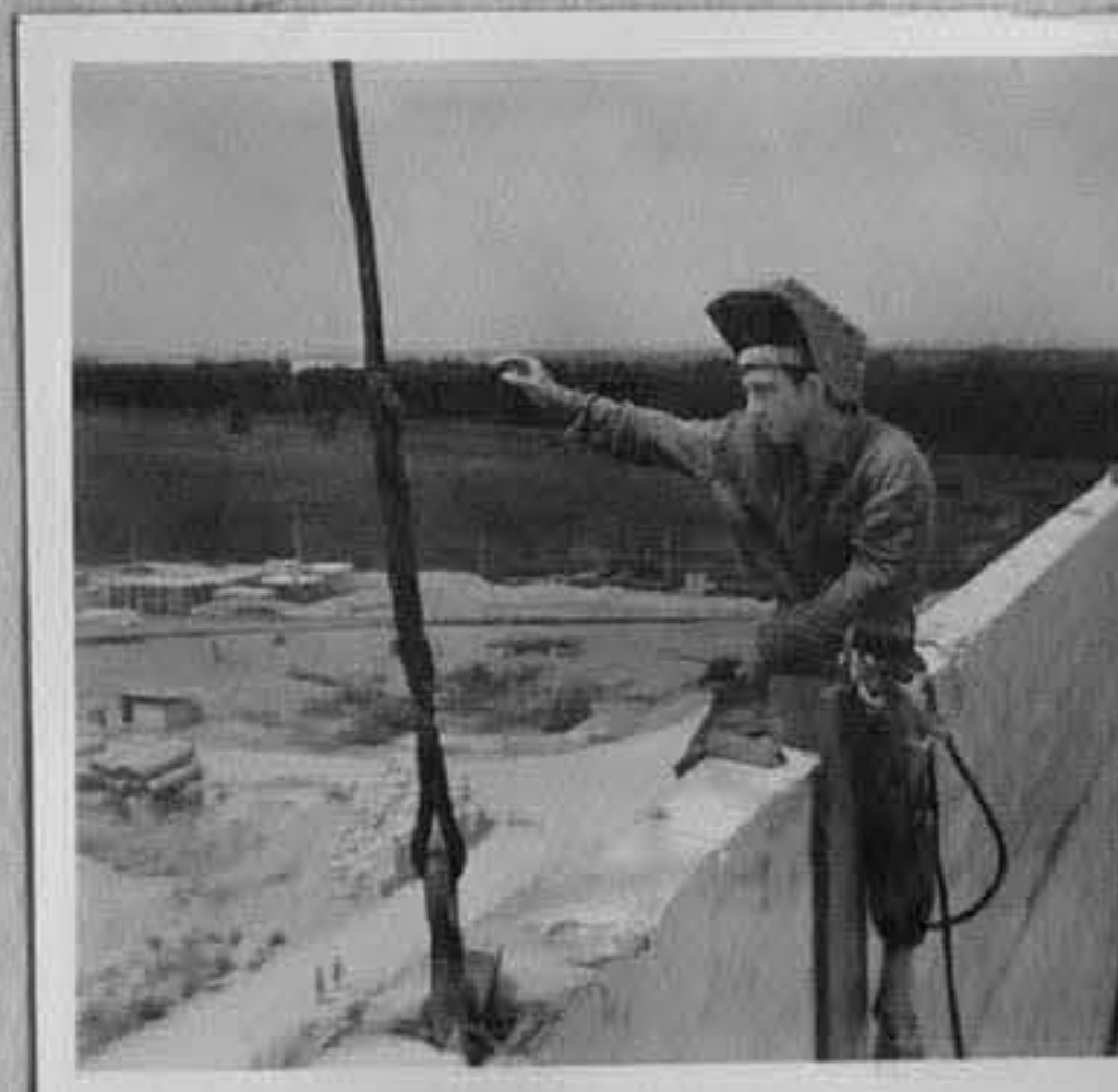
69-3030-8-Електроженист на строежа на ТЕЦ Свищов /Огн.Юскесилив/ ИК
