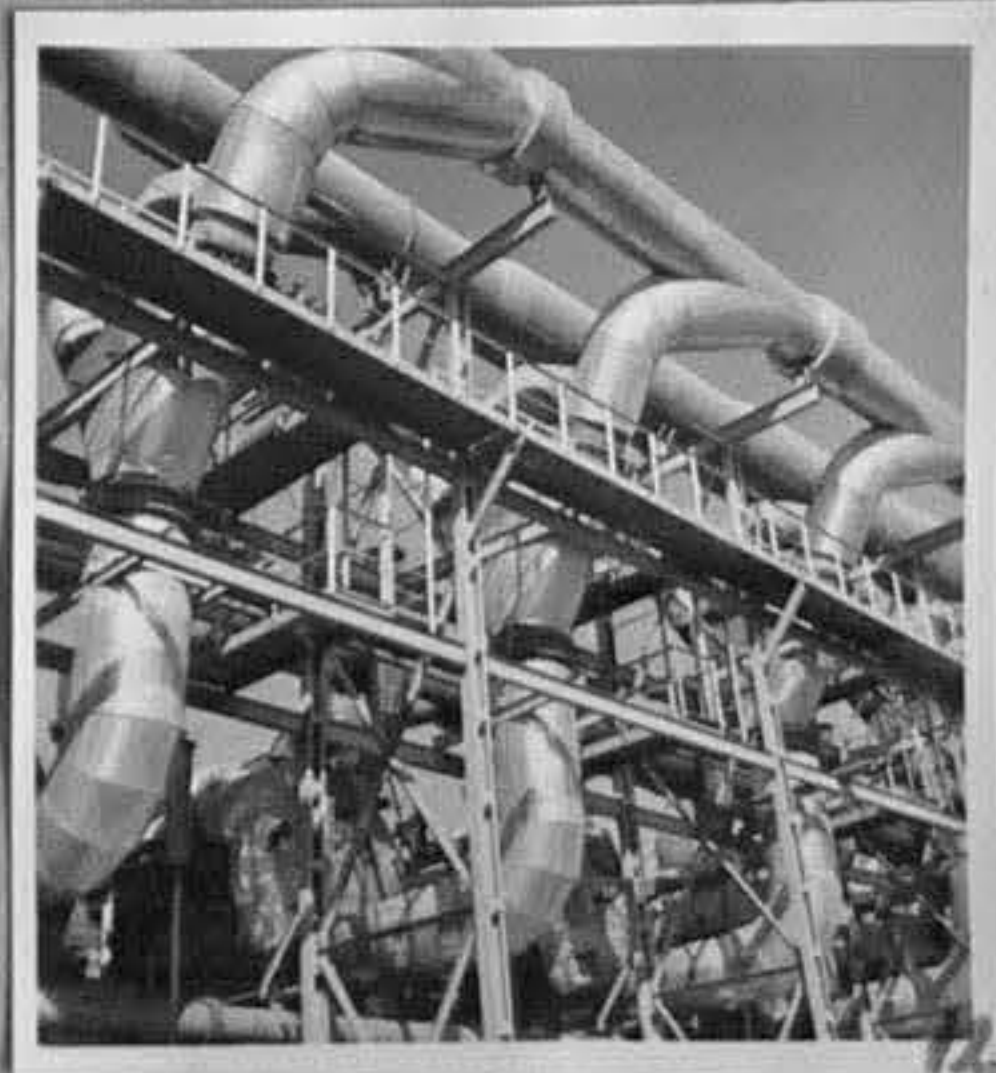
73-4839-12-Цех Газоочистка. /Т.Хорисян/ТК
