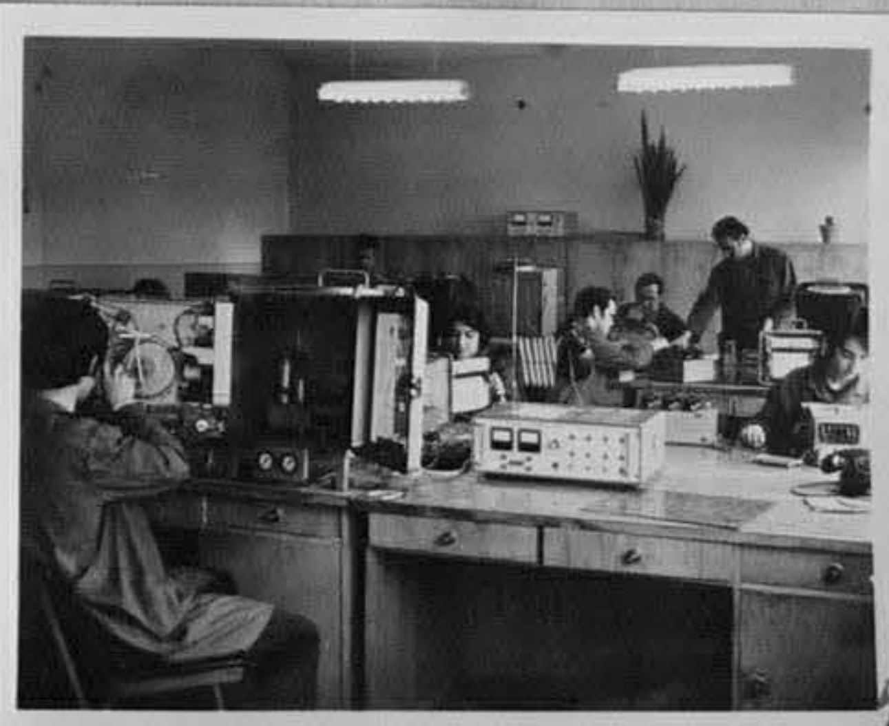
73-657-5-КИП и А-лаборатория пирометрична. Ремонт на прибори за висока температура. /Н. Чобанов/МК
