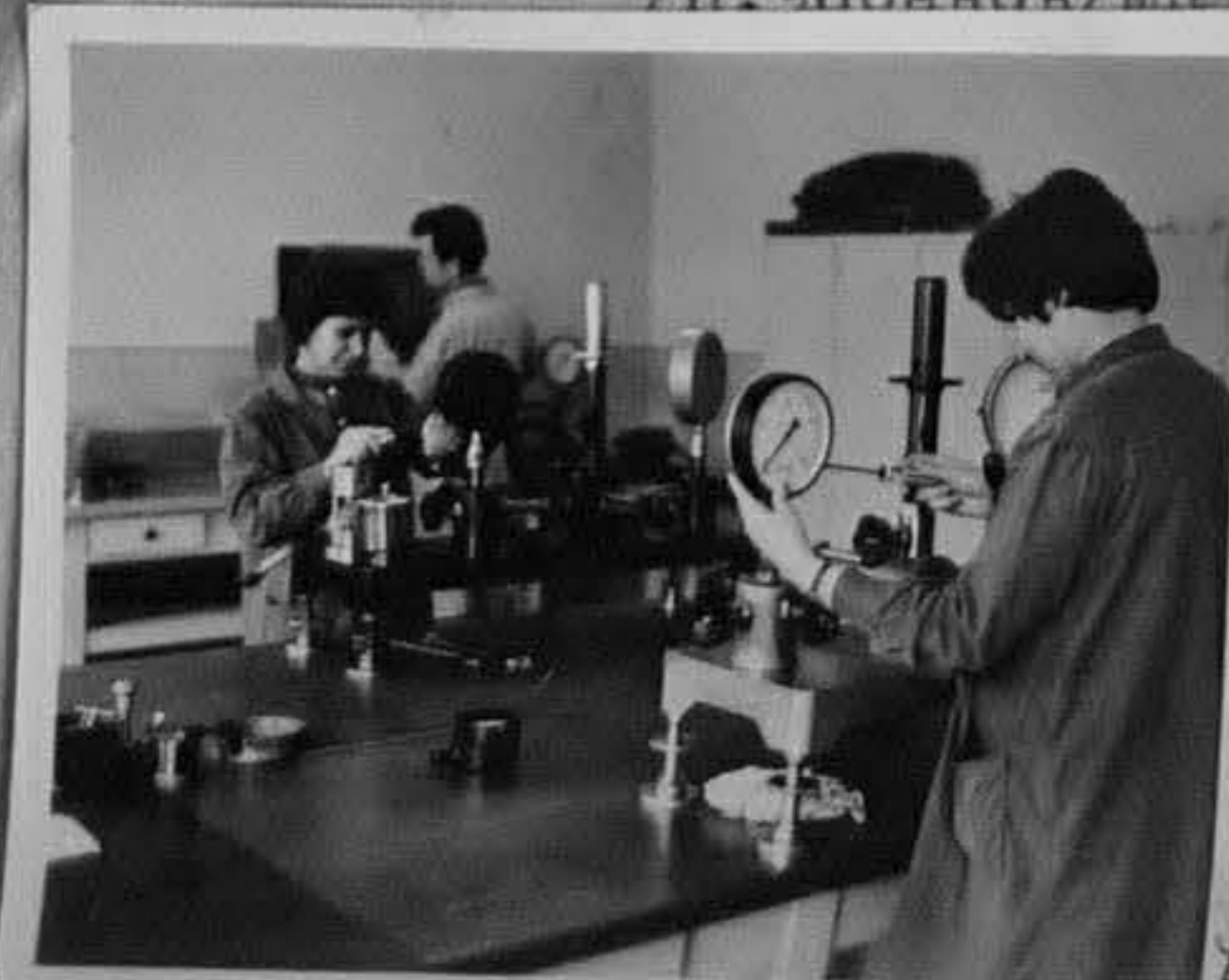
73-657-3-КИП и А-лаборатория авто- матика. Шлосерът по автоматика нас- тройва регулатор ПР 3-21. /Н. Чобанов/МК
