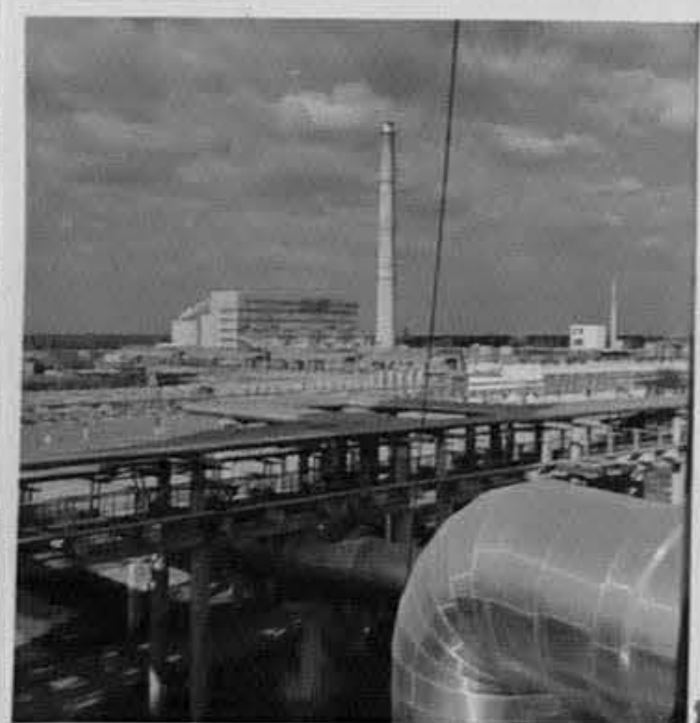
73-4829-12-Топлоелектрическата централа на комбината. /Т.Хорисян/ИК
