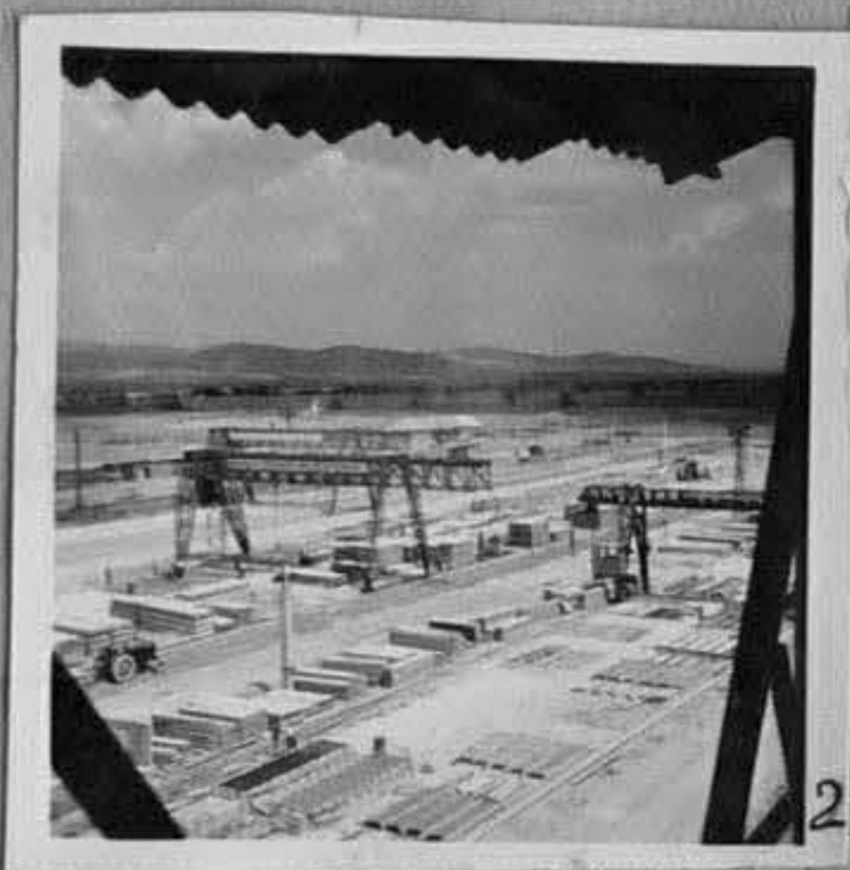
60/2797-2-Виброполигона на новостроящият се завод. /Хорисян/
