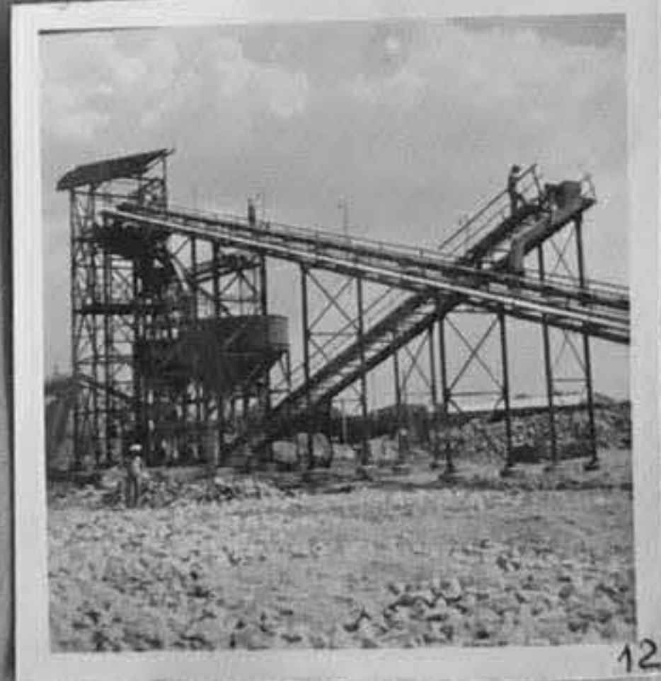
12-Бетонният център на завода.
