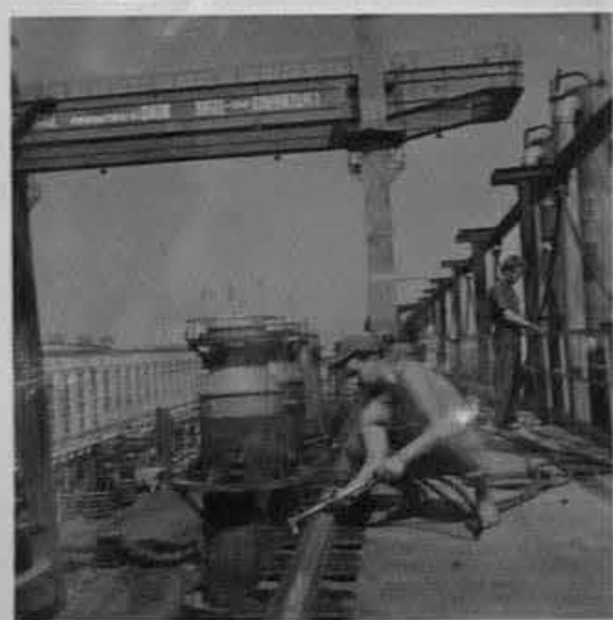
1- Комсомолците-оксигенисти П. Торосенко и Енчо Д. Иванов завършват подкравания път на козловия кран. За добрата им работа са награждавани парично.
