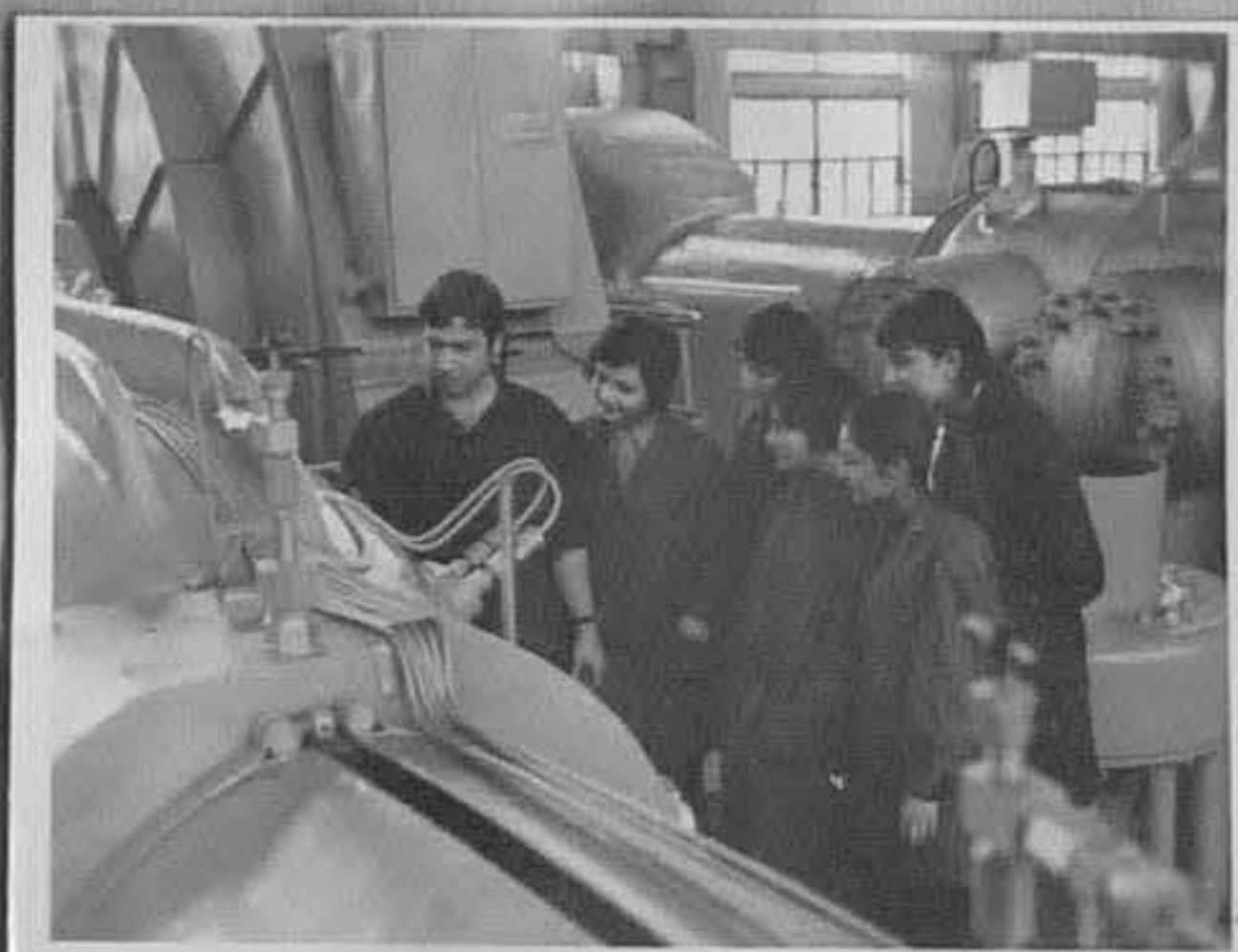
73-469-3-Петко Митев - машинист на газов компресор разяснява на учениците от училището за индустриална химия принципа на действие на компресор./Н.Чобанов/ИК
