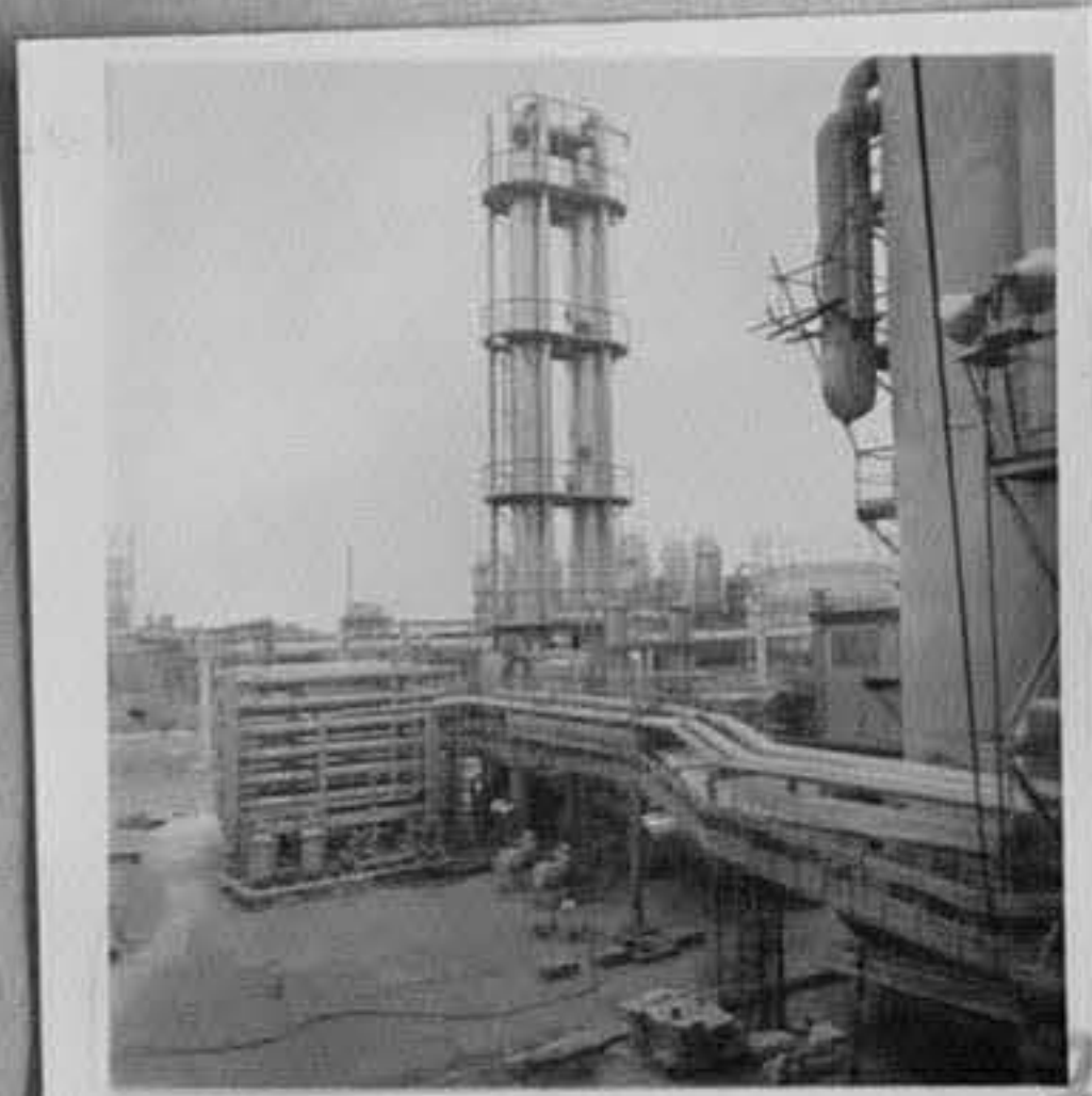
79-1954-2-Нова инсталация за абсорбция на въглероден двуокис.
