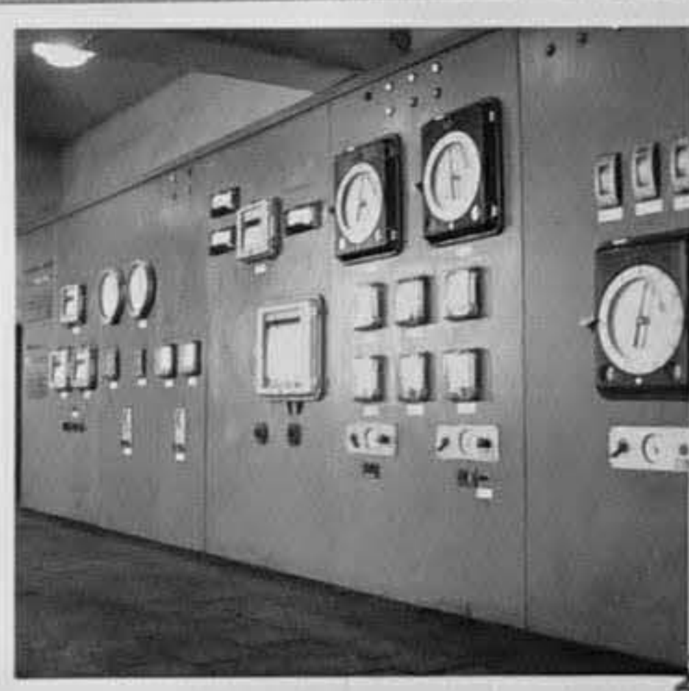
71-257-2-Щит за управ- ление на мазутен гене- ратор, изработен в за- вода. /Н.Чобанов/ ИК
