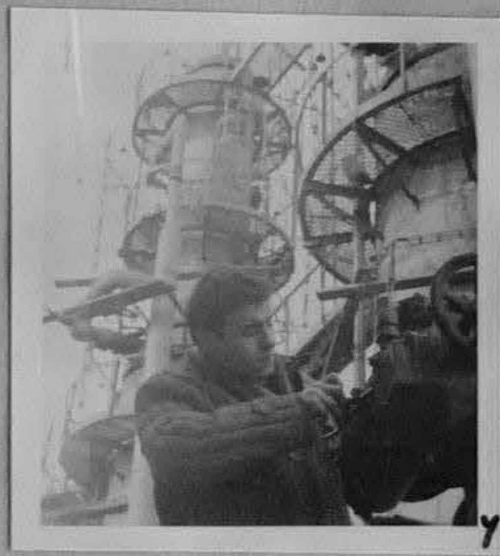
69-179-4 - Завод за кап-ролактан, цех "Нитритен". Монтаж на електродвигател за електрозадвигка в цеха.
