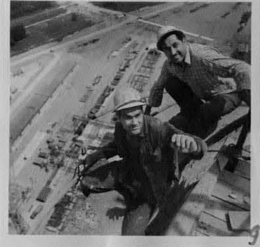
69-3034-9-Бригадирът Рангел Ваклинов и Станчо Денчев на върха на 180 м. кумин на ТЕЦ Свищов. /Огн.Юскесилов/
