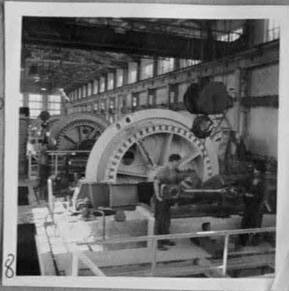
62/2430-8-Бригадата на А. Вилчевски монтира ед. синхронния двигател в пел 119/2, доставени от СССР. Те изпълнява нормите си 120%. Т. Иорданов/ ЕН.
