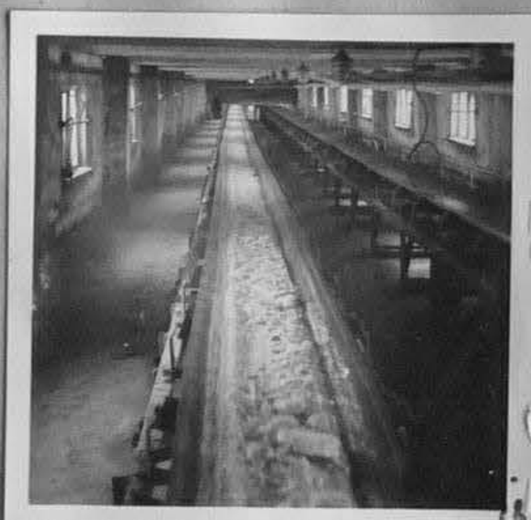
69-967-10,12,13-Транспортната лента, по която се пренася готова продукция, след това се пълни в чували и отива в склада.
