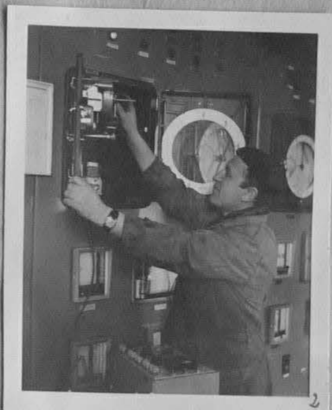
73-470-2-Шлосерът А.Тодоров Яйджиев извършва контролен преглед на ЕПД-2 на ГГ-3 в газгенераторния цех. /Н.Чобанов/ИК
