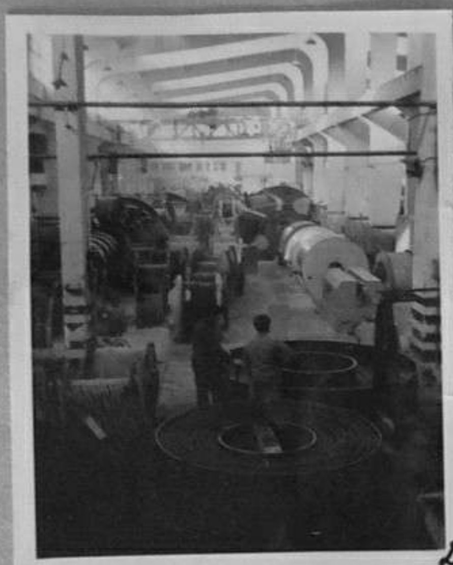
69-60-2-Общ изглед от кабел- ния цех. /Б.Юскеселиев/ XII
