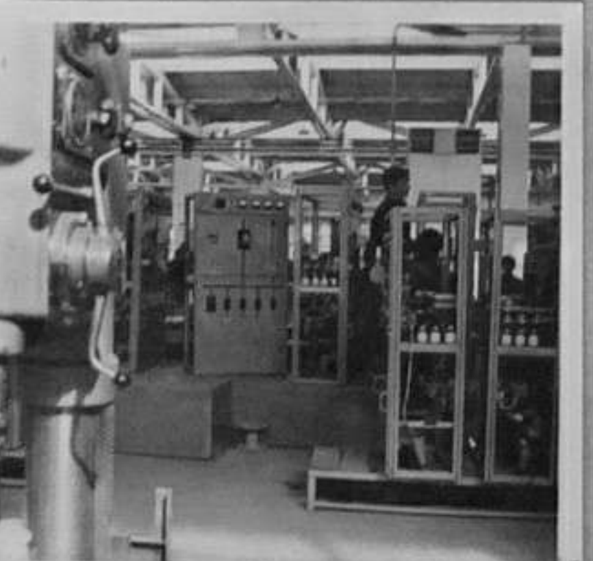
71-1477-5,7-Монтаж на табла за ниско напрежение за комплектните трансформаторни подстанции. /Рад. Парушев/ XII
