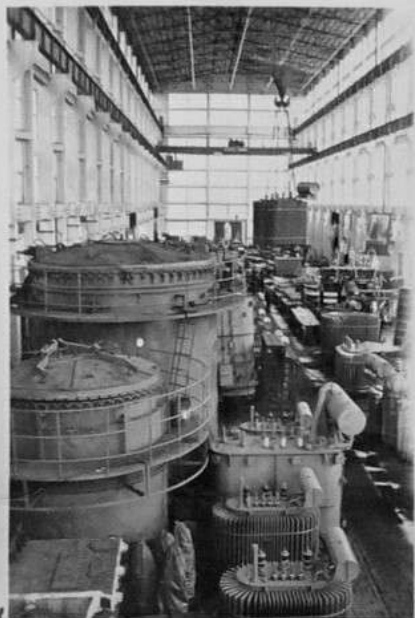
62/1265-7-Трансформаторни цех. /Токов/ МИ
