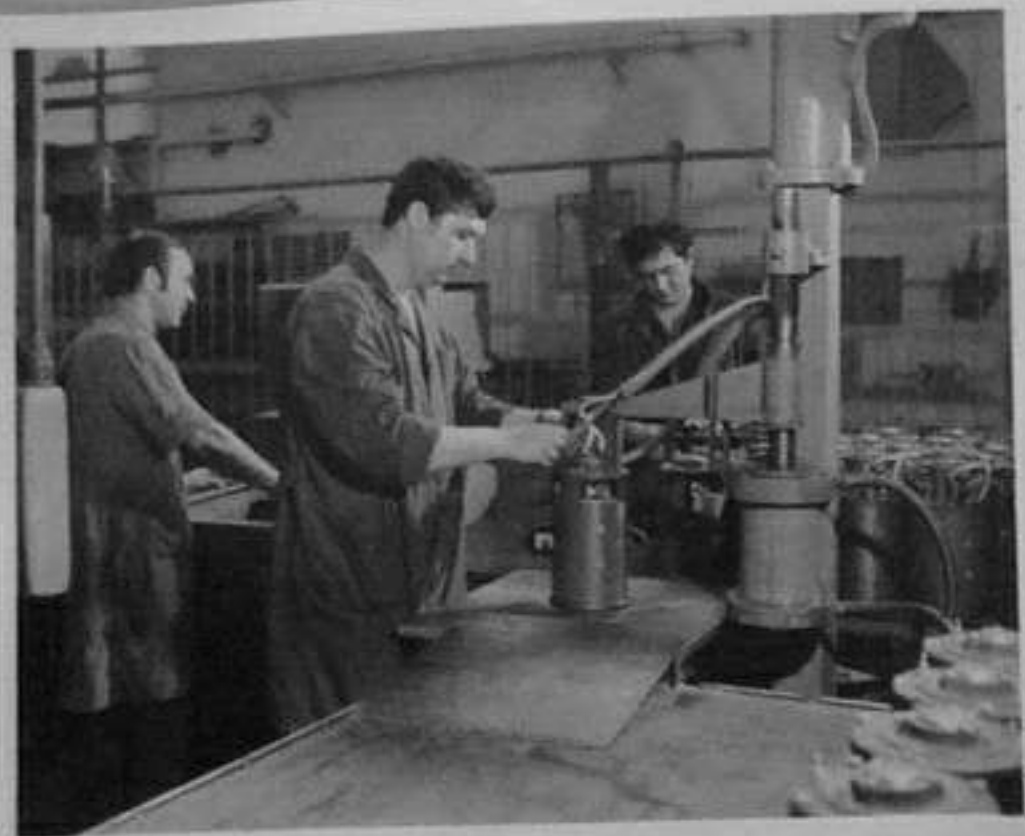
72-2528-7-Изпитване на автомобилни електро-динамични машини за износ в СССР в изпитателната станция. /Е.Любомиров/ИК
