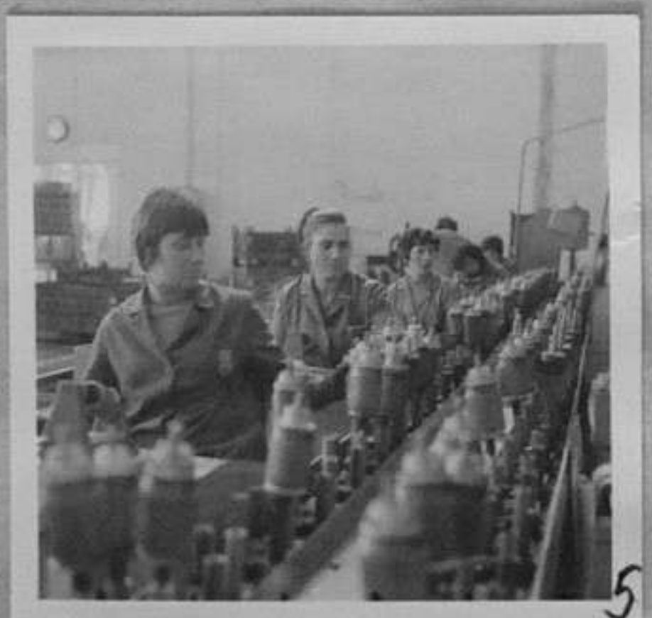
77-1813-5 Цех за монтаж на статори - линия за бубиниране на ротори Кр. Узунова/МД
