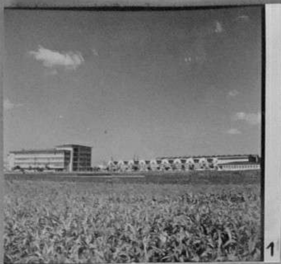
1,9 - Общ изглед на завода.
