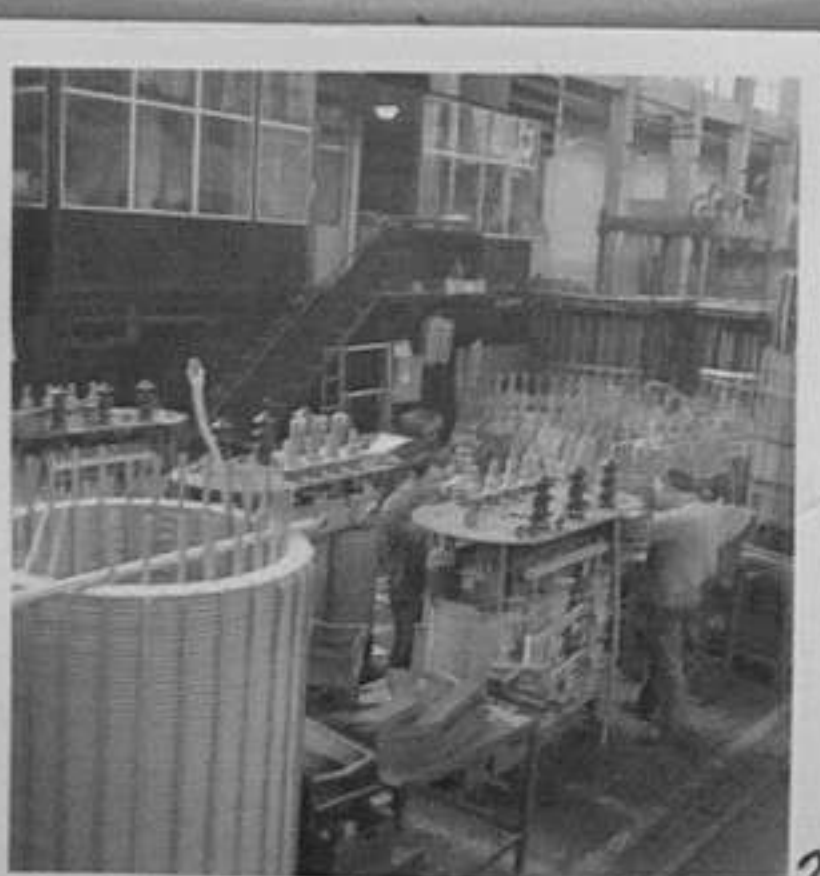
77-2052-2,12 Монтаж на високоволтови трансформатори в завод "Васил Коларов"
