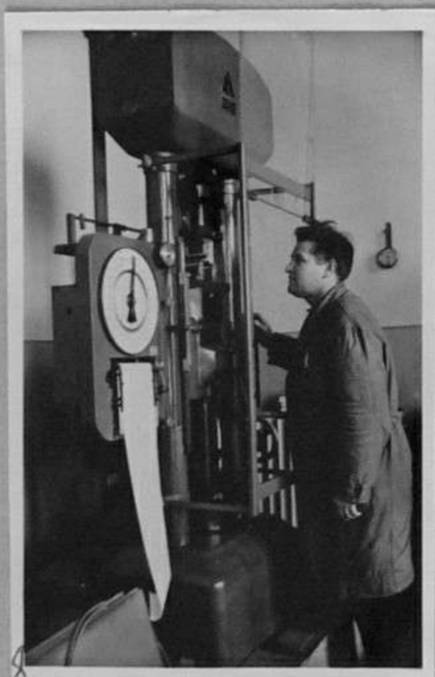
64/402-8-Ст. техникът П. Григоров изпитва якостта на огъване на гетинаксови проби. /Янев/ ММ
