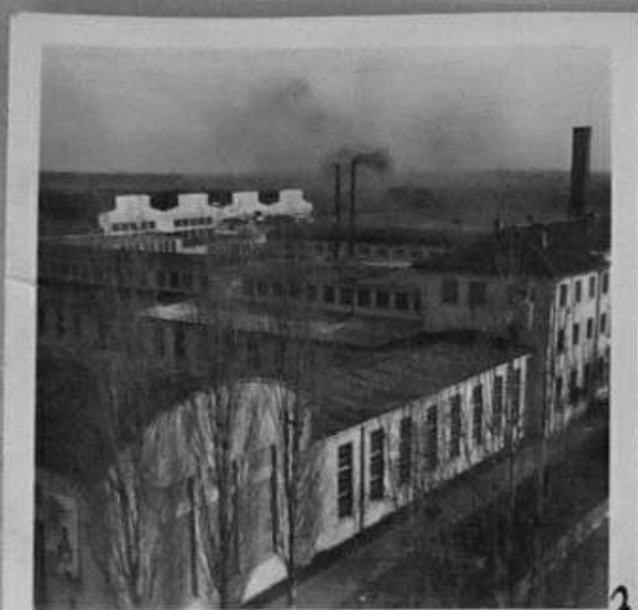
68-462-3-Общ изглед на завода.
