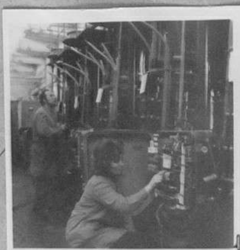
76-3797-1-Стъпален регулатор за трансформатори РС-4. /Р.Марукян/ЛА
