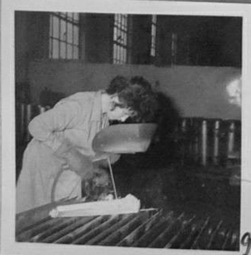
77-2053-9 Иванка Петканова - електроженист от завода, заварява радиаторите на трансформаторите
