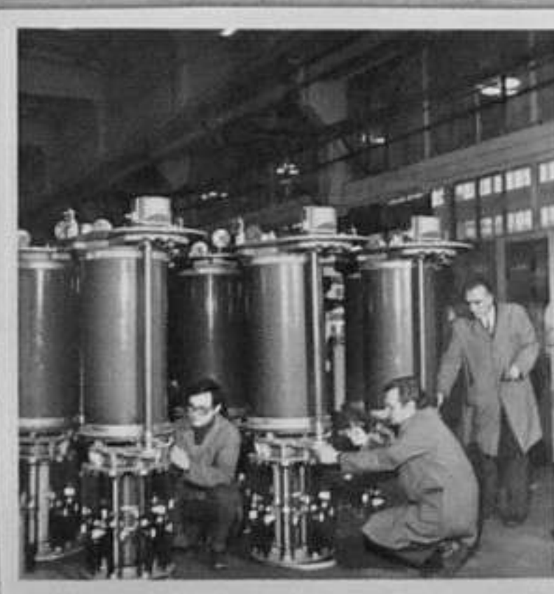
84-62-7-Монтаж на стъпални регулатори РС-9, предназначени за износ в Индия.
