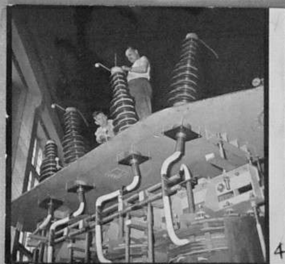
55/1381- 1,2,4 - Новият силов маслен трансформатор 12,500 КВА с двойно регулиране за 110,000 и 20,000 кВ. /Страхинов/
