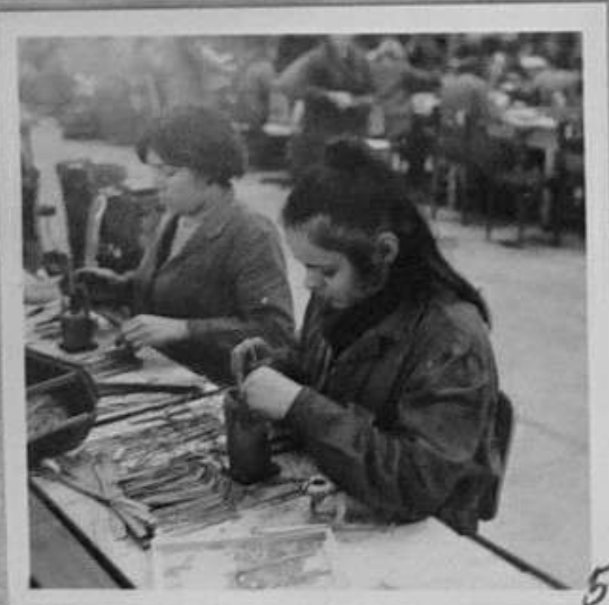
71-6411-5-М. Георгиева изв. монтаж на ротор на стартер. таж на стартери. /Н. Чобанов/ МК
