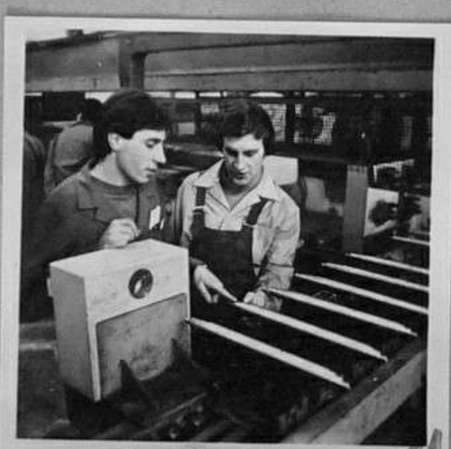
80-4070-11,12 Автоматична технологич. линия за обработка на валове за електродвигатели с капацитет 100 хиляди годишно. Цялата технологична линия ще се обслужва от 4 човека Г.Чакърян/МД
