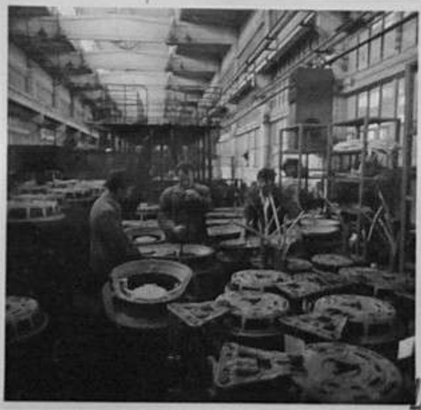
78-1927-3,4-Бригадата на Илия Атанасов от цех "Стъпален регулатор" извършва монтаж, центровка и изпитание на маслен съд. /М.Савова/АШ
