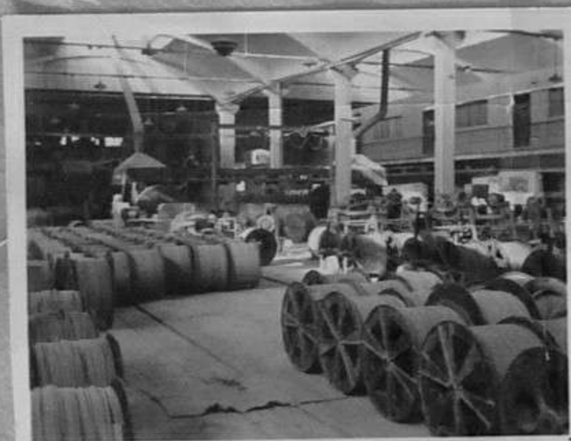
69-60-6,7-Общ изглед от цех 400 - изолационен.
