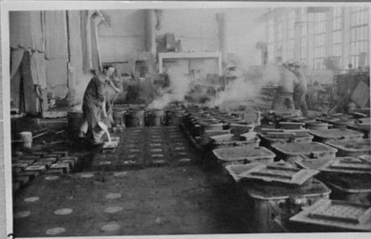
64/536-2-Лепрският цех - изливане на детайли за електромотори. /Янев/ ММ
