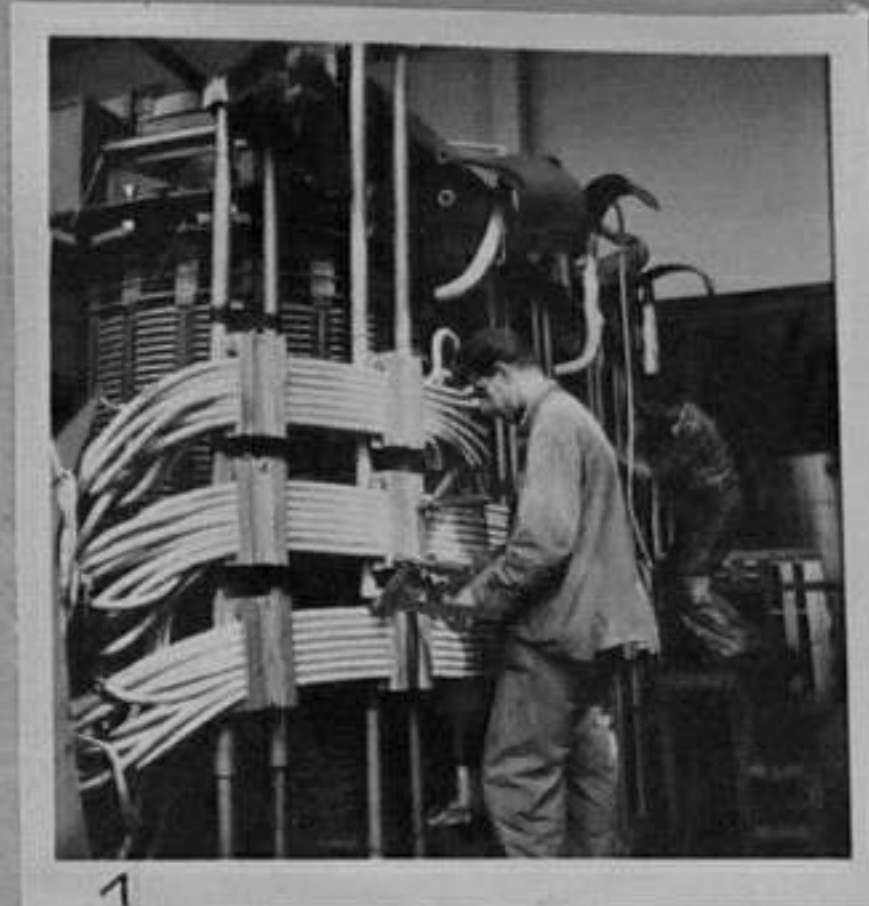
57/2098-1-Монтаж на трансформатор с мощност 31,500 KV. /Халачев/ ММ
