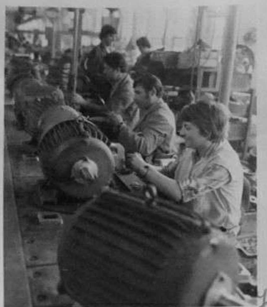
75-1408-7-Цех "Ел-6", бригадата на А.Юмерски монтира асинхронни електродвигатели. /Кр.Узунова/ТК
