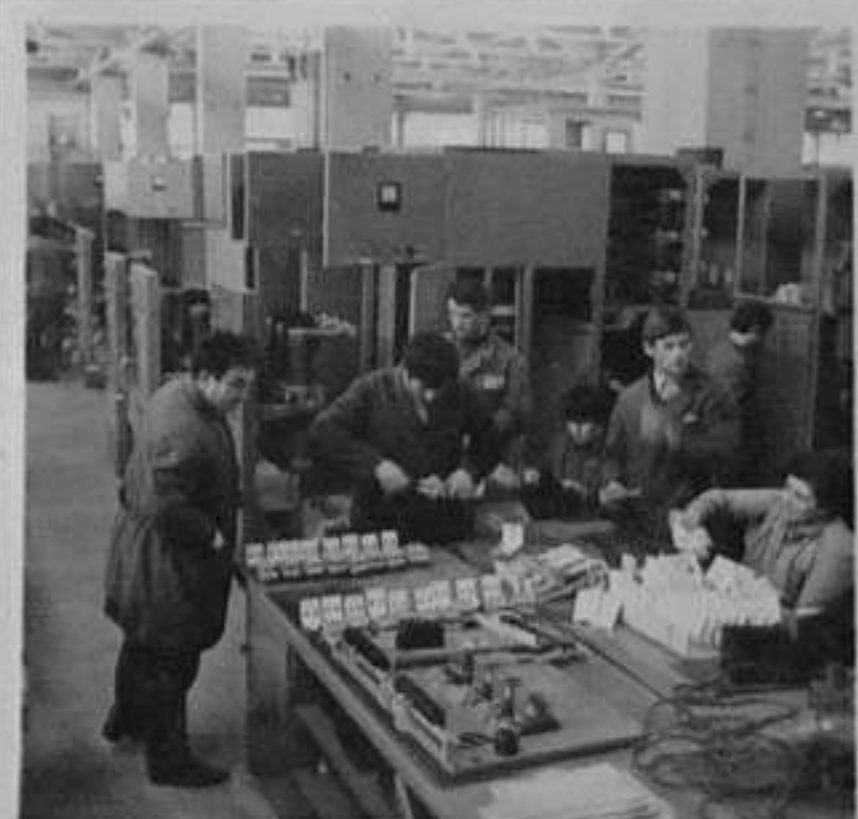
71-1477-11-Монтаж на комплектни разпределителни устройства. /Рад. Парушев/ XII
