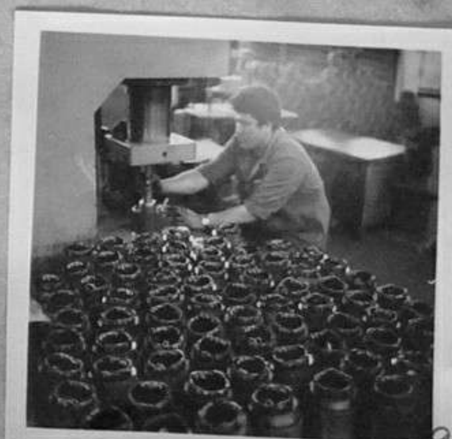
72-1412-9-Зам.бригадирът Иван Петров набива статора в тялото на елмотора. /В.Иванова/ МК
