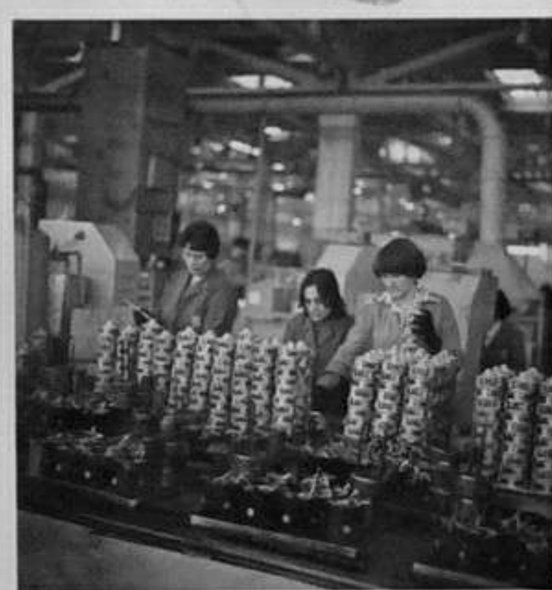
78-1114-1 Завод "Динамо" - Сливен - на роторния конвейер са Гергана Иванова, Мария Козарева и Костадинка Вълчева, които сглобяват разл.частият ротора на ел. мотор на "Жигули" Е.Любомиров/МД
