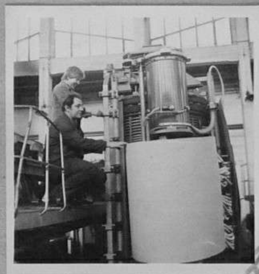
80-2332-11,12 Цех "Големи мощности". Бригада "Васил Левски" извършва монтаж на 25 мв трансформатор Р. Марукян/МД 81-517-2 Младжката бригада "В. Левски" работи по почина "За висока соц. дисциплина" Р. Марукян/МД
