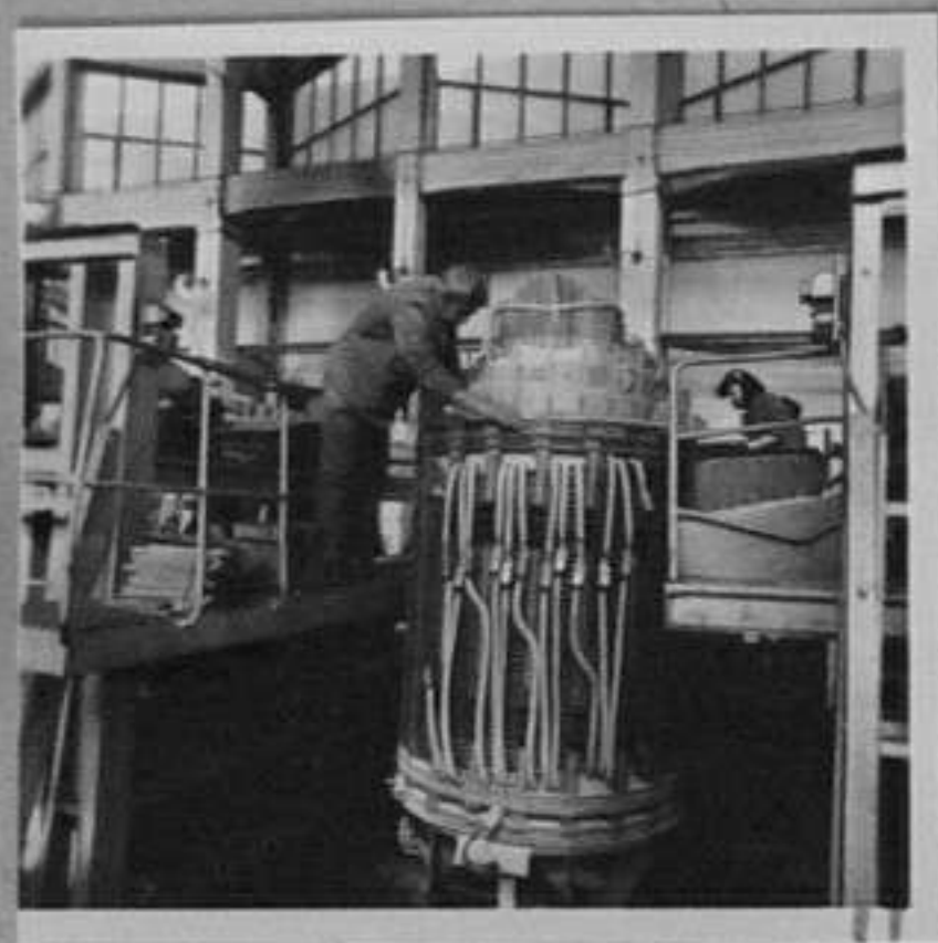
80-2332-11,12 Цех "Големи мощности". Бригада "Васил Левски" извършва монтаж на 25 мв трансформатор Р. Марукян/МД 81-517-2 Младжката бригада "В. Левски" работи по почина "За висока соц. дисциплина" Р. Марукян/МД
