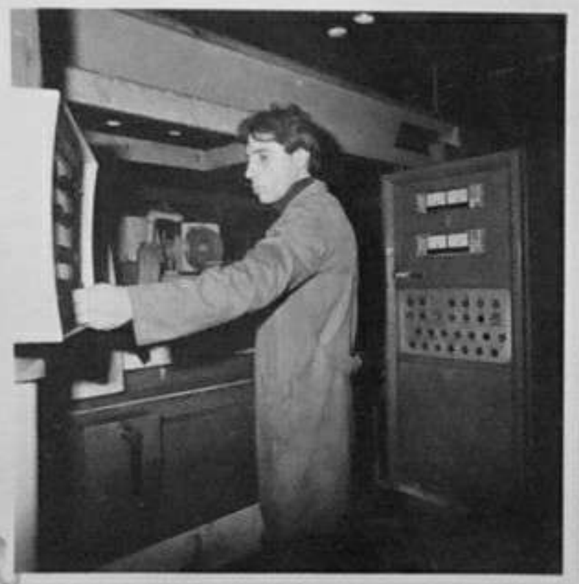
80-3545-2,4 Борис Атанасов оператор и настройчик на портален манипулатор от лек тип с автоматични шлайф машини Ем. Богоев/МД
