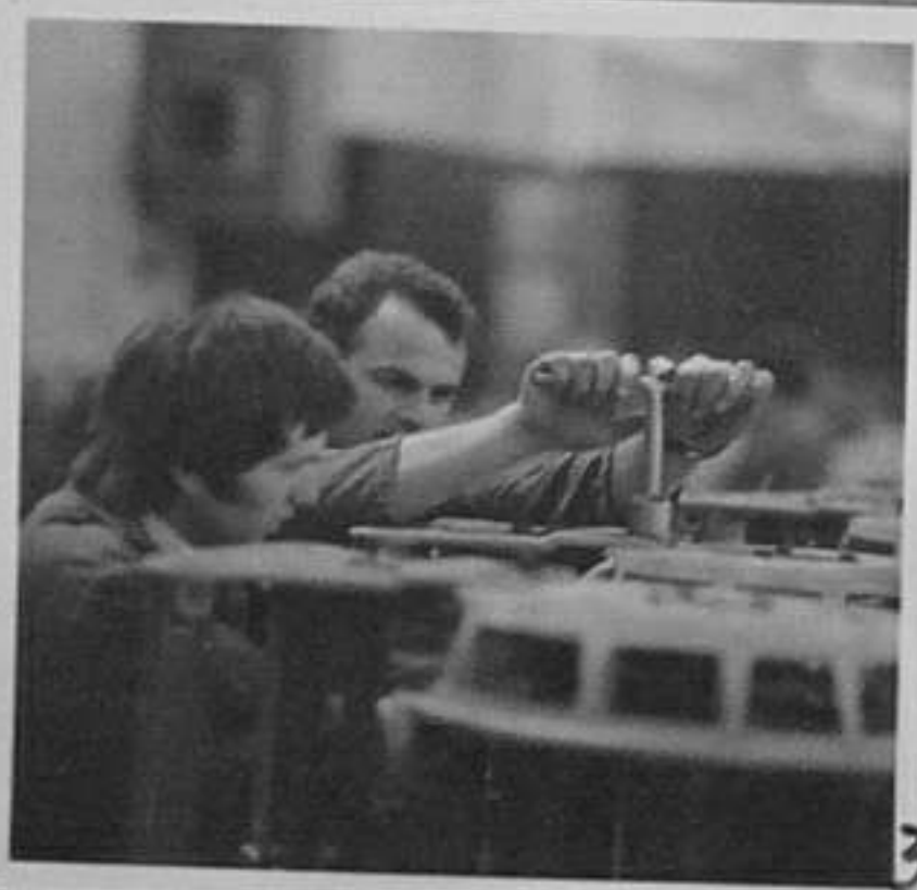
78-1927-3,4-Бригадата на Илия Атанасов от цех "Стъпален регулатор" извършва монтаж, центровка и изпитание на маслен съд. /М.Савова/АШ
