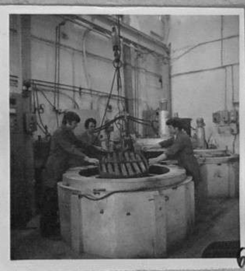
77-2367-6-Момент от зарежда- нето на печта с роторни и статорни пластини за термо- хим. /В.Балевска/ЛА
