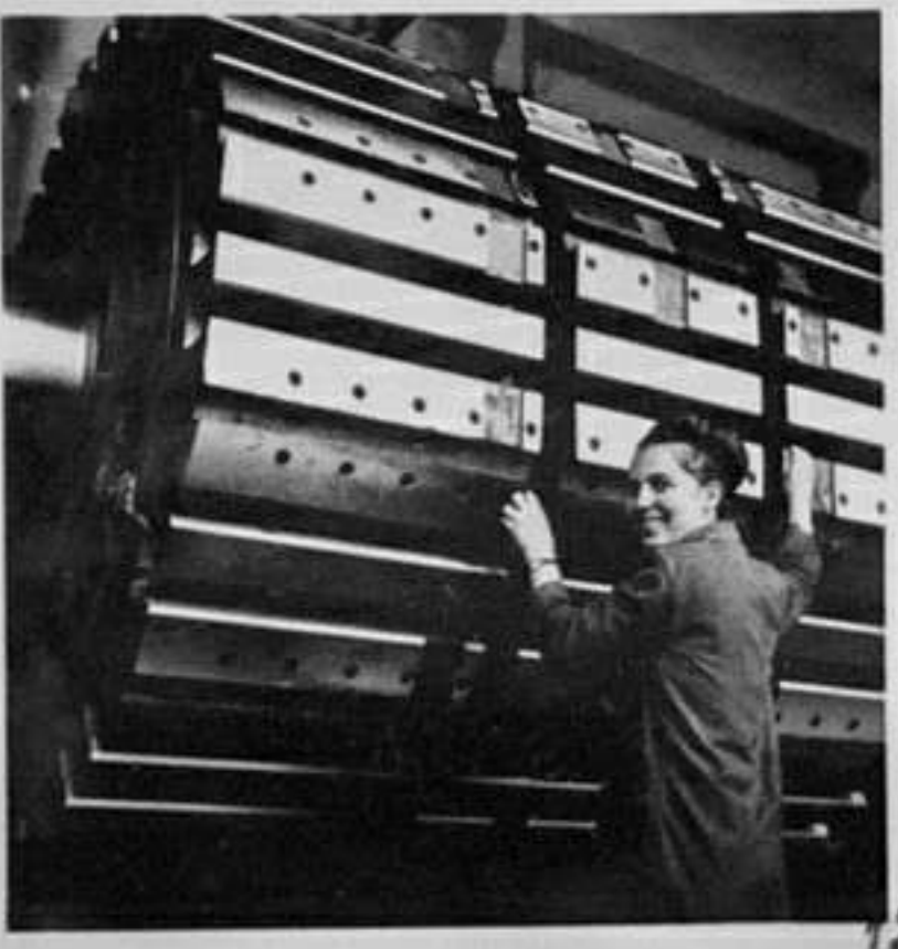
67/523-11,12 - Генераторен цех. Ротор на хидрогенератора от 35000 кВ за ВЕЦ "Тешел" - най-големият, изработван до сега у нас. /Попов/ЕИ
