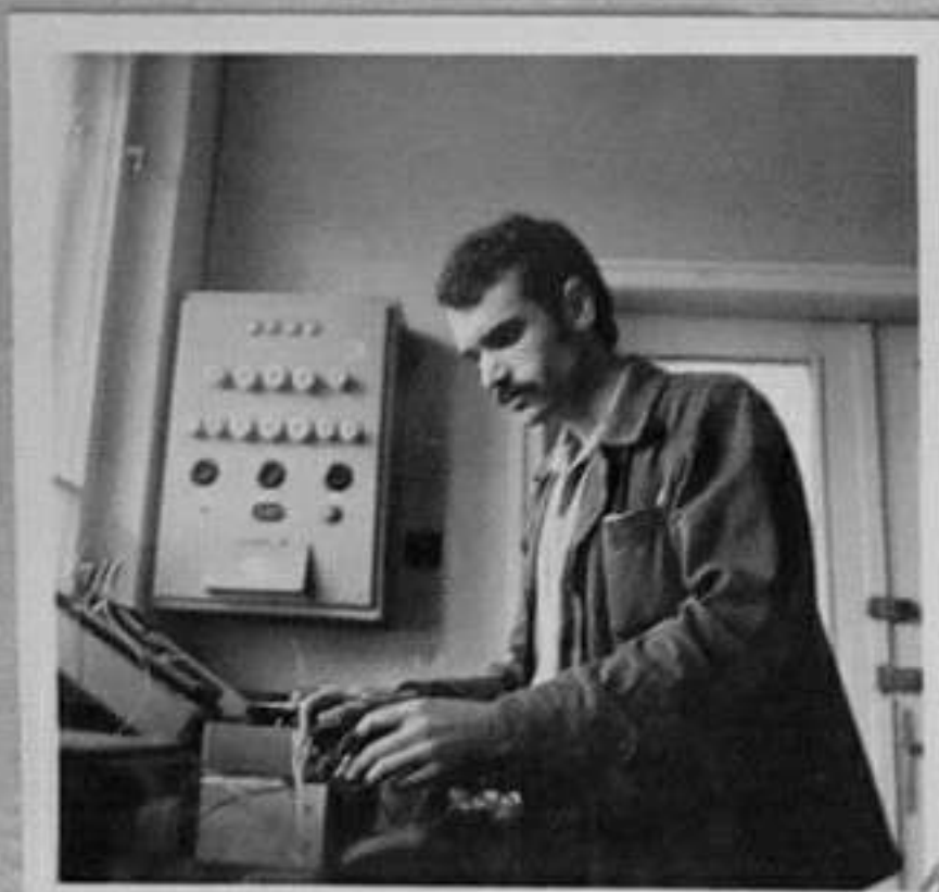
72-4477-7-Младежка бригада с ръководител В.Ангелов работи по монтажа на ел.двигател АСФ. /Ан.Цанков/ИК
