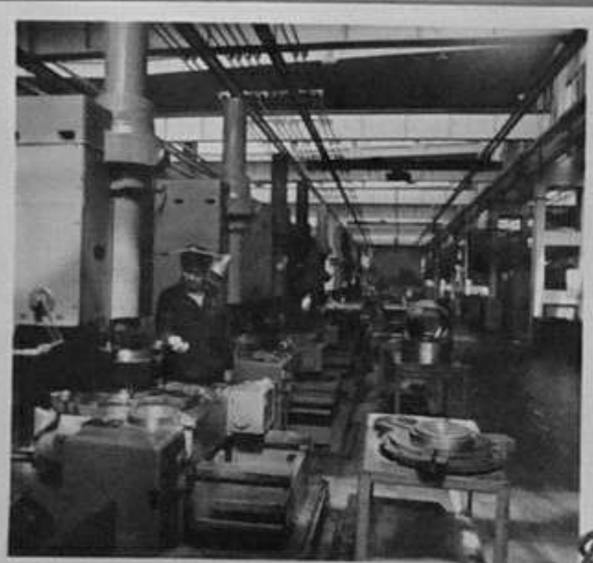
73-1467-8-Поточна линия за обработка корпуса на редукторите за електротелфери. /АН.Цанков/ЕИ
