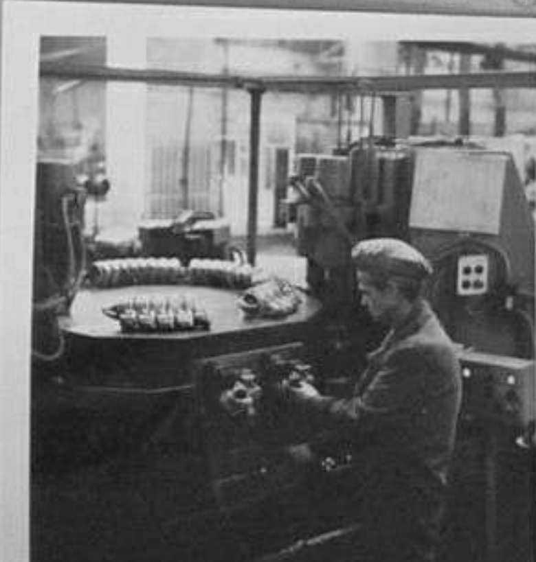
82-1496-9 Агрегатчикът Г. Димитров извършва обработ- ка на преден щит за авто- матичен стартер Е.Любомиров/МД
