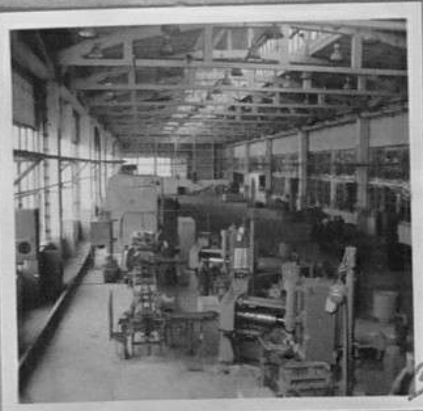
74-798-3-Поточна линия за производство на електроди. /Н.Хлебарова/ТК
