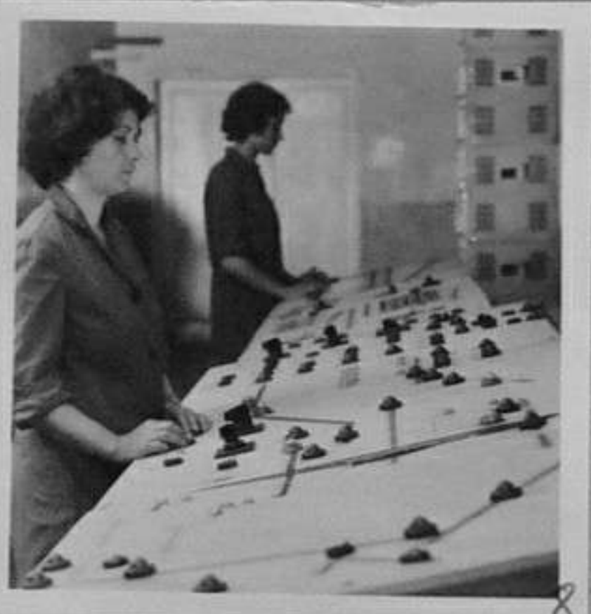
83-826-8 Командна зала за транспортиране и подготовка на формовъч- на смес Е.Любомиров/МД
