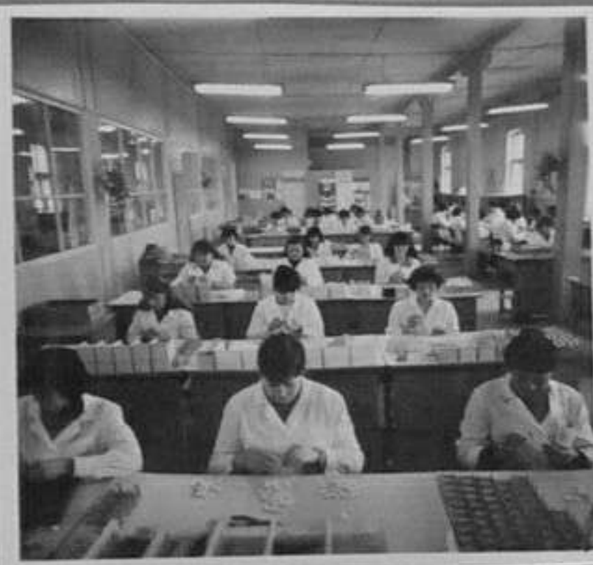
83-540-9,11 Младежният колектив "Любен Дочев" от участък 4Монтаж"към цех "Строителен механизъм" монтират двойно тарифен броятелен механизъм. М.Георгиева/ВЛ
