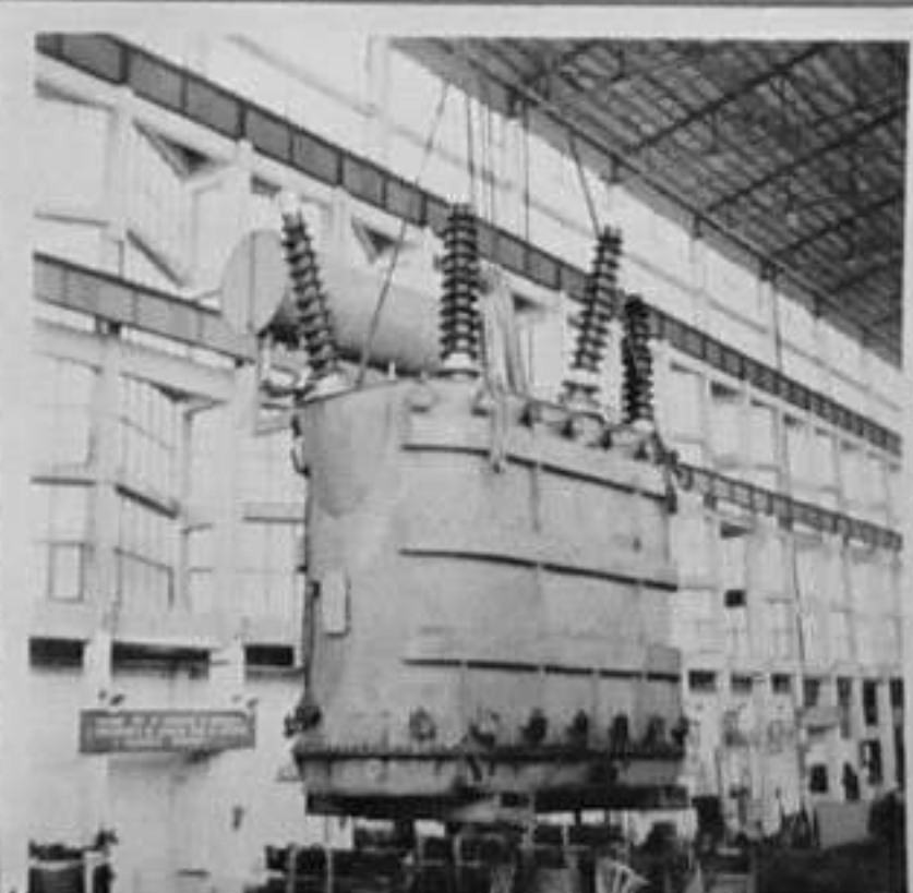
10-Трансформатор 12000 KVA по време на монтаж.
