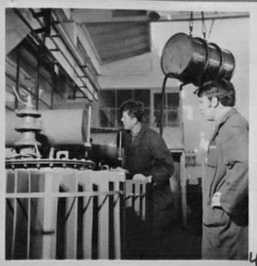
71-6371-4-Монтаж на трансформатори. /Л.Чаръкчиев/ИК
