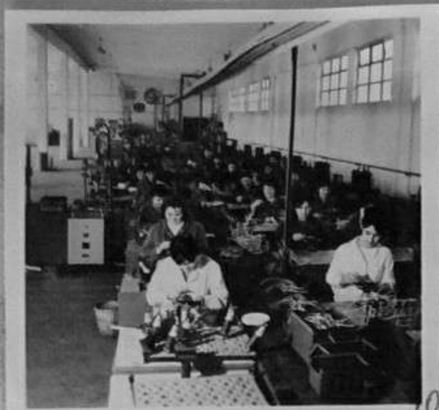
72-5534-10, 13-В цеха за бобиниране на котви и статури за шлифовални машини Ш-178. /Л. Чаръкчиев/ИК
