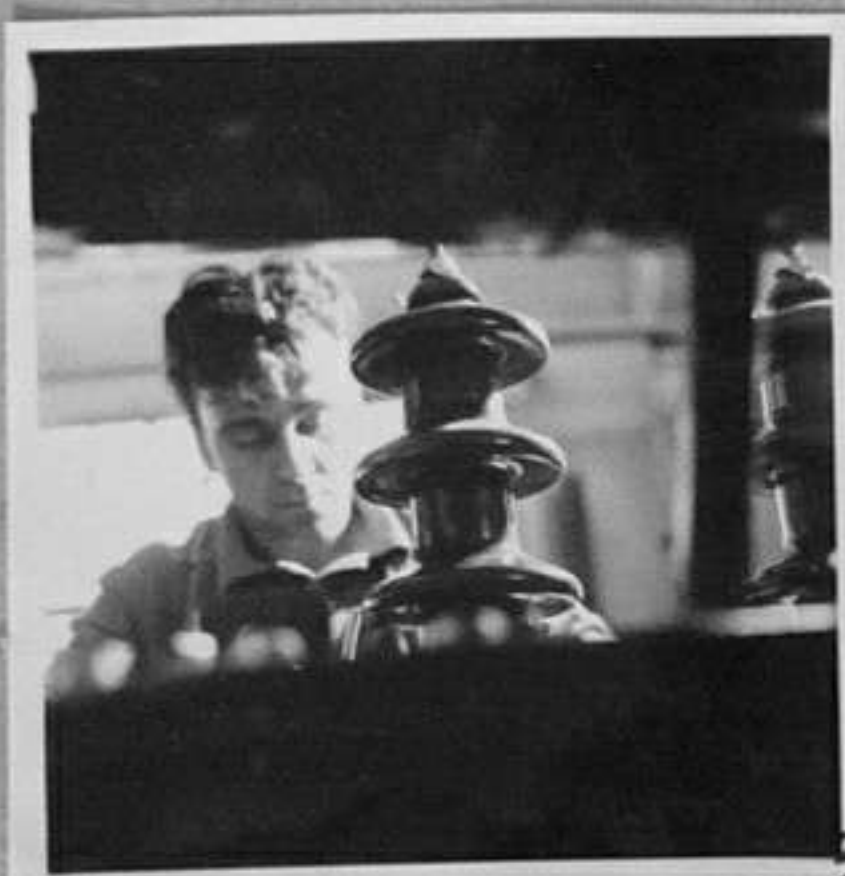
71-6371-3-Монтиране на трансформатори, 250 кВ ампера. /Л.Чаръкчиев/ИК
