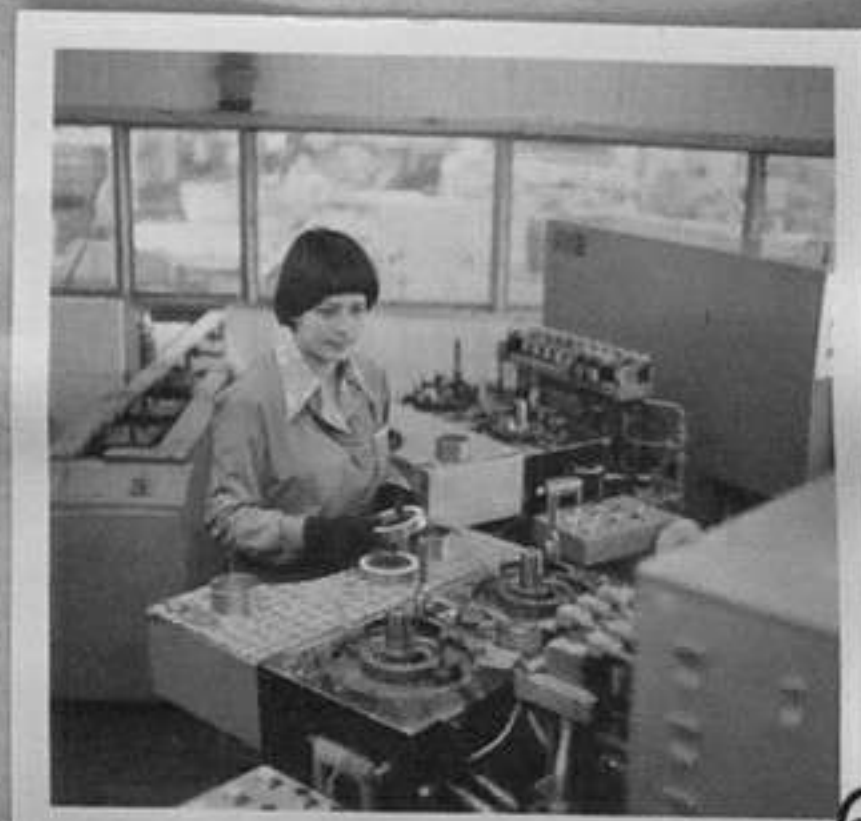
77-1811-6 Цех за монтаж на генератори - автоматична линия за бубиниране на статорен пакет Кр. Узунова/МД
