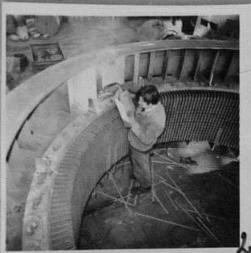
80-530-2 Изработване на статер за "ВСД-325-49/16" за СССР Н.Генов/МД
