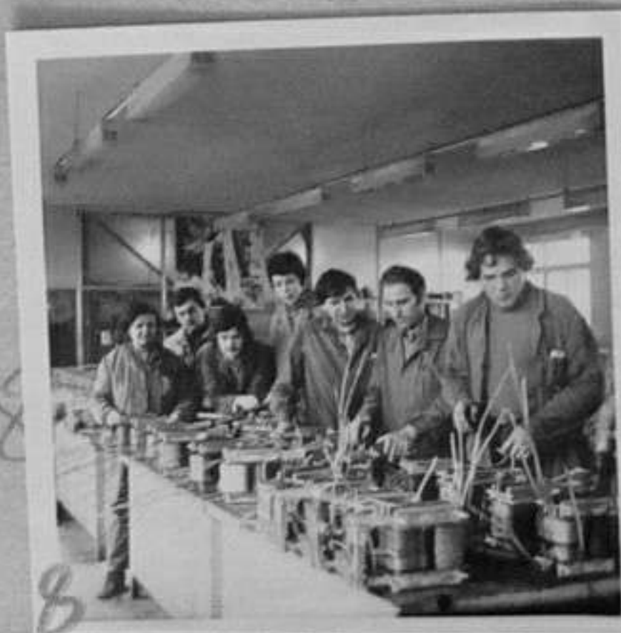
80-778-8-Бригадата на Божко Стоянов монтира трансформатори.
