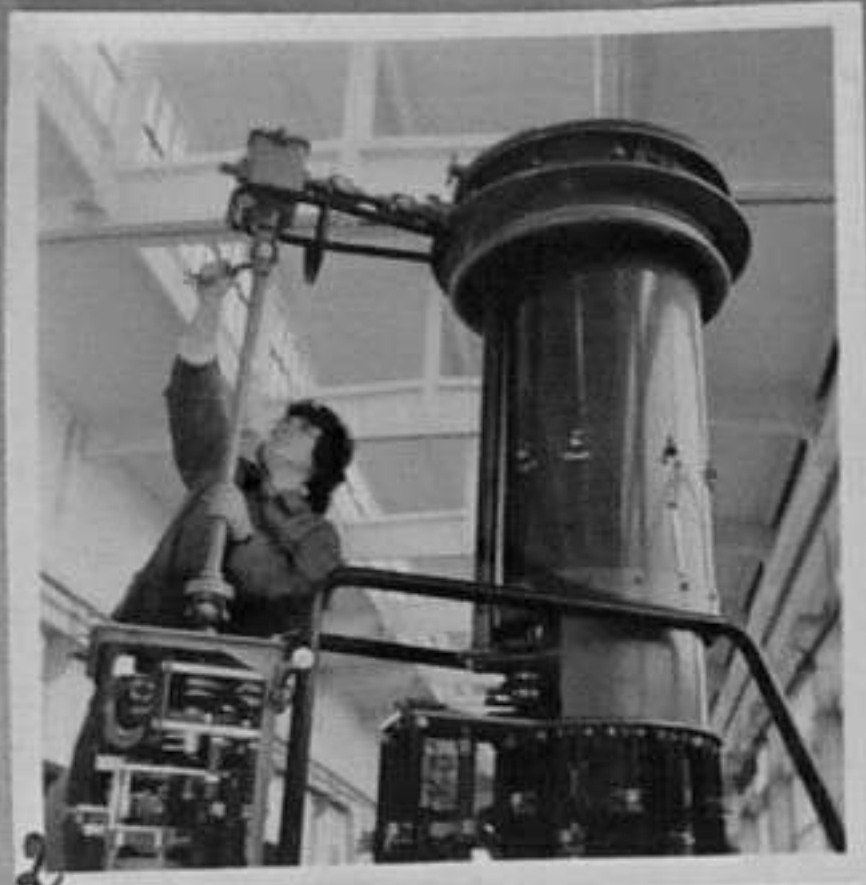
2-Стълбален регулатор-110 кв. Производство за износ в Румъния.
