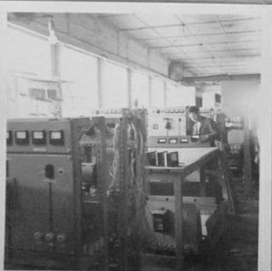
68-1700-3-Работник монтира измервателни уреди към КРУ /компл.разпредел. устройства/. /Йордан Асенов/ СС
