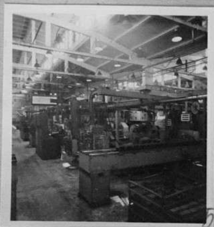
83-762-5 Автоматична линия за обработка на тяло на елмотор Е. Любомиров/МД
