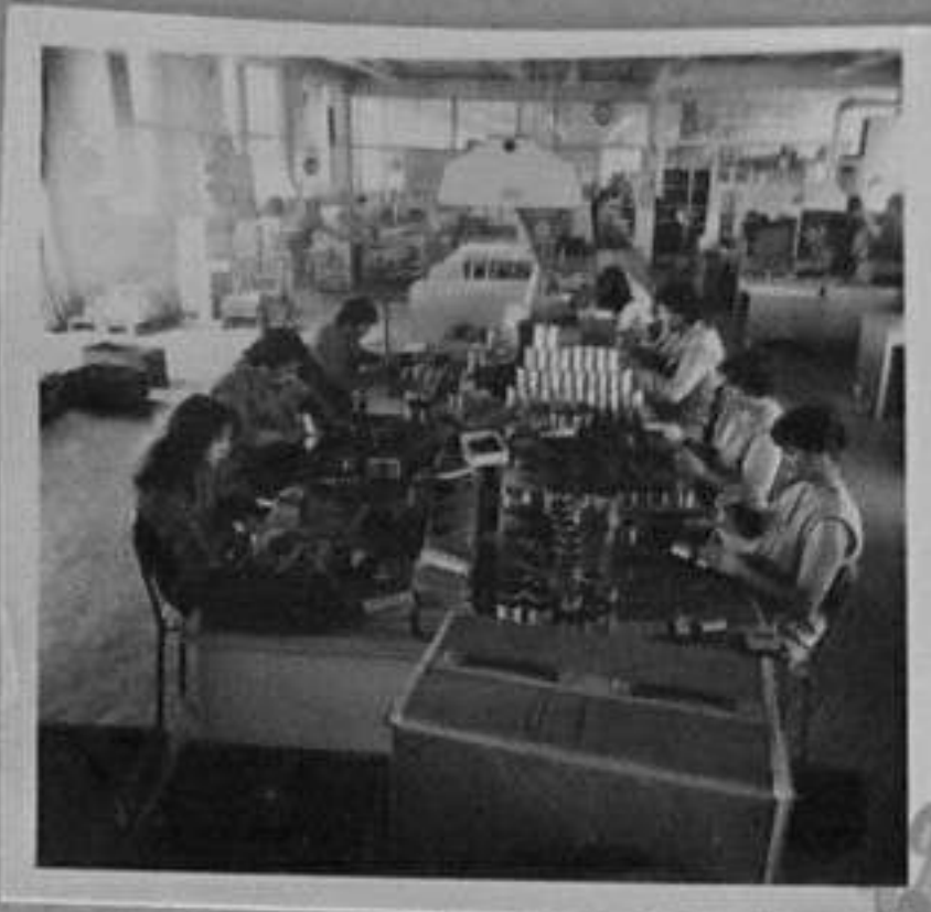
81-2255-12-Бригада "А. Леонов", първенец по монтаж надвигатели. Ем. Богоев/АШ
