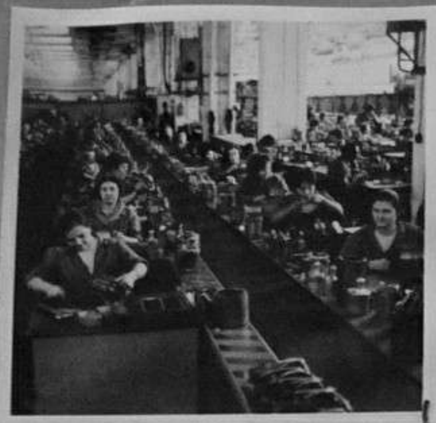
70-4187-1-Общ изглед от монтажния цех. /Л.Златков/ XII
