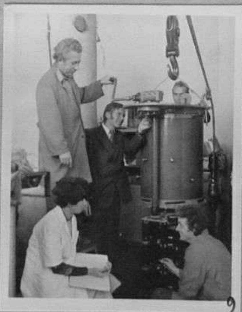
77-2969-9 В изпитателната станция на завода за трансформатори извършват проверка на стъпални регулатори
