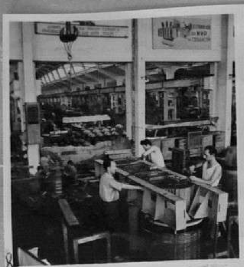
54/1443-8-Стахановска бригада на Иван Чанов работят трансформатор от 1500 KVV. /Халачев/ ММ
