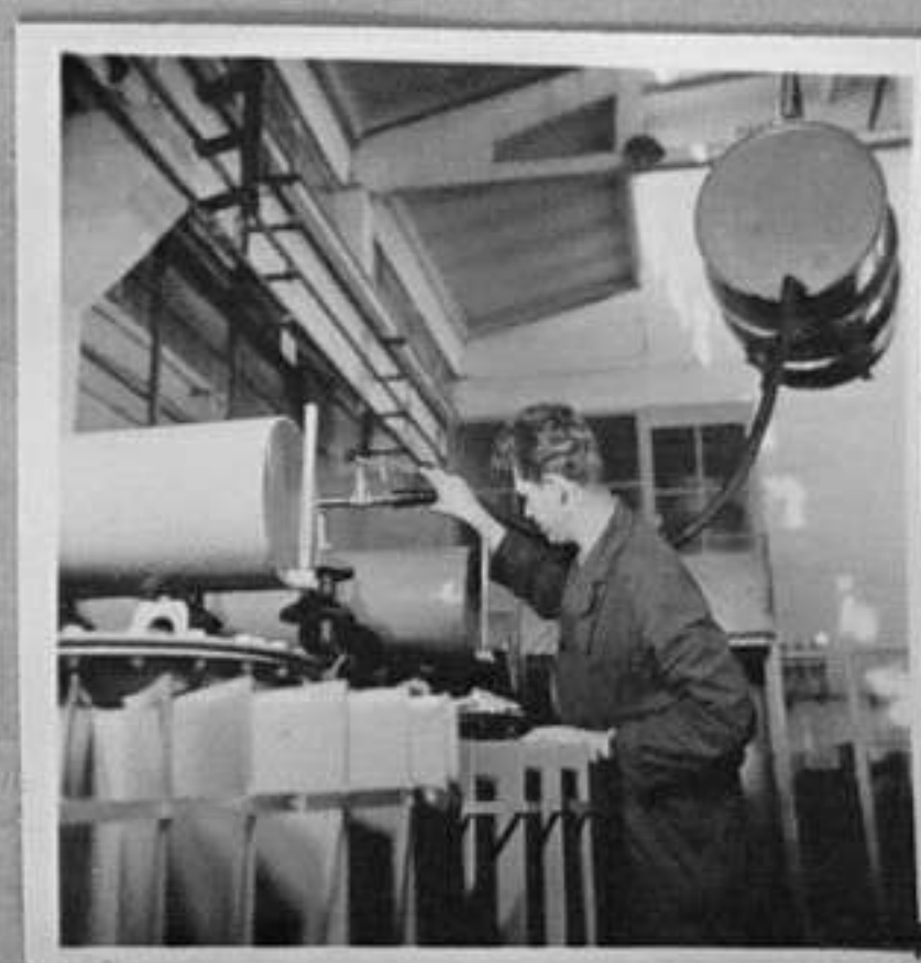
71-6371-5-Монтиране на трансформатори. /Л.Чаръкчиев/ИК
