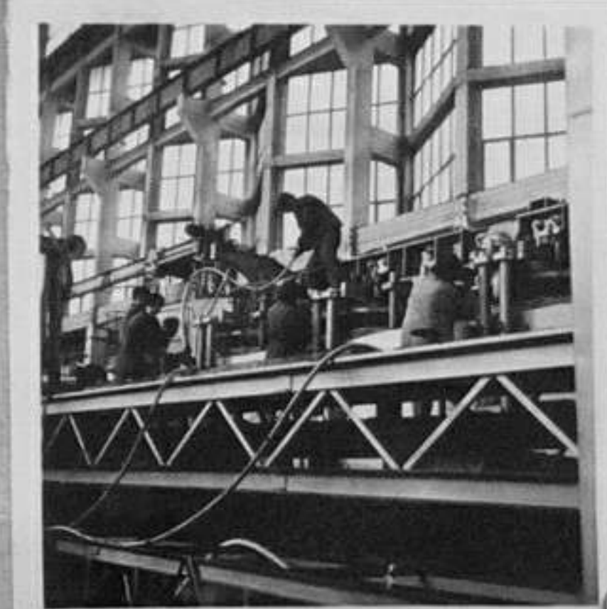
6 - Монтаж на бобина за силов трансформатор 180000 к в.
