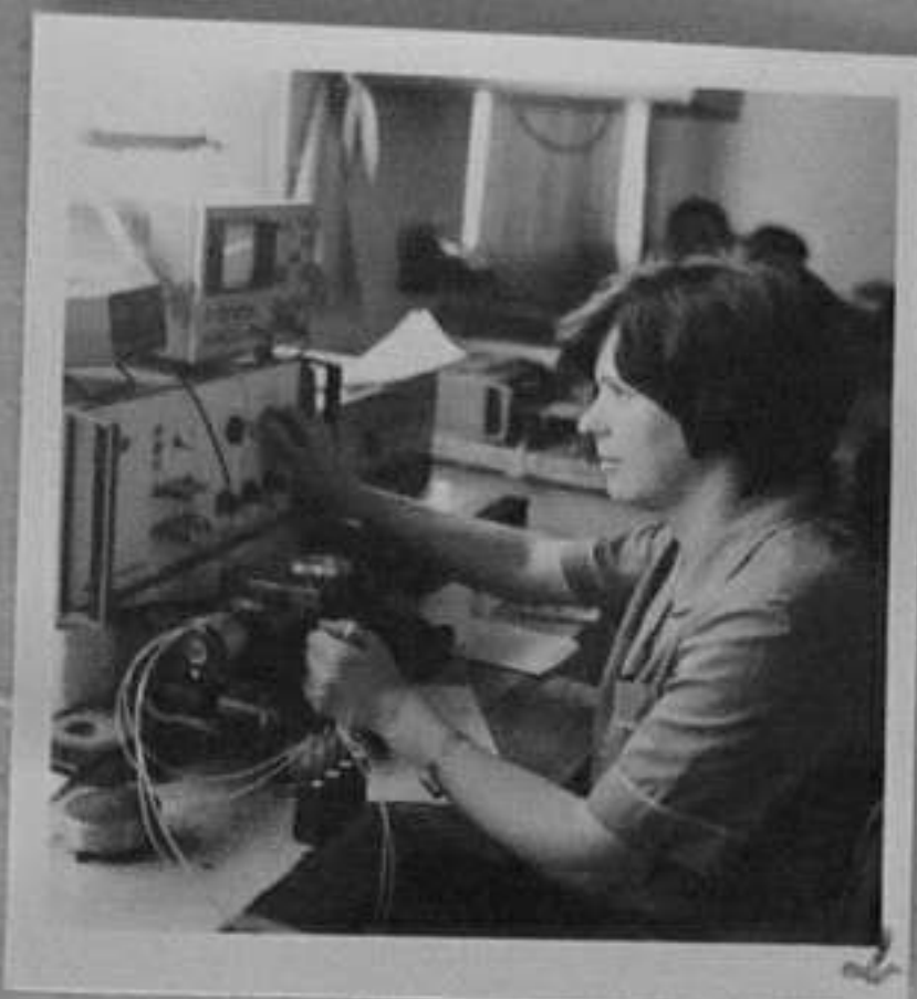
82-1501-2 Величка Васи-лева - изпитател, изпитва електрическите параметри на двигатели ПИВТ-3А Е. Любомиров/МД
