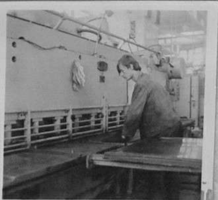
71-4470-6,10-Разкроечен участък - преси и гилотини за разкроявка на материала.
