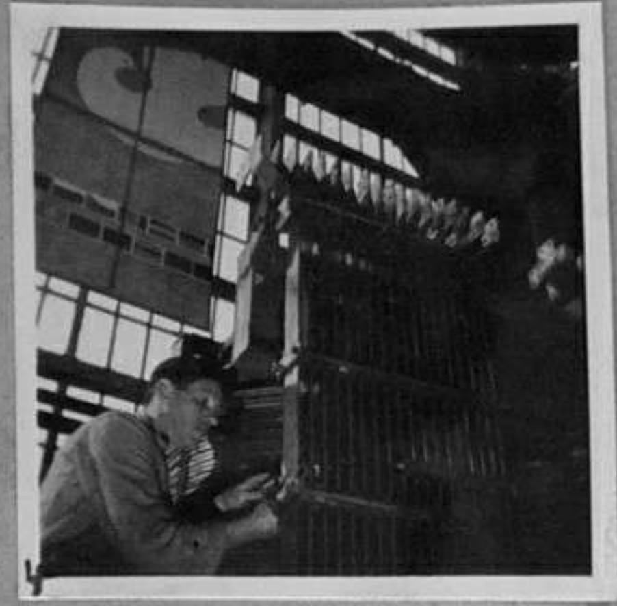
5-Производство на трансформатори 12500 KVA за износ в Сирия.
