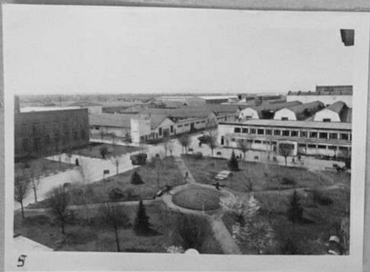
64/826-5-Общ изглед на завода. /Иорданов/ ММ 9/12
