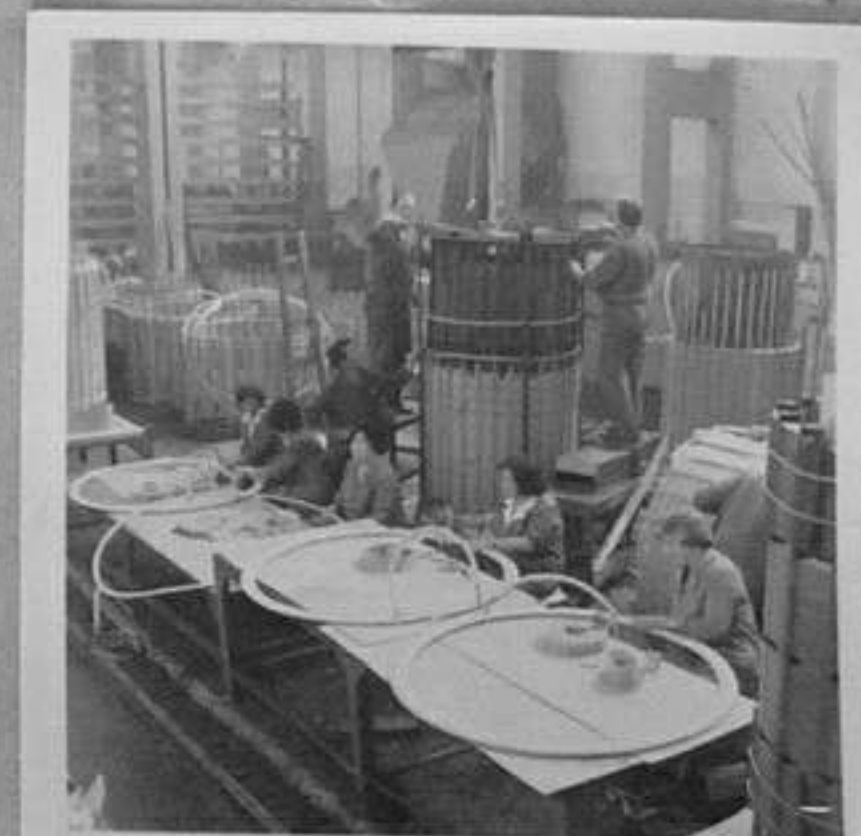
77-2051-12 Бобинажен цех - изработка на високоволтови трансформатори
