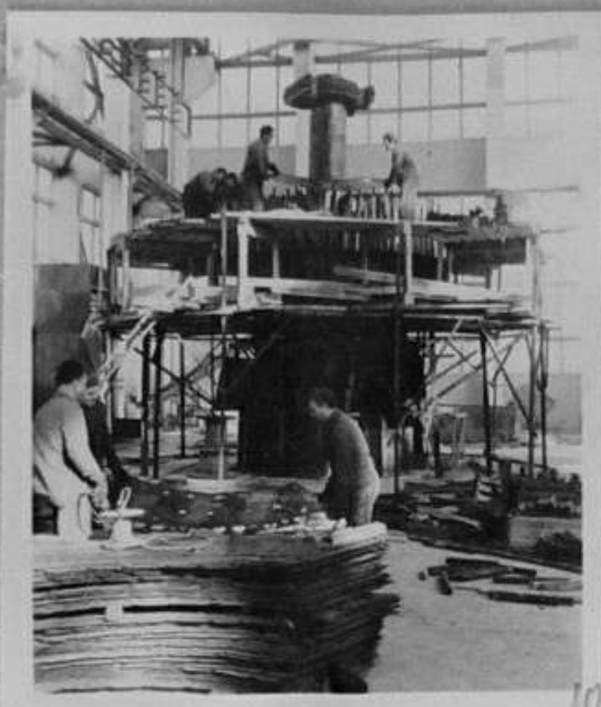
72-5511-10 - Монтаж на първия 60 мегаватов статор за ВЕЦ "Момина клисура". /Е.Любомиров/ЕИ
