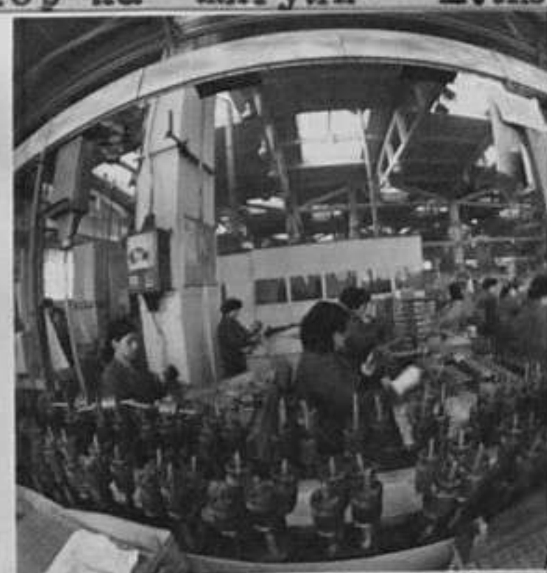
78-1114-6 Конвейерът за ротори на лека кола "Жигули" Е.Любомиров/МД
