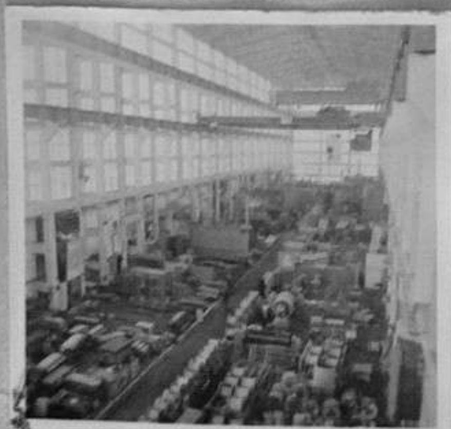
9-Монтажната зала на завода.
