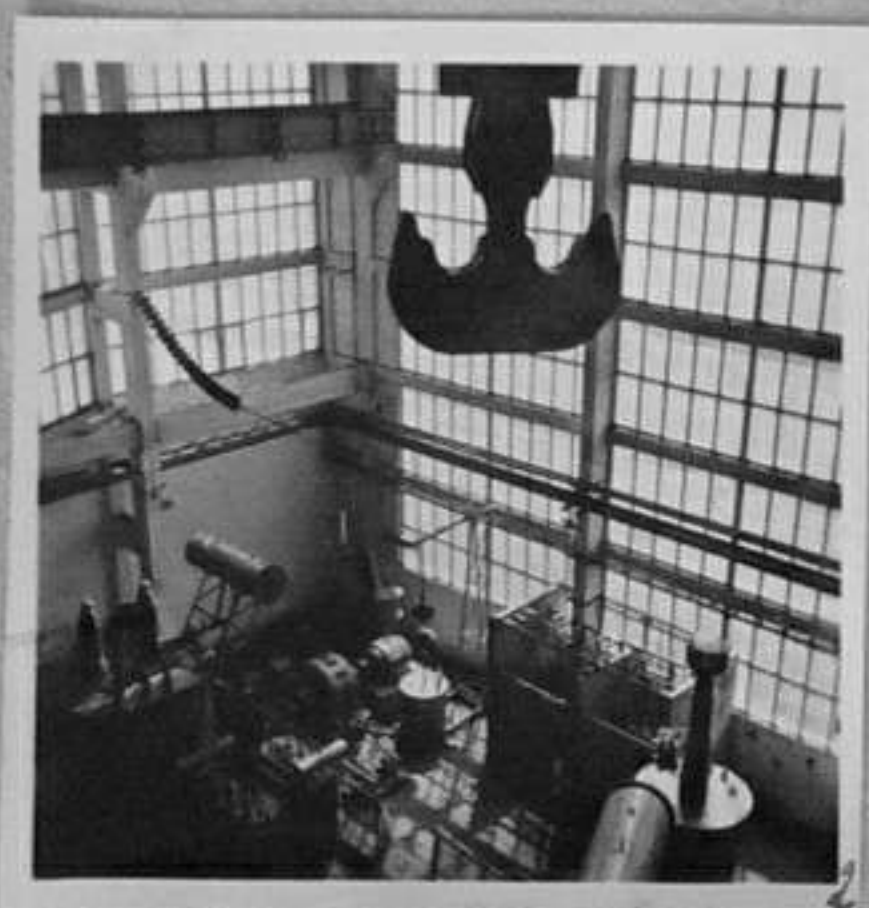
2-Пронизителният ъгъл на трансформат. цех-изпитателен пункт.
