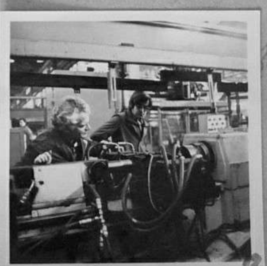
80-4070-11,12 Автоматична технологич. линия за обработка на валове за електродвигатели с капацитет 100 хиляди годишно. Цялата технологична линия ще се обслужва от 4 човека Г.Чакърян/МД
