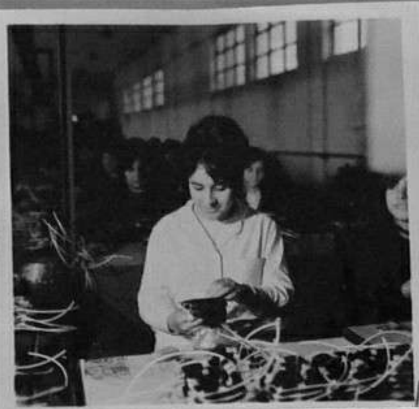
72-5534-10, 13-В цеха за бобиниране на котви и статури за шлифовални машини Ш-178. /Л. Чаръкчиев/ИК
