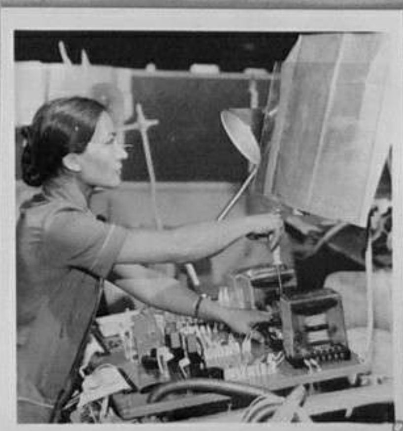
83-1424-8-Ив. Василева, елмонтър, извършва вто- рична комутация на комплек- сно разпределително ус- тройство. В.Балевска/ЛШ
