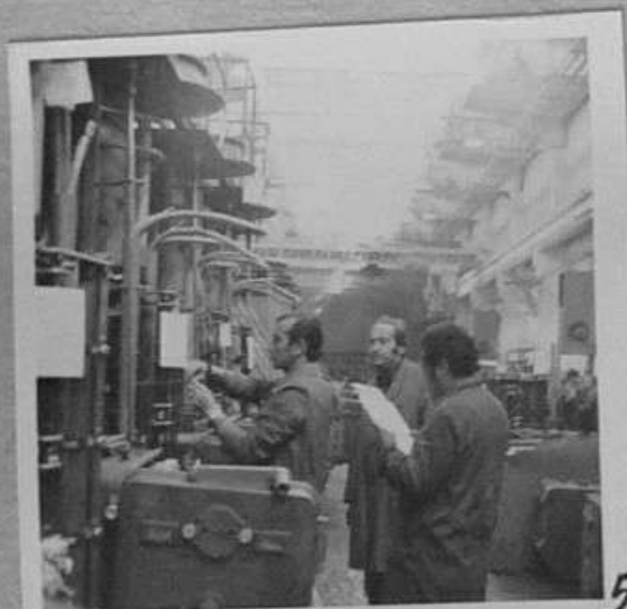
77-3205-5 Инж. Константин Коцев по време на механични изпита- ния на стъпални регулатори Кр. Узунова/МД
