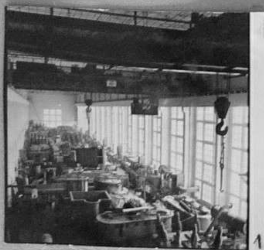
1-Цех за трансформатори.
