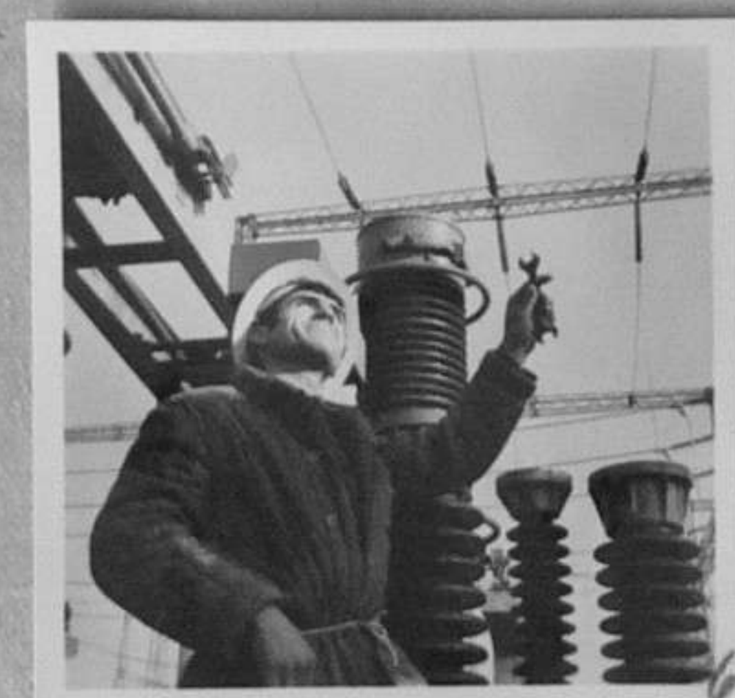
71-669-6,7,8-Монтиране на ножови разпределители на подстанцията "Мизия" към далекопровода "Дружба". /Л.Златков/ ХП
