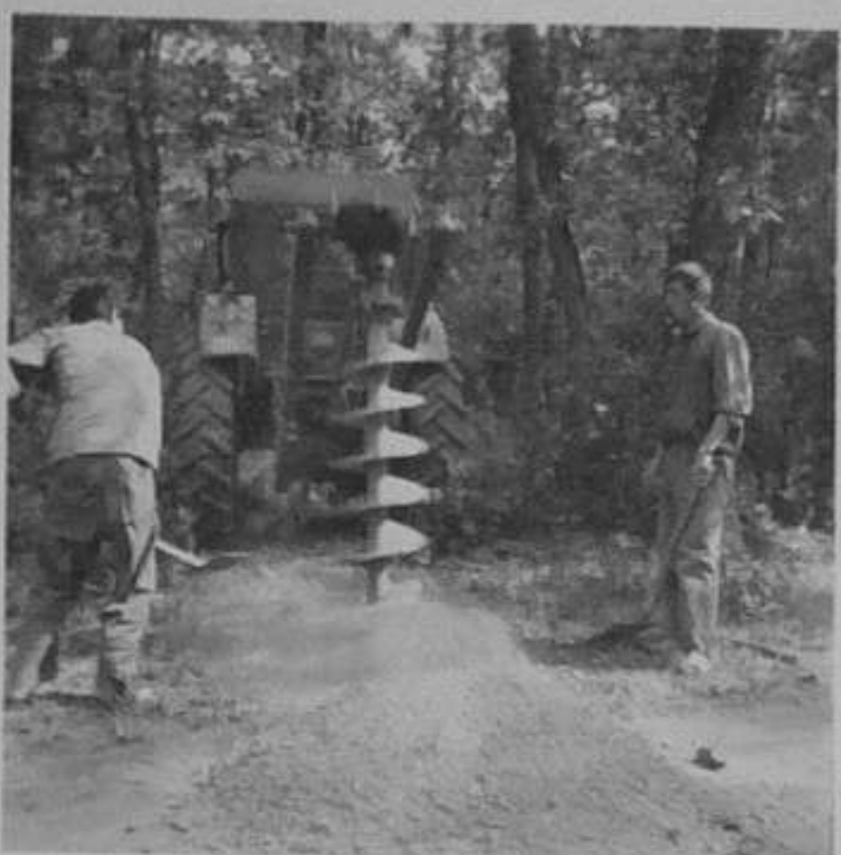
68-2382-2,11-Пробиване на дупки за поставяне на ел.стълбове от бригада при "Елмонтаж-Исперих". /Селиктар/ XII
