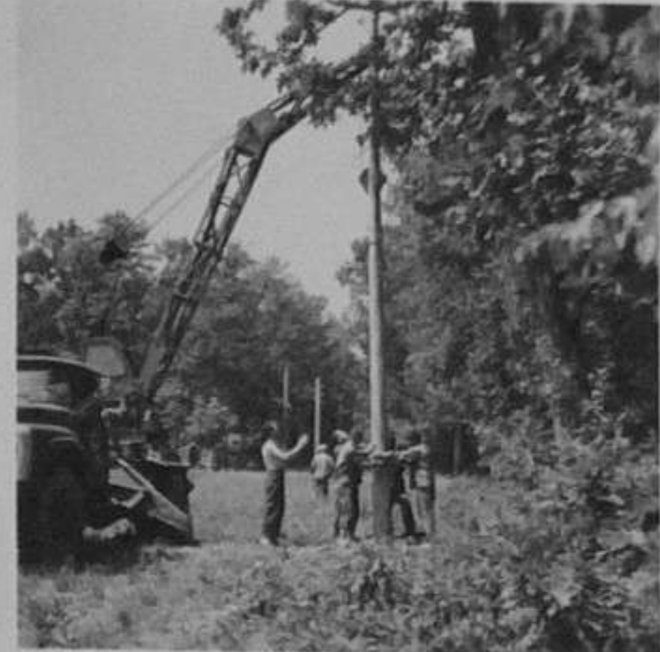
68-2382-2,11-Пробиване на дупки за поставяне на ел.стълбове от бригада при "Елмонтаж-Исперих". /Селиктар/ XII
