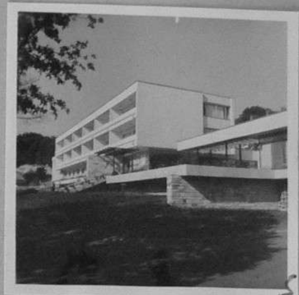
72-4209-5-Изглед от подстанцията. /Е.Богоев/МК
