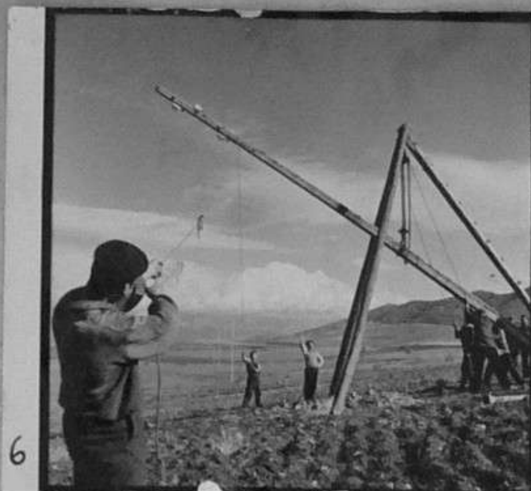
56/3169-6,7 - Доставка железобетонни стълбове за електропровод до помпена станция в Петричкия окръг. /Караджанов/ ММ
