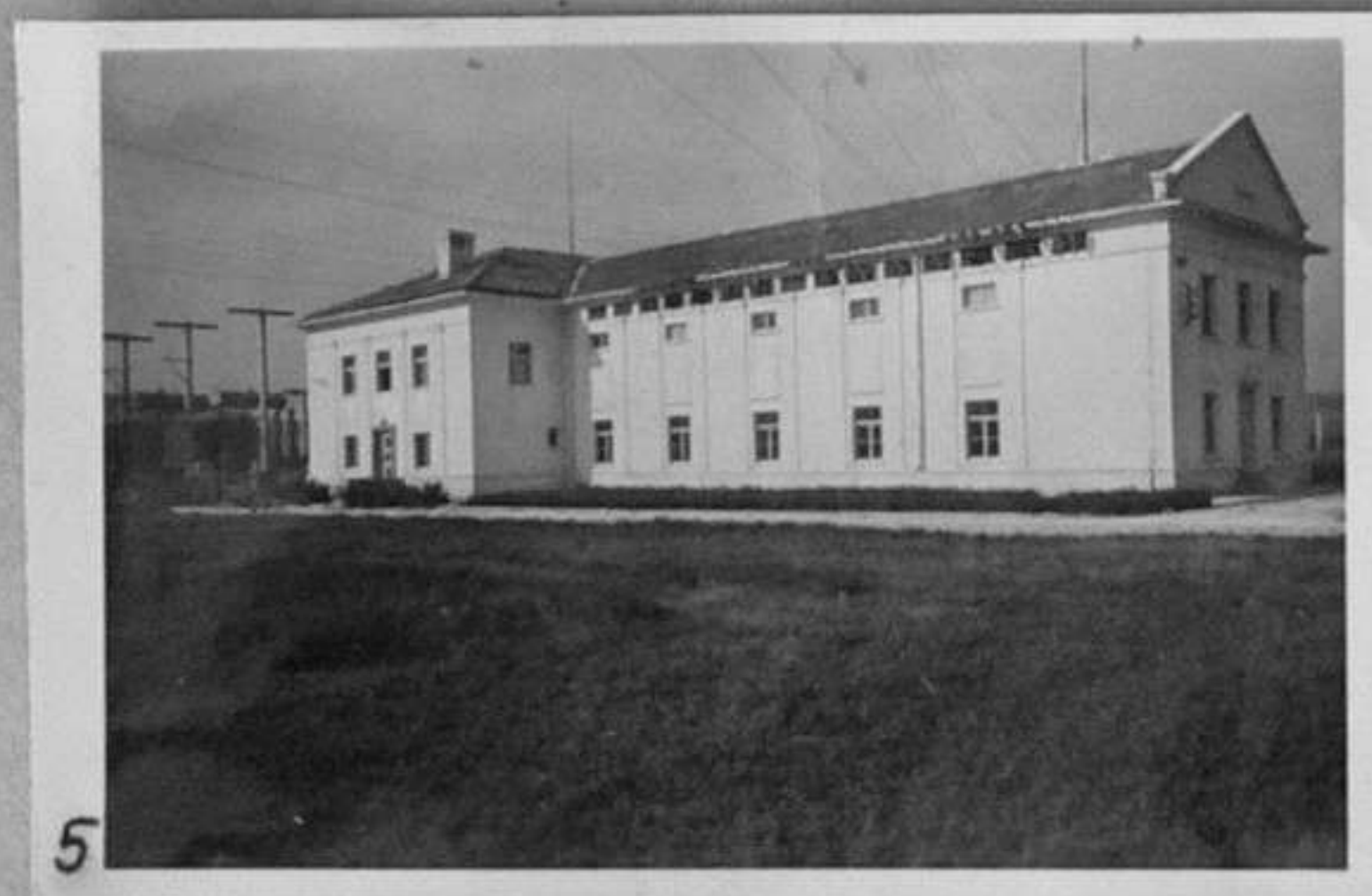
57/3303-5 - Подстанция "Девня". /Рангелов/
