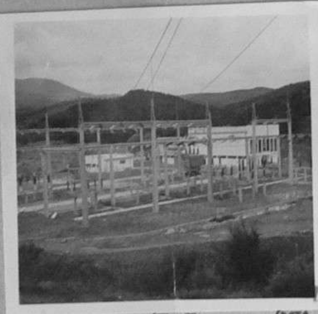
/Е.Богоев/МК 72-4204-12-Подстанцията с откритата уредба.
