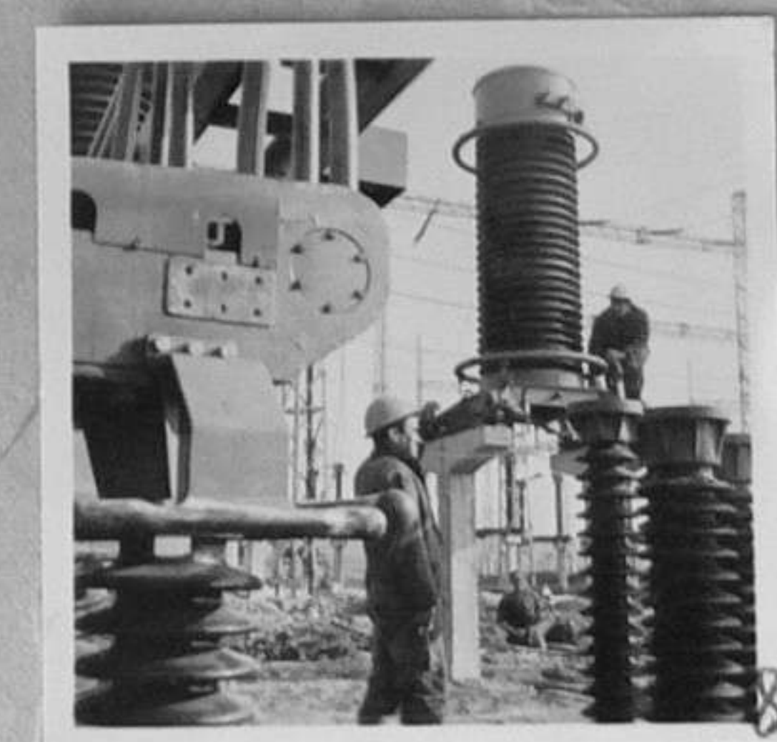
71-669-6,7,8-Монтиране на ножови разпределители на подстанцията "Мизия" към далекопровода "Дружба". /Л.Златков/ ХП
