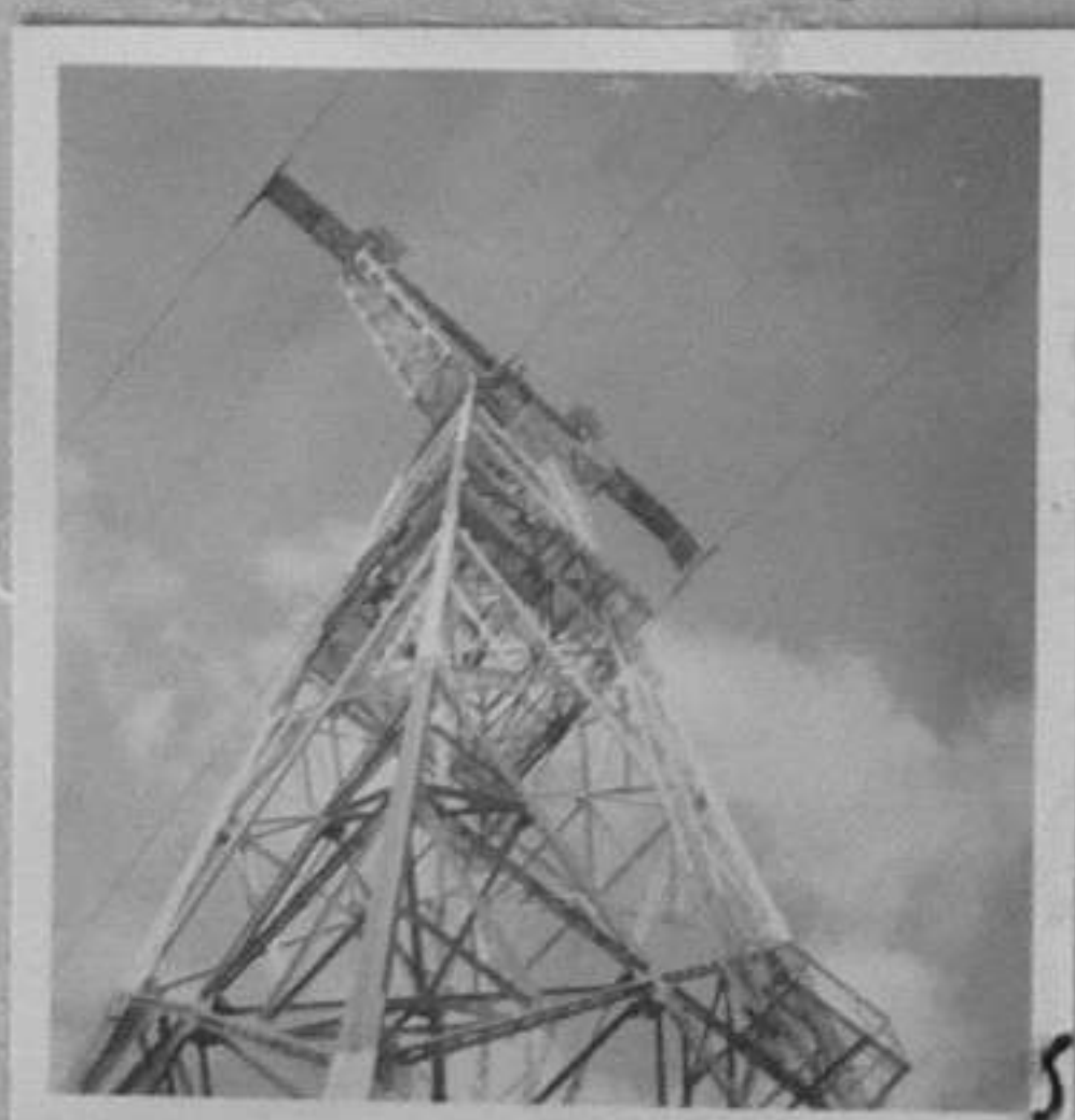
68-4669-5-Електрически стълб от далекопровода Румъния-България. /З.Минчева/ ХП
