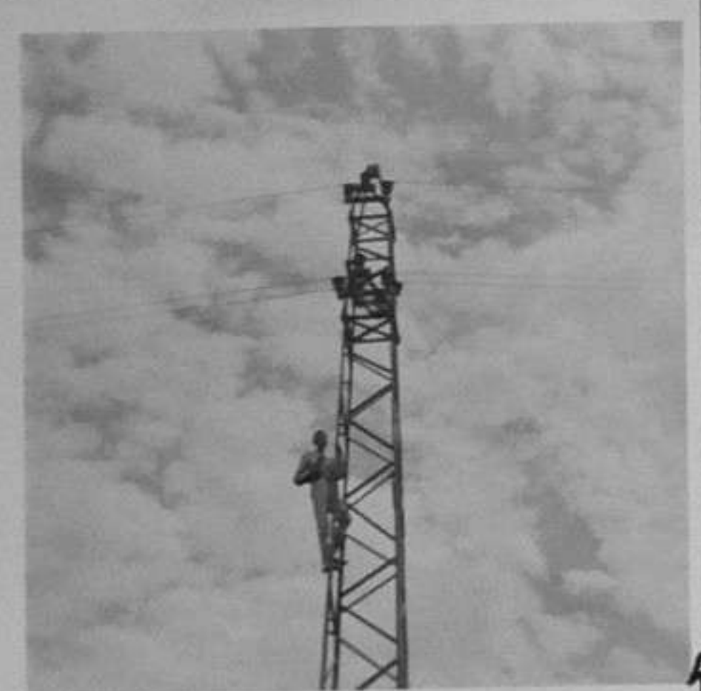
68-3918-5-Понтон на електропроводници - Пернишки окръг. /Г.Бурмов/ XII
