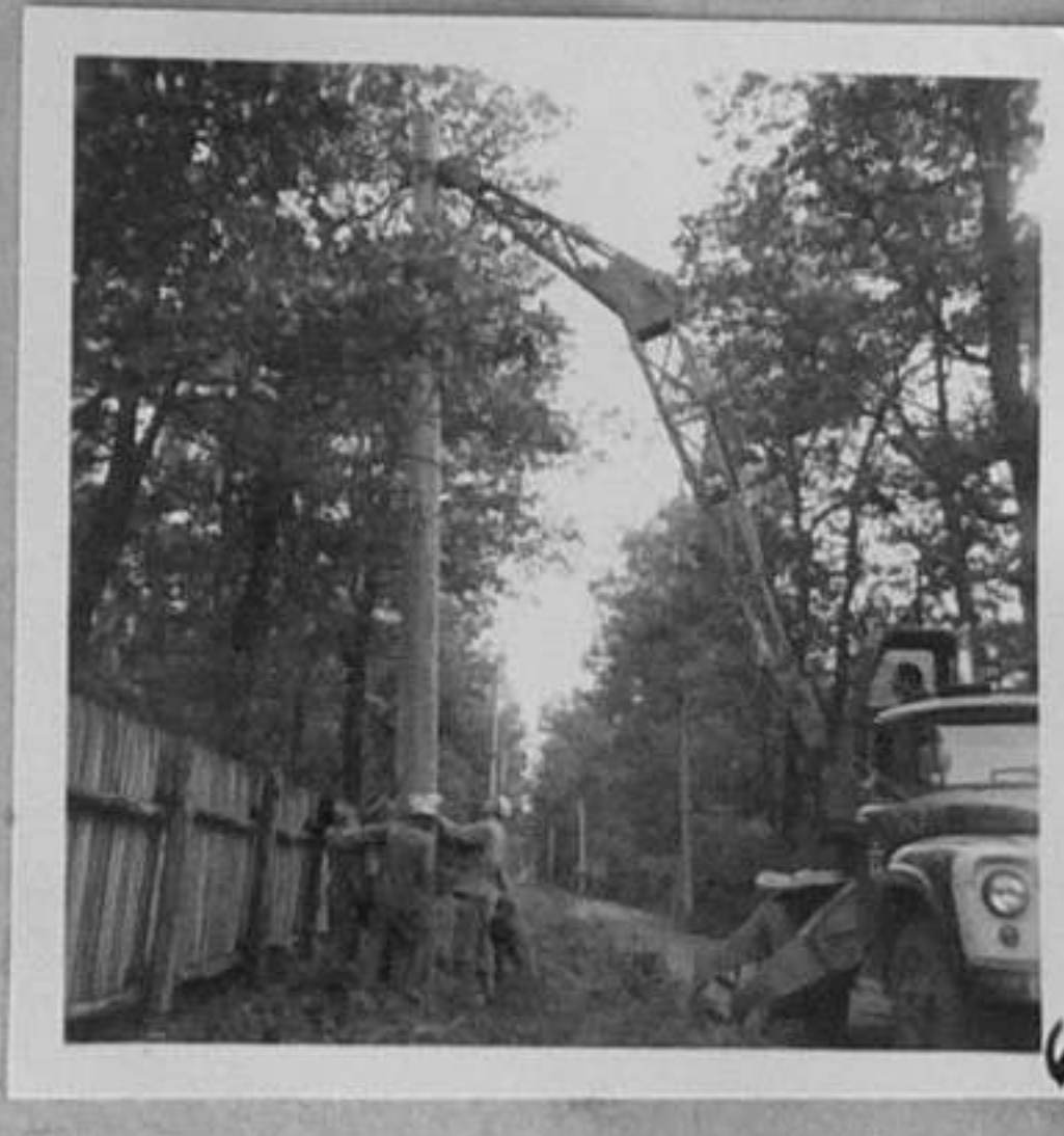
68-2380-1,5,6-Механизирано поставяне на електрически стълбове от електромонтажната при "Елмонт-Исперих" - Разградски окръг. /Е. Селиктар/ ХП
