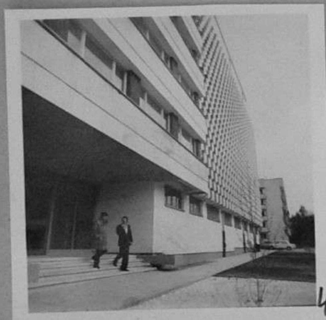
77-1024-4 Подстанция "Възраждане" външен вид А.Бояджиева/МД
