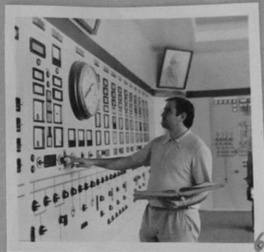
72-4861-6-Табло за полуавто- матично командване трансфор- матор 401. /Е.Богоев/МК
