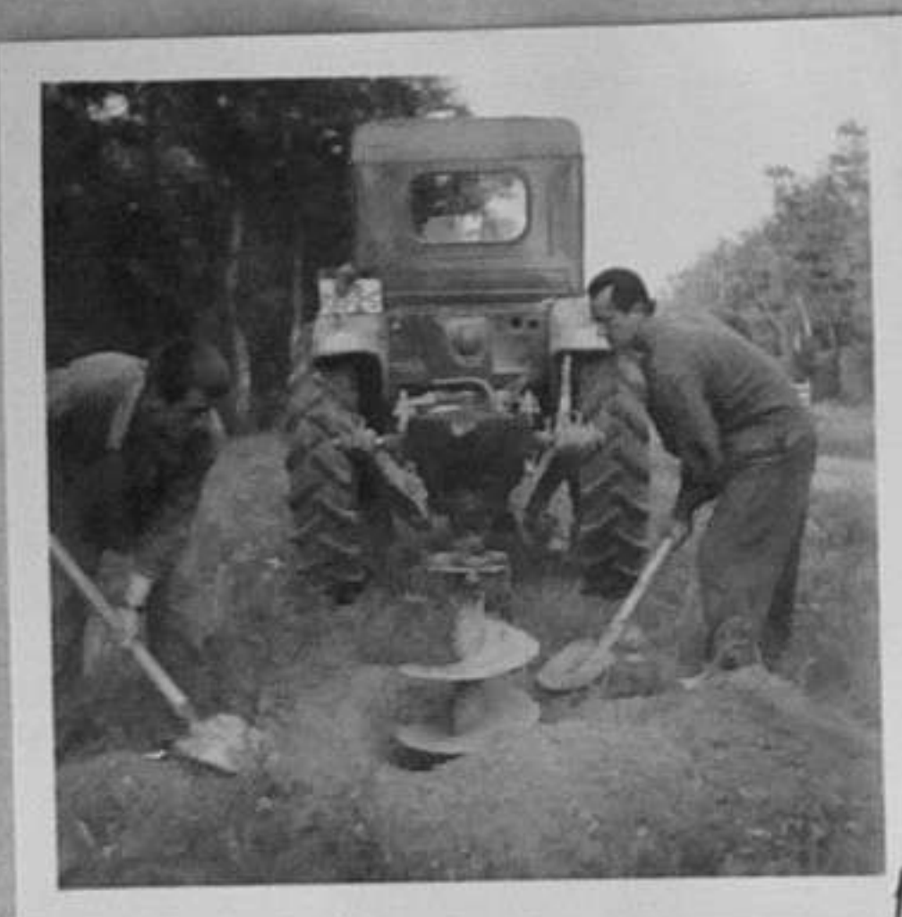
68-2380-1,5,6-Механизирано поставяне на електрически стълбове от електромонтажната при "Елмонт-Исперих" - Разградски окръг. /Е. Селиктар/ ХП
