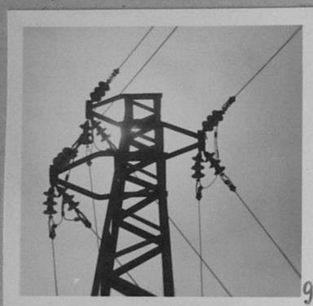
71-669-9-Монтиране на ножови разпределители на подстанцията "Мизия" към далекопровода "Дружба". /Л.Златков/ ХП
