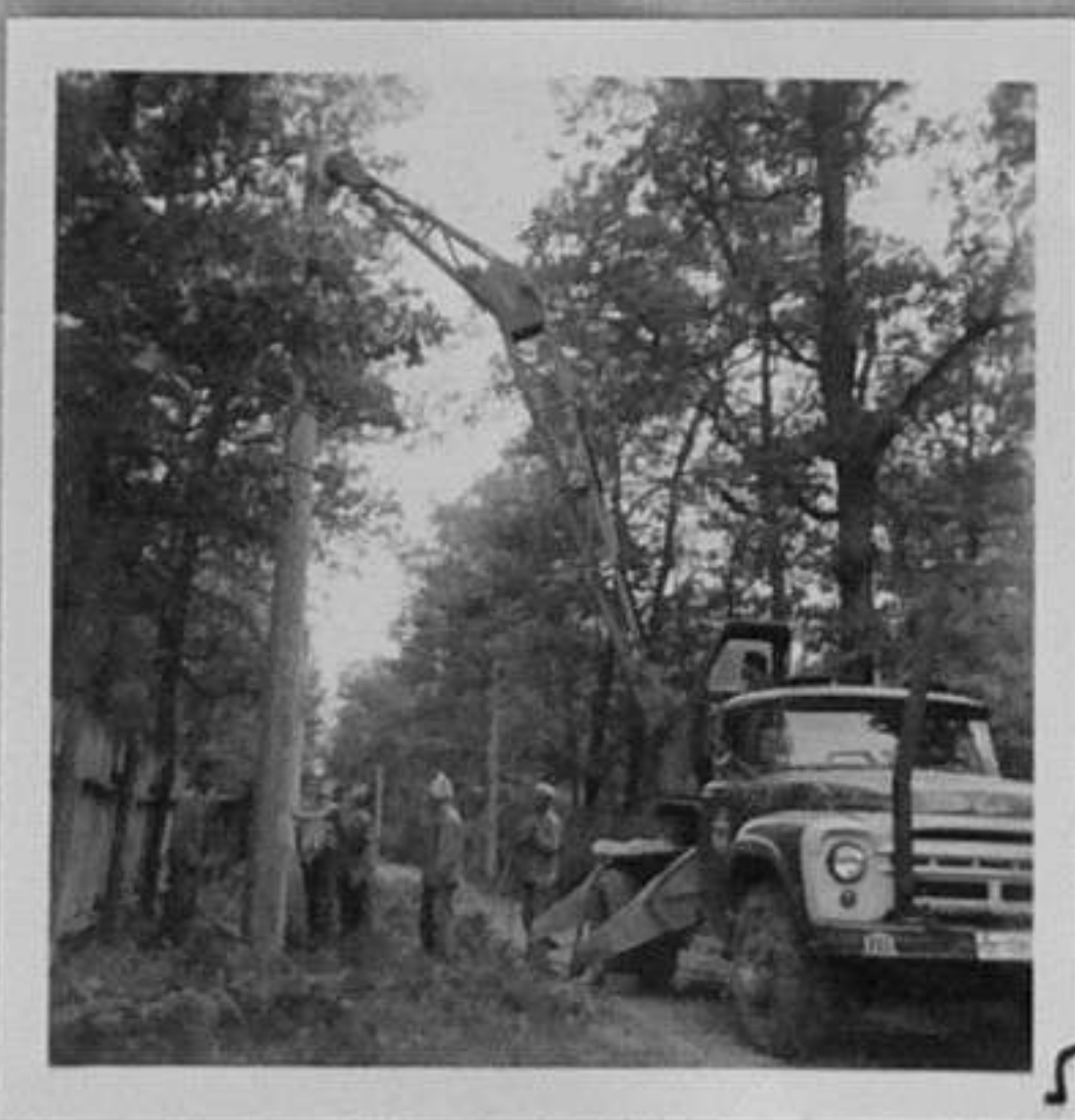
68-2380-1,5,6-Механизирано поставяне на електрически стълбове от електромонтажната при "Елмонт-Исперих" - Разградски окръг. /Е. Селиктар/ ХП
