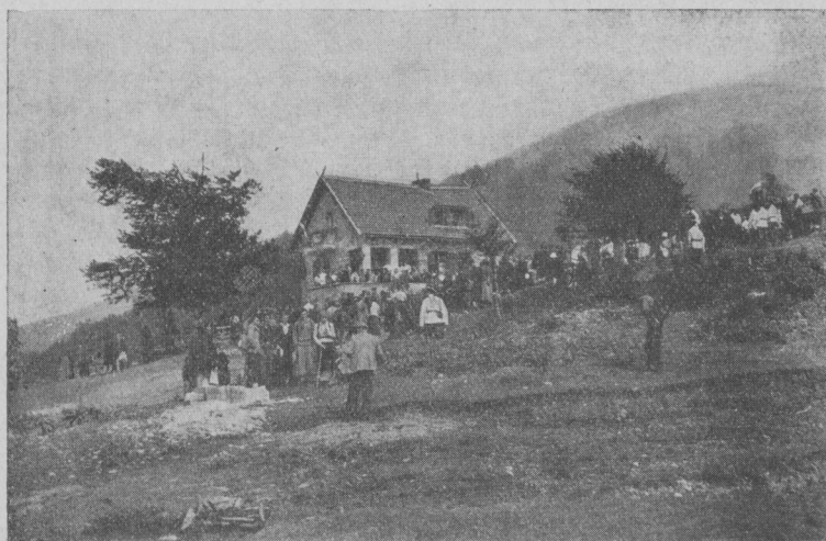
Освѣщаване на хижата „Бузлуджа“
