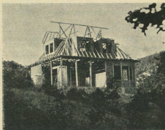
Строещата се хижа „Оборище“ — Срдѣдна гора.
